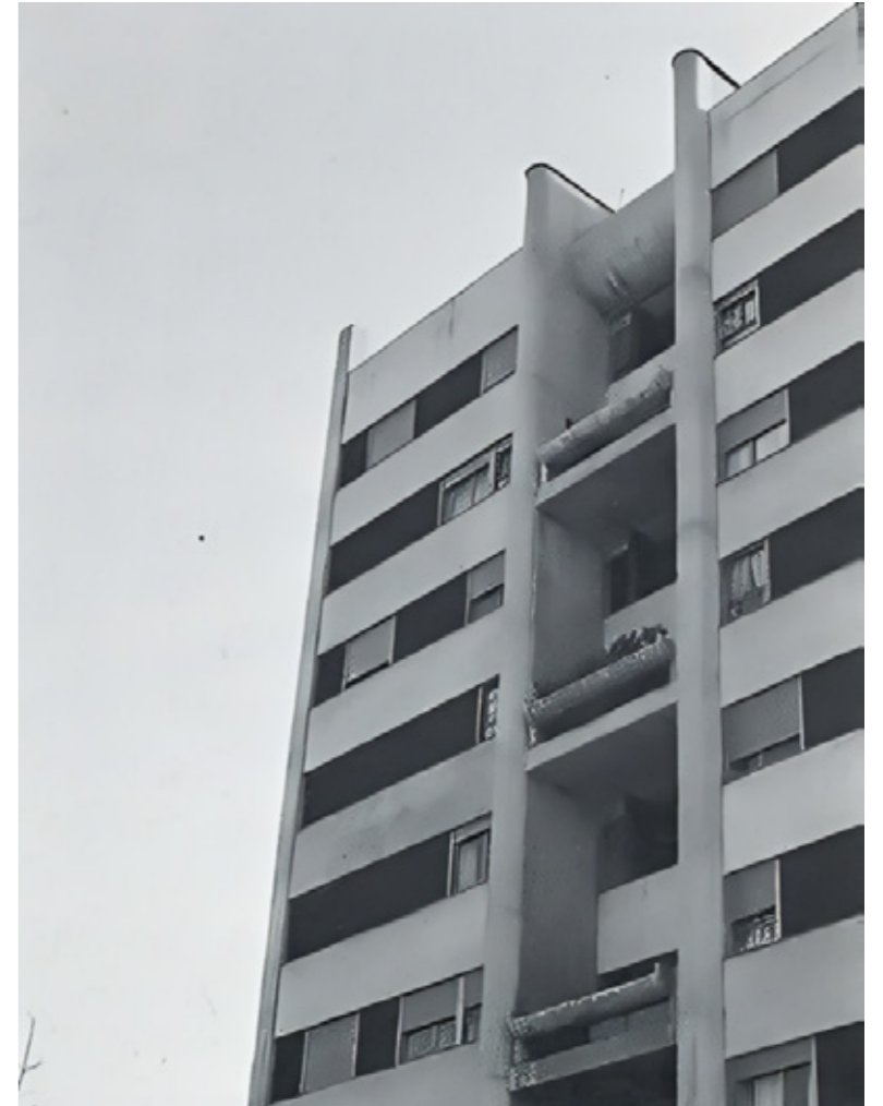
2.19 Dettaglio facciata torri, anni '70
