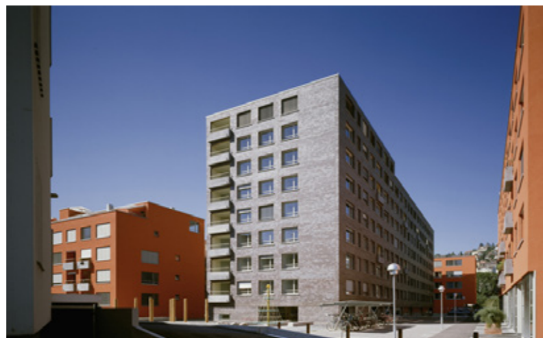
3.28 Vista dell'insediamento Kraftwerk1 Hardturm, Reinhard Zimmermann
