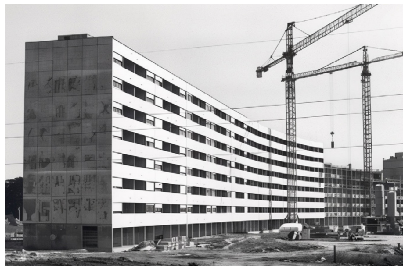
2.21 Virgolone in fase di costruzione, anni ‘70
