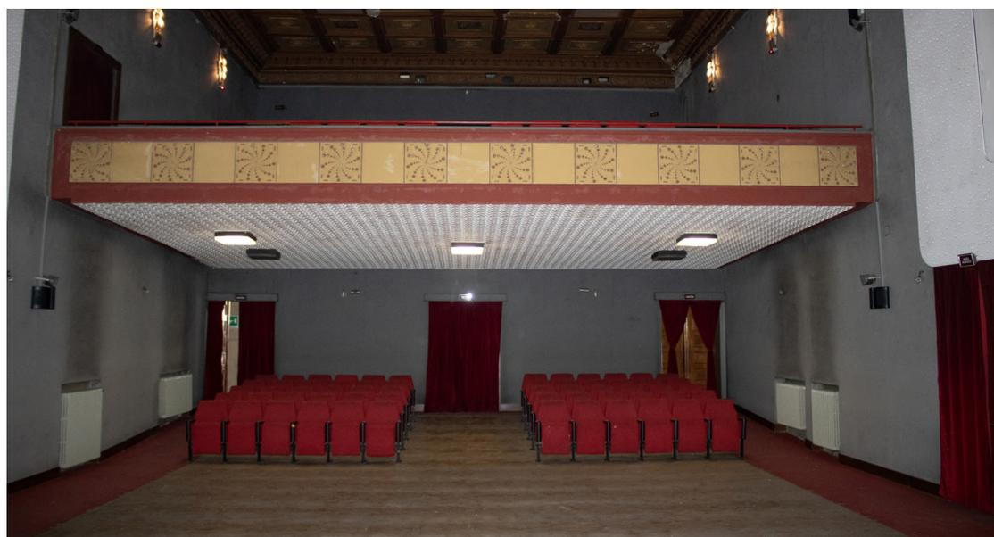
Fig.102: Galleria al primo piano a sbalzo in cemento armato
