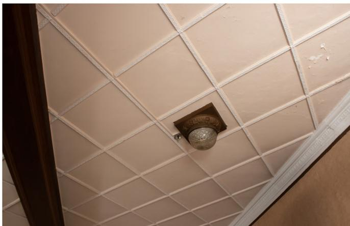
Fig. 107: Soffitto nell'atrio del piano terra decorato con un motivo ad incrocio realizzato con stucco
