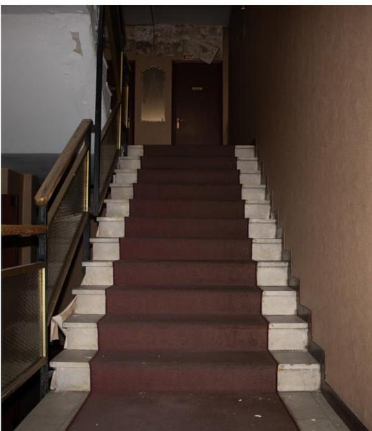
Fig. 130 (a sinistra): Scala con ringhiera in ferro e vetro con corrimano in legno. Le scale sono rivestite in marmo.
