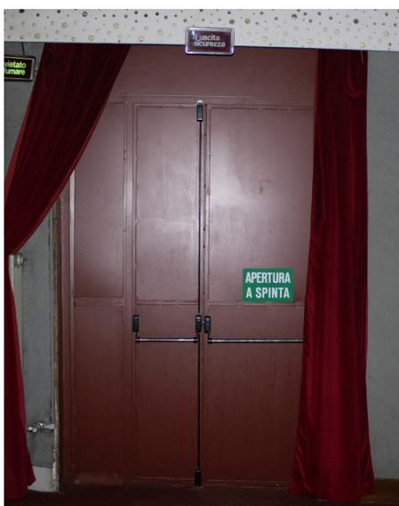
Figg. 123,124,125,126, 127, 128: Finestra laterale al primo piano/ Porta in ferro che porta alla cabina di proiezione/ Vetrata in ferro e vetro opaco con vetri superiori apribili/ Vetrata in ferro e vetro opaco con vetri superiori apribili/ Dettaglio porta in legno pieno a doppio battente/ Porta taglia fuoco con maniglione antipanico nella sala cinematografica
