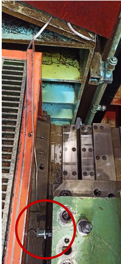
Figura 4.2.2 nuova posizione sensore vibrazione
