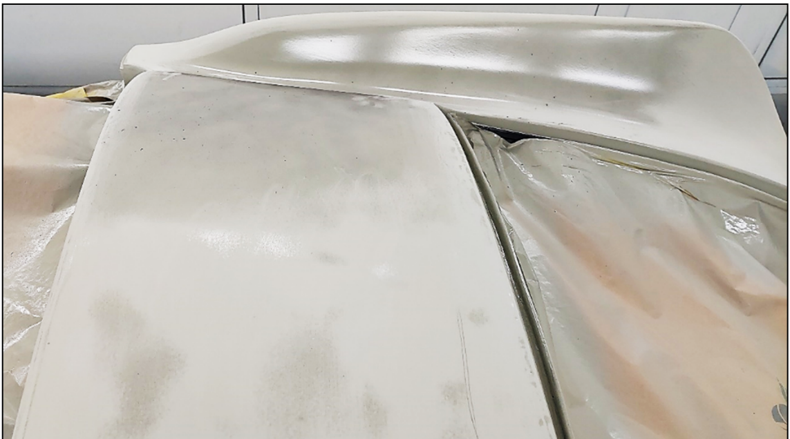
Figura 7.10. Carteggiatura del primer epossidico: si notano le zone già carteggiate (chiare e opache) da quelle ancora che devono ricevere la carteggiatura (scure e lucide). Notare la mascheratura dei vani tramite carta e nastri.
