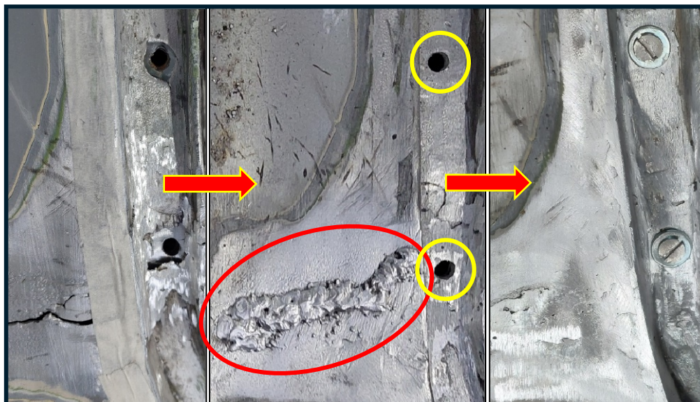
Figura 5.11. A partire da sinistra: piastra di rinforzo che si intravede dai fori della scocca, saldatura della cricca (nell'ovale rosso) e della piastra di rinforzo (nei cerchi gialli, i fori sono già definiti con punta da trapano), riparazione portata a termine e verifica serraggio viti e bulloni.
