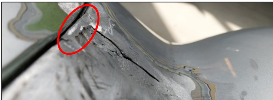
Figura 5.9. Altra prospettiva della cricca e della sua saldatura parziale. Sulla destra il profilo del parafango anteriore destro.
