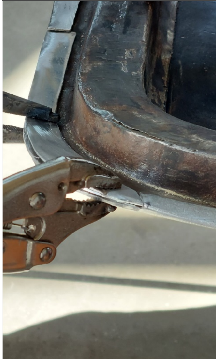
Figura 5.20. Fissaggio dei pezzi da saldare tramite pinze.
