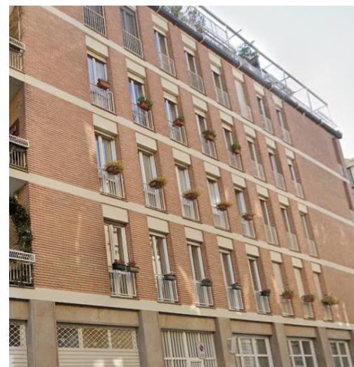
Figura 27 – muratura esterna con rivestimento in materiale lapideo, intonaco e klincker - immagini da rilievo fotografico dell'edificio
