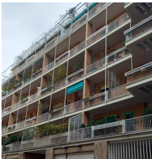
Figura 27 – muratura esterna con rivestimento in materiale lapideo, intonaco e klincker - immagini da rilievo fotografico dell'edificio
