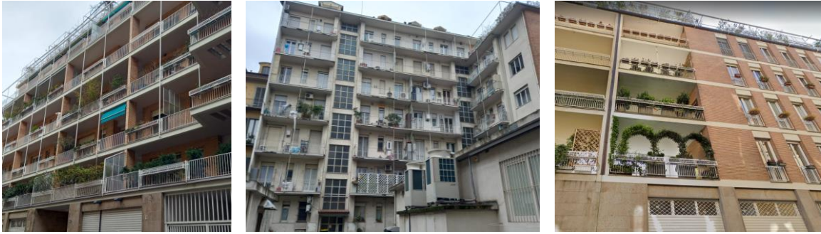
Figura 19 - Balconi continui su via Vela e prospicienti l'interno cortile, logge verso l'edificio adiacente su via Colli– immagini da rilievo fotografico dell'edificio
