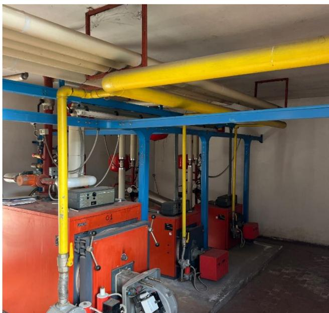
Figura 16 – Caldaie tradizionali a gas Metano
