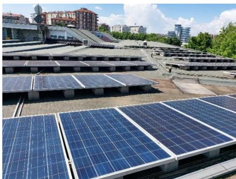
Figura 86 – Posizionamento pannelli fotovoltaici Istituto Sociale
