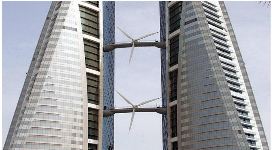
Figura [16]: HAWT montate su un grattacielo, repstatic.it
