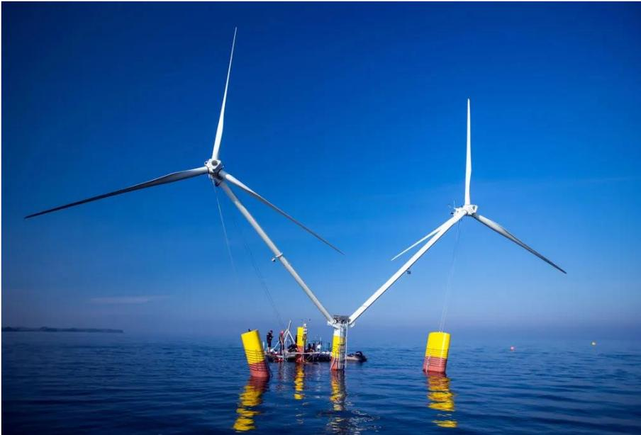
Figura [14]: *HAWT fluttuanti installate in mare,*
