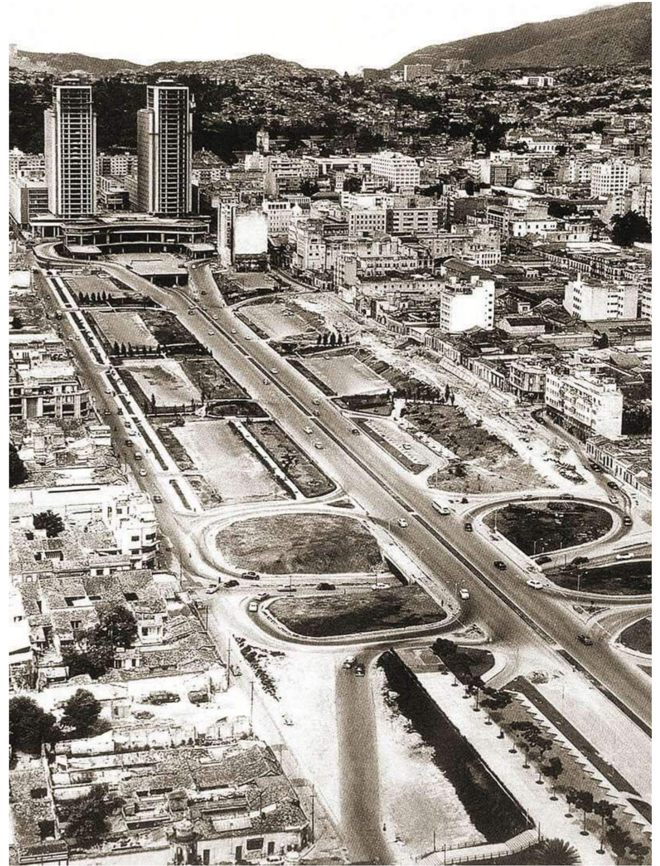
Fig. 55 Avenida Bolívar in 1953. Guía Caracas. https://guiaccs.com/zona-1/
