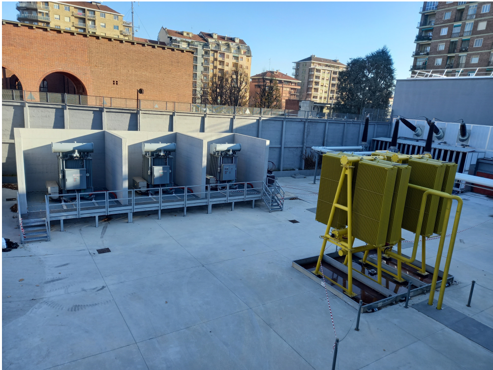
Figura 4.1: Piazzale interno stazione SUD
