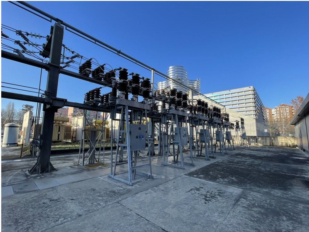
Figura 4.19: Sezione 27kV in aria stazione SUD-OVEST
