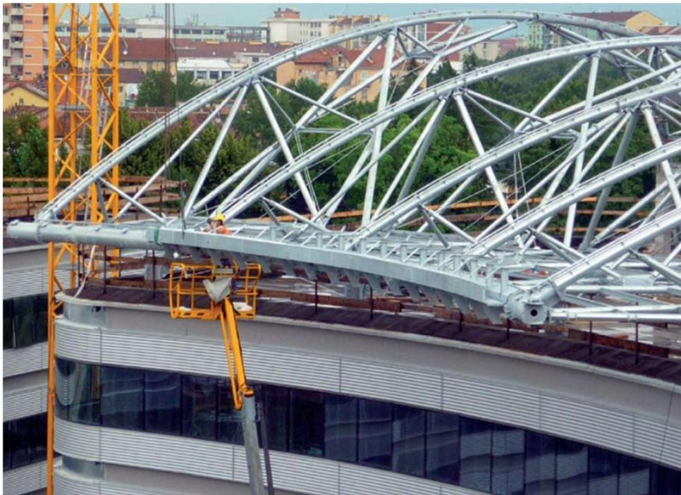
*Figura 12 - Montaggio e posa della trave "bull-nose"*
