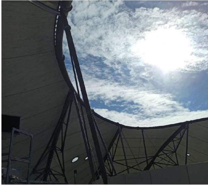
*Figura 32 – Le arcate reticolari spezzate in corrispondenza della toroide ovoidale nel lotto D2*
