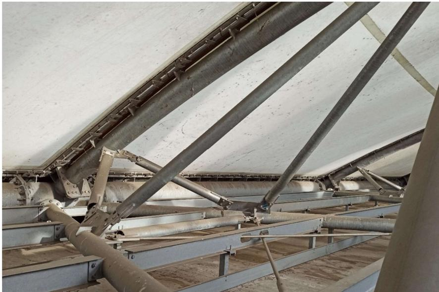
*Figura 72 - Esempio di un vincolo interno a cerniera cilindrica*
