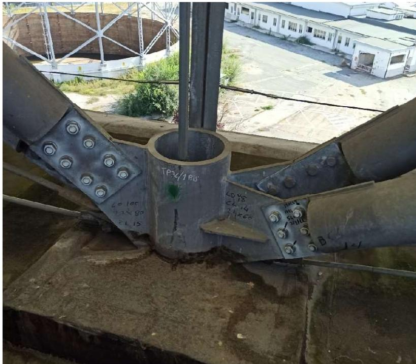
*Figura 29 - Giunto di collegamento tra due arcate reticolari adiacenti*
