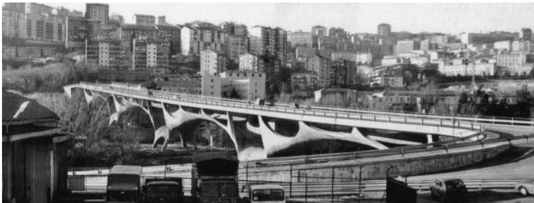
Figura 1: Sergio Musmeci, Ponte sul Basento 1
