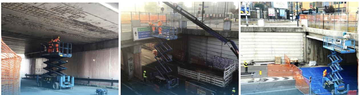
Figura 5-17 Lavori manutenzione impalcato sotto Via Nizza.
