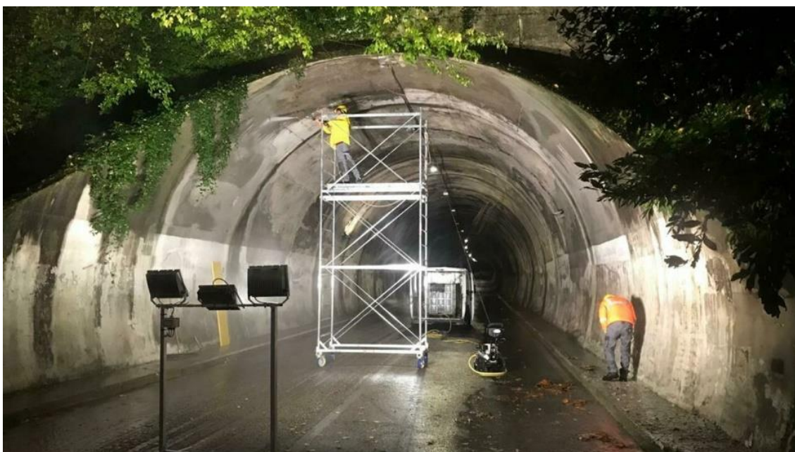
Figura 1-7 Interventi di manutenzione di una galleria con chiusura di entrambi i sensi di circolazione.
