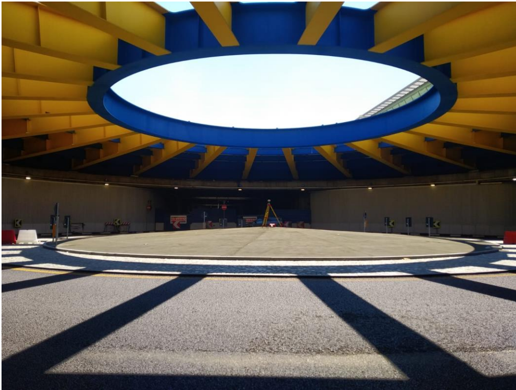
Figura 6-2 Stazionamento con ricevitore GNSS nel vertice "Rotonda" al centro della rotonda del sottopasso Lingotto.
