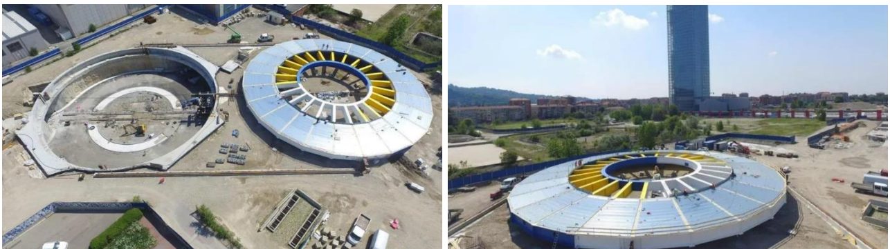
Figura 5-12 Posa della maxi-cupola in acciaio [S18]
