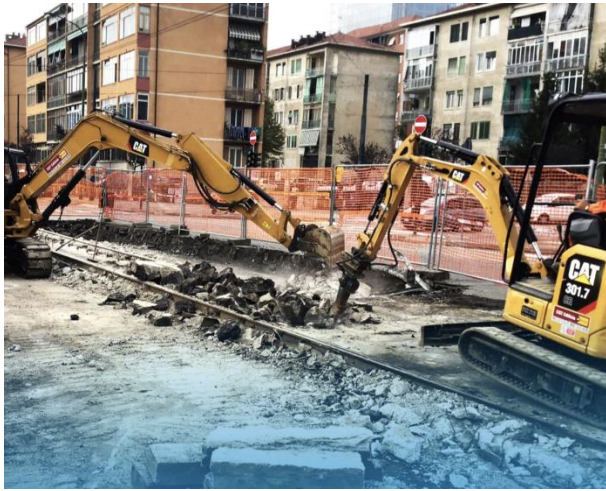
Figura 5-18 Lavori di ripristino, impermeabilizzazione e conservazione sopra e sotto l'impalcato di Via Nizza.
