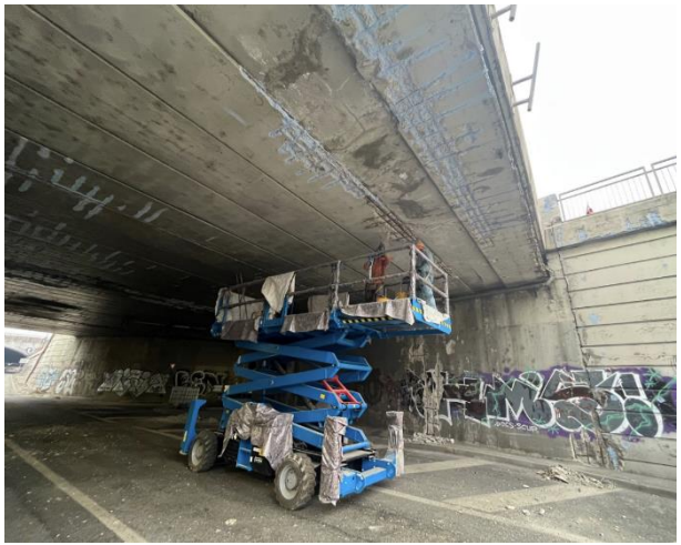
Figura 5-18 Lavori di ripristino, impermeabilizzazione e conservazione sopra e sotto l'impalcato di Via Nizza.
