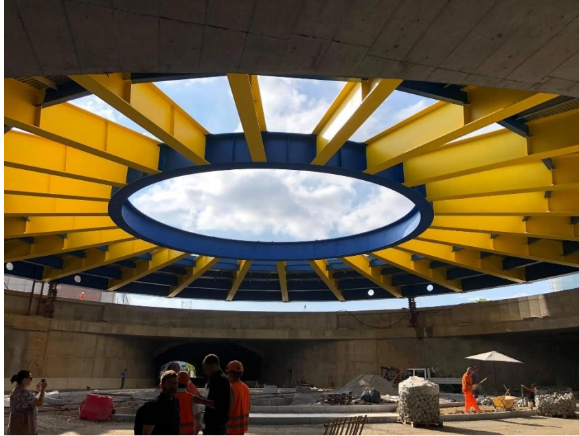
Figura 5-13 Posa della maxi-cupola in acciaio [S18]
