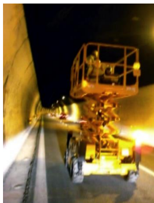
Figura 1-6 Interventi di manutenzione di una galleria con chiusura parziale di una corsia.
