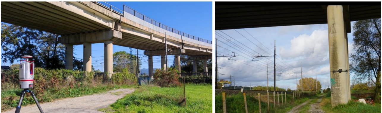
Figura 3-11 Esempio di rilievo eseguito con tecnica laser scanner (terrestre + UAV) di un viadotto stradale; a sinistra il manufatto con il laser scanner terrestre VZ400i RIEGL a destra il manufatto e il drone utilizzato (Fonte, ConsulCAD S.r.l.).
