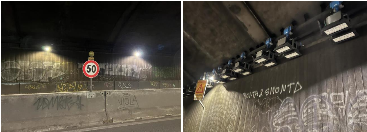
Figura 5-23 Segnaletica stradale verticale (segnale “limite di velocità 50 km/h” a sinistra e segnale “attenzione viabilità modificata” a destra).
