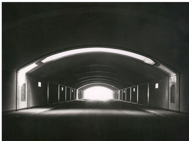
Figura 5-4 Sottopassaggio Lingotto, Via Nizza, Torino, interno, vista assiale in controluce nei pressi di un imbocco, 01/12/1933, stampa alla gelatina bromuro d'argento. (Fonte www.fondazionetorinomusei.it , Mario Gabinio).
