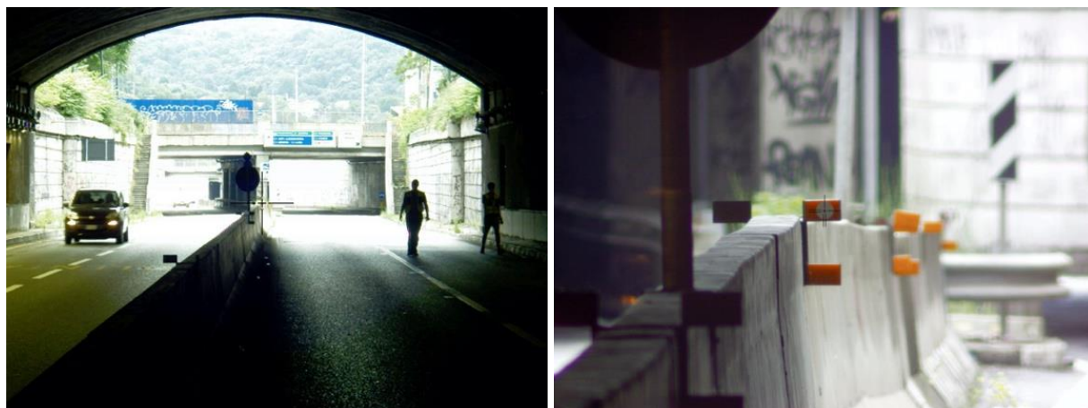
Figura 6-23 Esempio di monografia di un target (T1001) utilizzata per l'individuazione dei target nelle varie scansioni.
