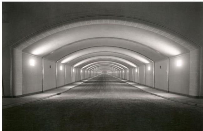
Figura 5-5 Sottopassaggio Lingotto, Via Nizza, Torino, vista generale notturna dall'imbocco orientale dell'interno illuminato, 10-1933, stampa alla gelatina bromuro d'argento. (Fonte www.fondazionetorinomusei.it , Mario Gabinio).
