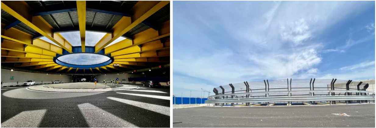
Figura 5-11 Rotatoria Lingotto interrata e sopraelevata rispettivamente a sinistra e a destra della figura.
