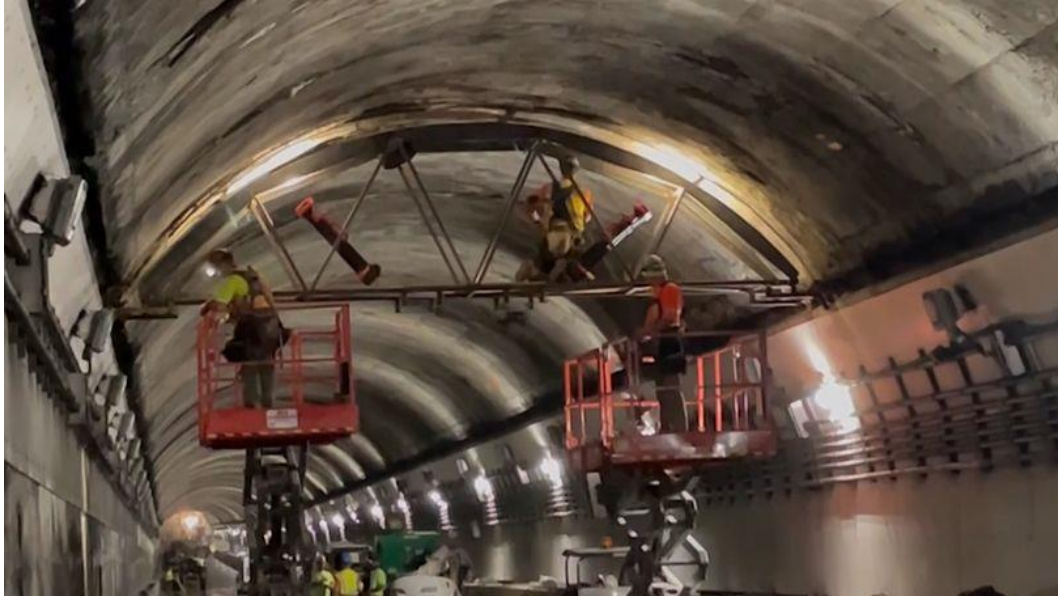
Figura 1-8 Interventi di manutenzione della volta di un tunnel stradale con chiusura completa.
