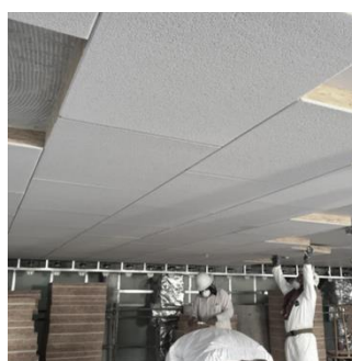
Figura 24 Pannelli posati stuccati
