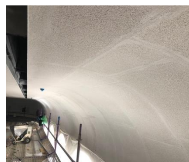
Figura 25 Pannelli posati, stuccati e carteggiati
