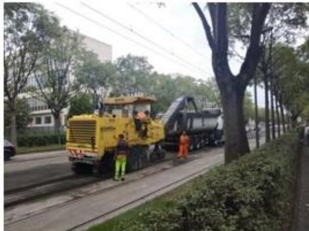
*Figura 3.1: Fresatura di RAP dalla pavimentazione*
