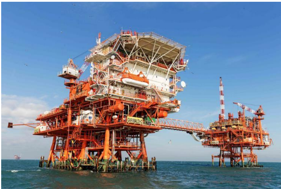
Figura 5. Piattaforme Garibaldi C e Garibaldi K a largo di Ravenna [9].
