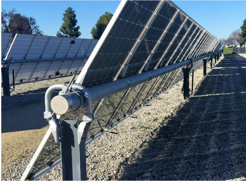
Figura 13: Impianto fotovoltaico con moduli montati su struttura con inseguitori solari ad asse singolo [8].
