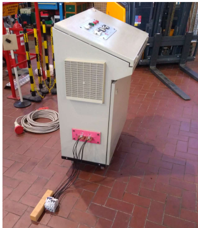
Figura 8-1: Generatore di corrente collegato agli interruttori
