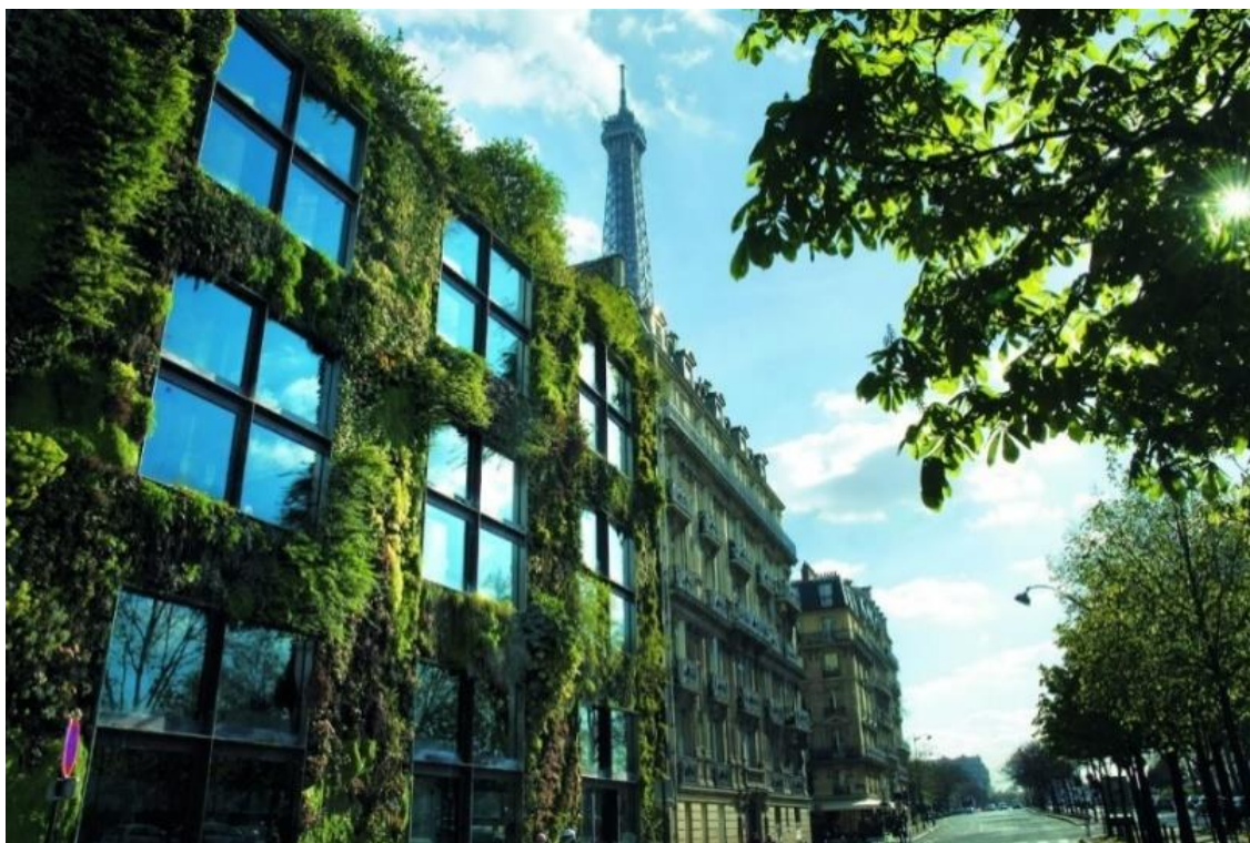
Figura 1.3: Esempio di muro verde (Museo Quai Branly di Parigi), fonte: ( https://www.paretiverdi.com/wp/chi-ha-inventato-i-giardini-verticali/ , s.d.)
