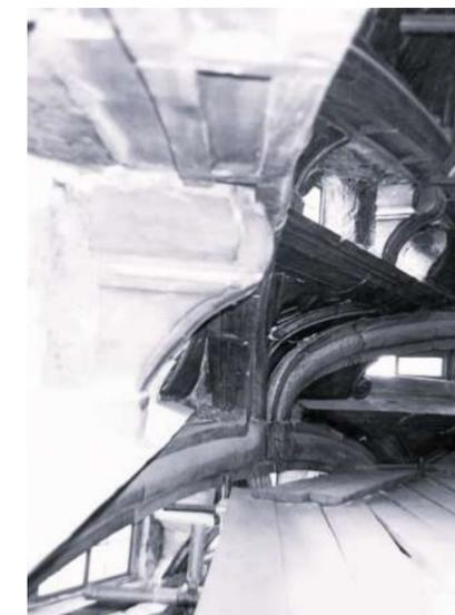
Fig.12 Parte del tavolato di legno del ponteggio al livello del cestello per il restauro degli anni Novanta.
