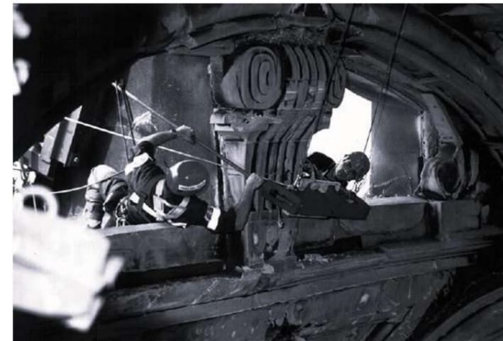
Fu necessario rimuovere completamente le tracce del ponteggio precedente, che risultava ormai impraticabile, (Figura 16) per realizzare un nuovo ponteggio per l'esecuzione delle opere di restauro. (Figura 17)
