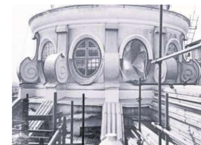
Fig.10 Vista esterna della camera di luce realizzata per l'ingresso della luce naturale e ottenere l'effetto ottico ricercato da Guarini.
