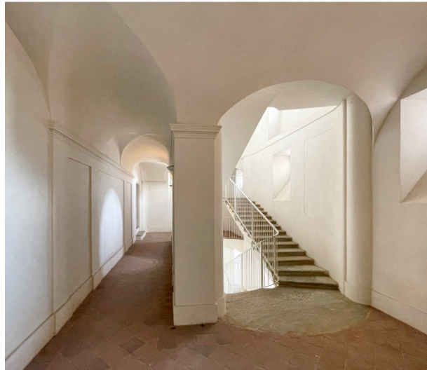
Figura 3 Reggia di Venaria Reale, scala detta “del Piacenza”, 1788-89, stato attuale. La scala è divisa dal corridoi tramite un muro portante che presenta fori da aperture su tutti i piani. Le lastre ricurve dei pianerottoli si protendono nei riposi intermedi. Oggi la scala è sorretta da una soletta in c.a. situata sotto i gradini in serizzo (da Burgassi, Novelli, Spila, p. 126).
