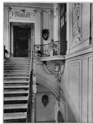
Figura 8 Filippo Juvarra, Particolare di una delle mensole che sorreggono l'ultimo pianerottolo, Palazzo Reale, Torino (da Reycend, p. 214).
