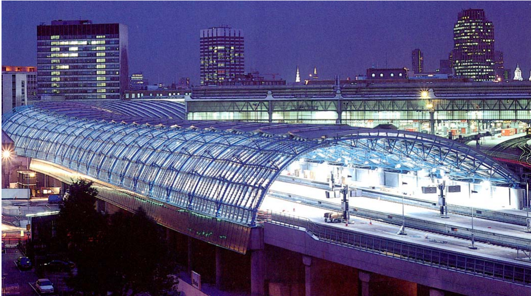
Figura 29: Vista notturna della copertura dei binari
