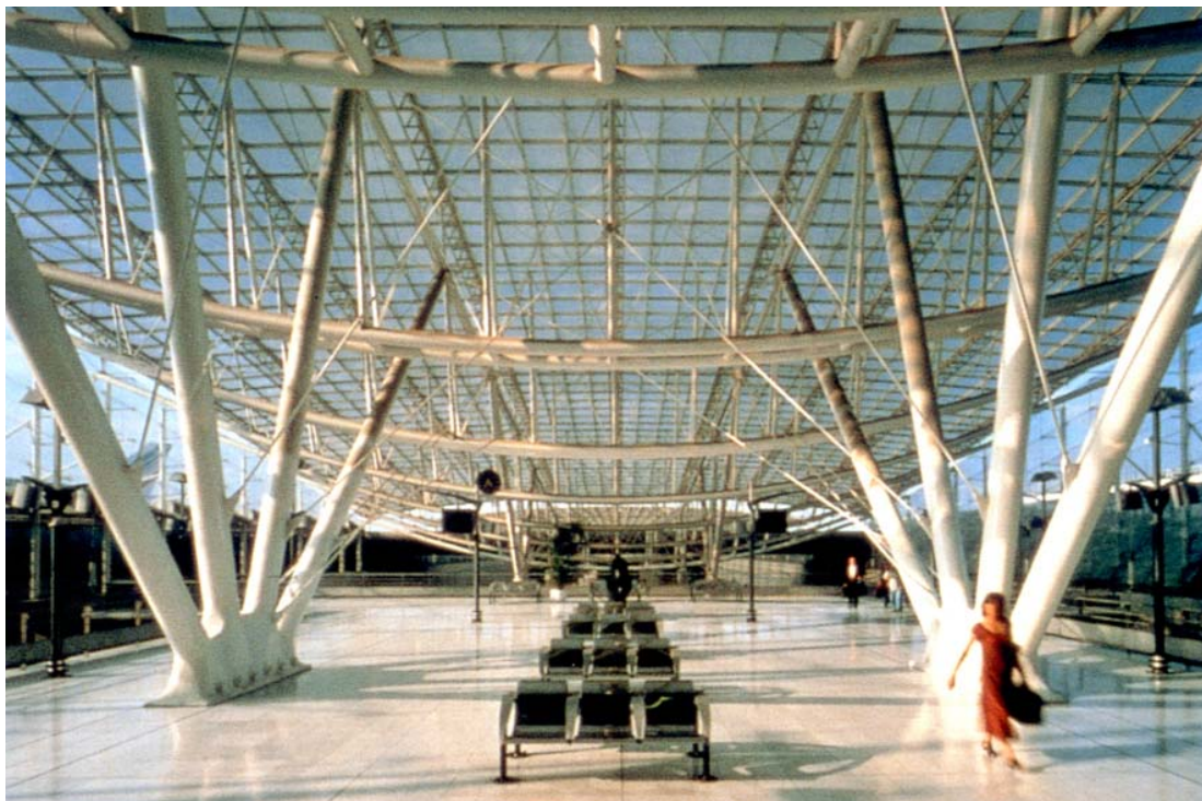
Figura 35: La grande copertura a capriate metalliche rovesciate
