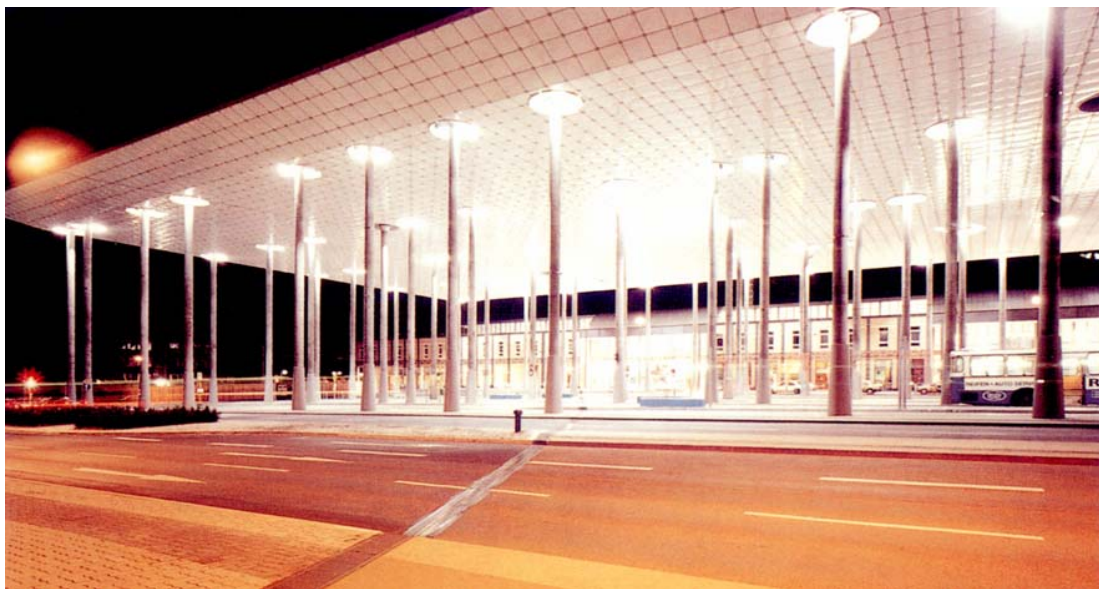
Figura 31: La piazza antistante l'ingresso alla stazione con la pensilina
