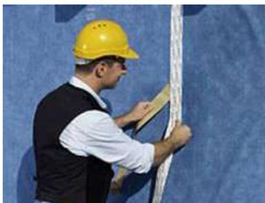
Posa del telaio impermeabile traspirante e nastratura. È necessario applicarla sulle superfici non intonacate per proteggerle da fenomeni di condensa superficiale o da infiltrazione di acque meteoriche. La posa deve essere effettuata su tutta la superficie ventilata a secco, tramite l'utilizzo di nastri, punti-chiodo e sormonti.
