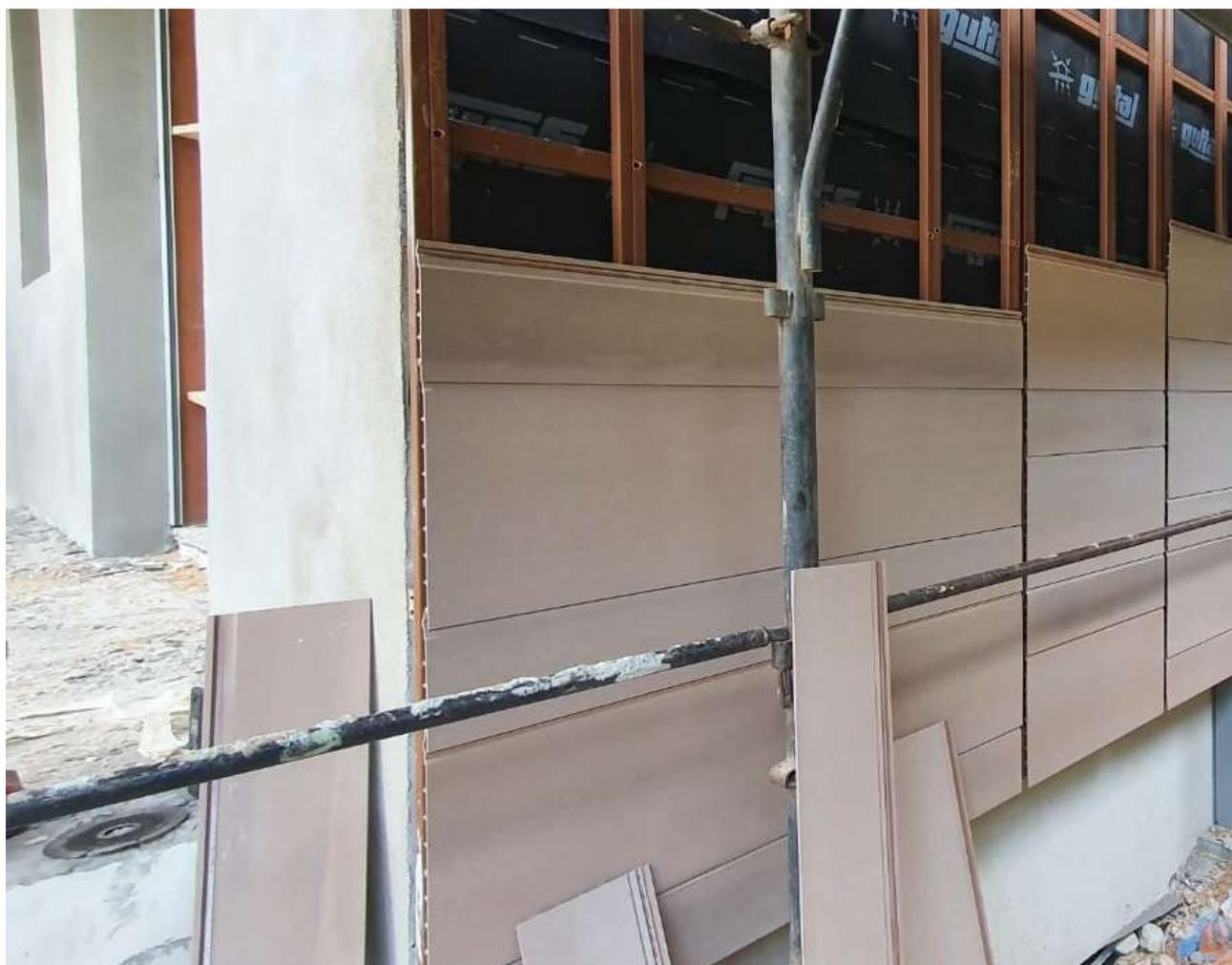
Figura 41. Completamento rivestimento esterno
