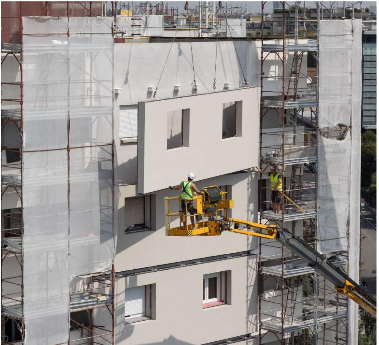
Figura 42. Installazione pannelli prefabbricati in facciata
