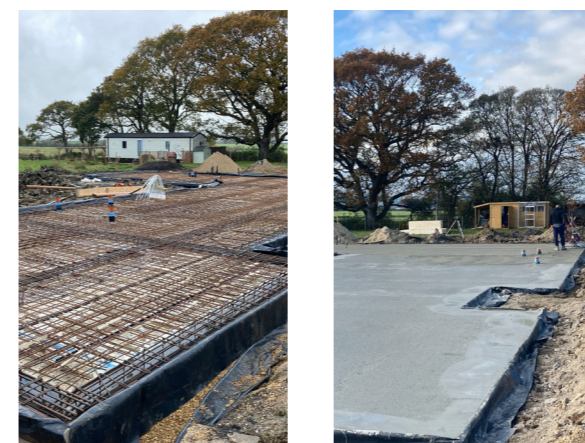
3. Costruzione dei solai di fondazioni Advanced Foundation Technology (AFT)
