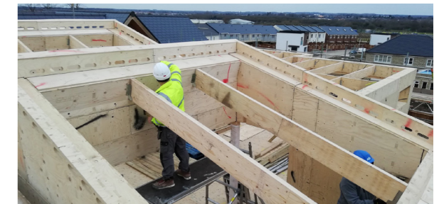
Fig.142. Costruzione della copertura. Fonte: https://www.self-build.co.uk/blog-timber-frame-erection-facit-homes/
