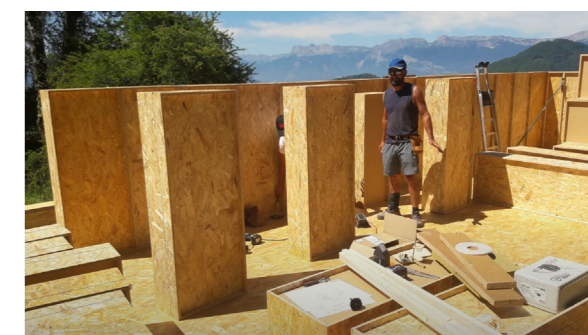
Fig.213. Disposizione dei blocchi parete Blokiwood. Fonte videoclip: https://www.youtube.com/watch?v=2znN5AM-61Po&t=6s&ab_channel=Blokiwood
