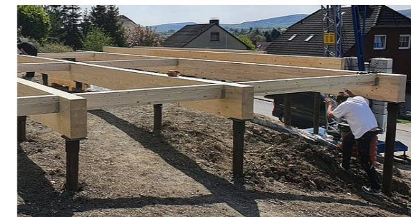
Fig.161. Fondazione a vite. Fonte immagine: https://www.guidaedilizia.it/product/cusi/pali-avvitati-in-acciaio-paalupiste-pro/
