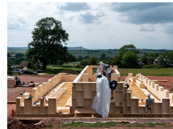
3. Assemblaggio del solaio di base e parte inferiore del sistema parete
