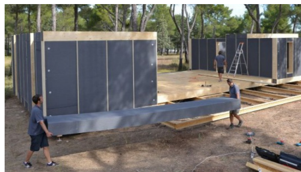
Fig.46. Movimentazione dei blocchi EPS per la copertura del progetto "Maison passive montée en 4 jours" costruito con il sistema PopUp House. Fonte: https://www.batiactu.com/edito/pop-up--une-maison-passive-montee-en-4-jours-38024.php
