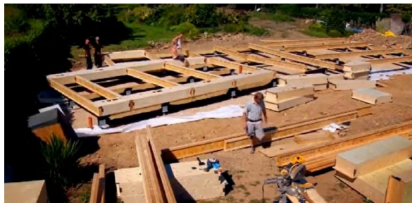
Fig.138. Costruzione fondazioni a vite. Fonte videodocumentario: https://vimeo.com/53932758
