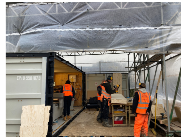
1. Preparazione della fabbrica portatile "MPF" inserita nell'area di stoccaggio "Ply Store" per la produzione dei componenti strutturali
