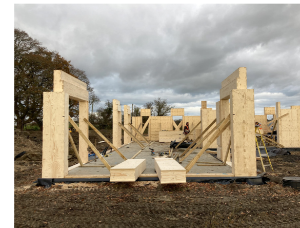
4. Assemblaggio dei componenti strutturali delle pareti strutturali
