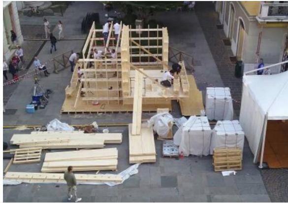
Fig.53. Assemblaggio del primo prototipo di costruzione Brix System di circa 35 mq realizzata in circa 6 ore a Brescia. Fonte: https://www.brixsystem.com/wp-content/uploads/2020/09/2020-07-28_BrixSystem_presentazione_ITA.pdf
