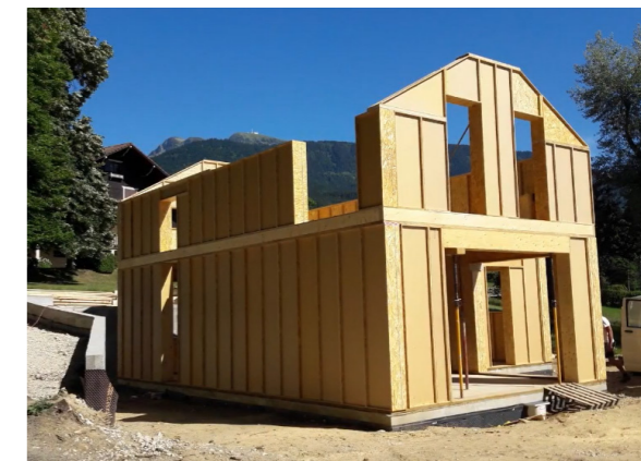
Fig.211. Sistema strutturale piano terra e primo piano di "Maison individuelle en Isère". Fonte videoclip: https://www.youtube.com/watch?v=2znN5AM61Po&t=6s&ab_channel=Blokiwood
