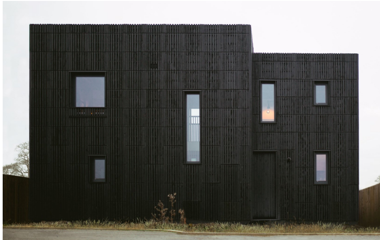
Fig.262. Progetto dello Studio Bark "Nest House" autocostruito con il sistema U-Build. Fonte: https://u-build.org/projects/nest-house/
