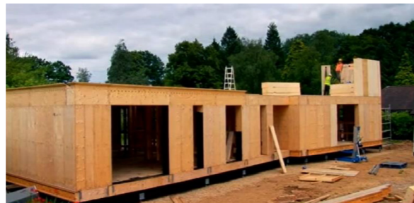
Fig.139. Assemblaggio della struttura portante. Fonte videodocumentario: https://vimeo.com/53932758
