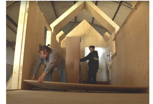
Fig.270. Assemblaggio della struttura dell'abitazione "Tiny House", U-Build. Fonte videoclip: https://www.youtube.com/watch?v=jybCXQxball&t=40s&ab_channel=U-Build
