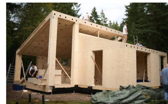
Fig.37. Assemblaggio della struttura portante di Villa Asserbo costruita con il sistema Facit Homes. Fonte: https://www.archdaily.com/264572/villa-asserbo-a-sustainable-printed-house-that-snaps-together
