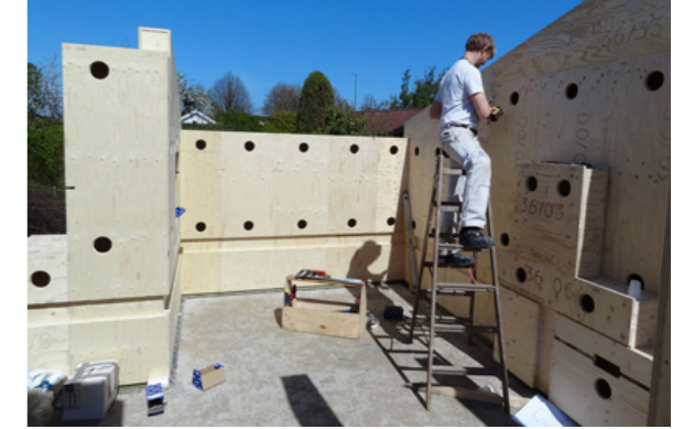
Fig.135. Fissaggio dei blocchi parete del progetto Kolonihavehus Kastrup. Fonte: http://www.eentileen.dk/projekt/kolonihavehus-kastrup/16/bagom
