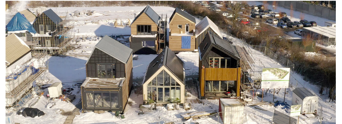
Fig.183. Abitazioni realizzate nel progetto WikiHouse "De Stripmaker". Fonte: https://www.wikihouse.cc/featured-projects/de-stripmaker
