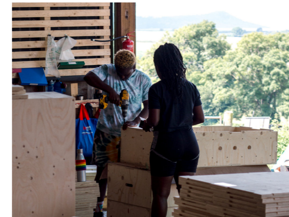
1. Assemblaggio e fissaggio dei pannelli bidimensionali in compensato
