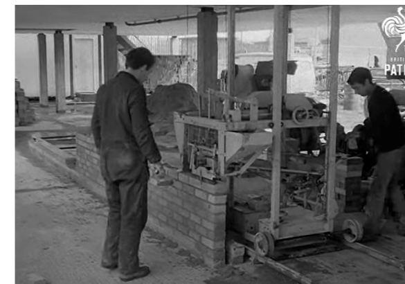
Fig.25. Macchinario "Motor Mason" per la posa di calce e mattoni. Fonte: https://www.theb1m.com/video/a-short-history-of-bricklaying-robots
