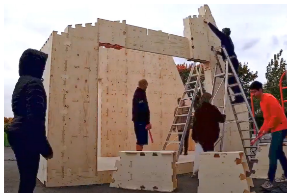
Fig.40. Assemblaggio della struttura portante del "Wikipavillon". Fonte fotogrammi da videoclip YouTube: https://www.youtube.com/watch?v=tdYBML6VCMA&ab_channel=PulpBuild
