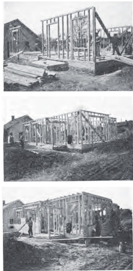
Fig.13. Assemblaggio della struttura a telaio del sistema costruttivo dell'abitazione "Honor Bilt" 100 del catalogo "Modern Homes Sears, Roebuck and Co. Chicago - New York" 1936. Fonte: https://dahp.wa.gov/sites/default/files/ModernHomessears1936.small_.pdf
