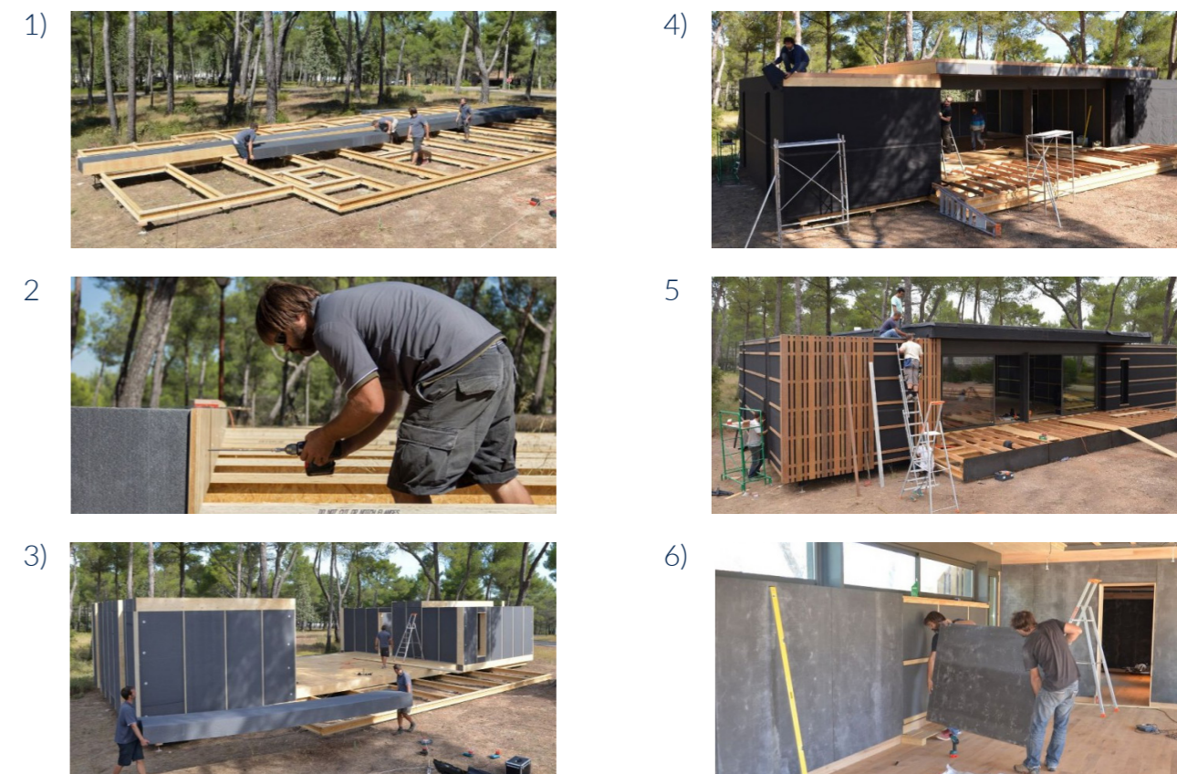
Fig.235. Fasi di assemblaggio dei componenti del progetto PopUp House "Maison passive montée en 4 jours": 1) Costruzione delle fondazioni, assemblaggio del solaio di base. 2) Fissaggio a vite dei componenti. 3) Assemblaggio delle pareti. 4) Assemblaggio della copertura e successiva impermeabilizzazione. 5) Applicazione del rivestimento esterno in Frassino THT. 6) Applicazione del rivestimento interno. Fonte: https://www.batiactu.com/edito/pop-up---une-maison-passive-montee-en-4-jours-38024.php
