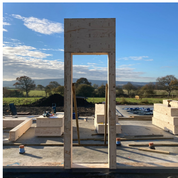
Fig.125. Blocchi pilastri ed architrave per il sistema porte e finestre del progetto Facit Homes "Eco home in East Sussex". Fonte: https://www.facit-homes.com/post/starting-on-site
