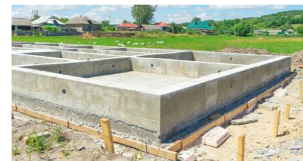
Fig.164. Fondazione a trave rovescia. Fonte immagine: https://www.immobilgreen.it/news/case-in-legno/fondazioni-case-in-legno-quello-che-devi-sapere/
