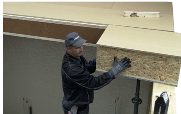
Fig.45. Assemblaggio di un blocco tetto Blokiwood. Fonte: https://blokiwood.fr/nos-produits/toitures/
