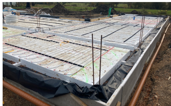
Fig.123. Solaio di fondazione AFT del progetto Facit Homes "Eco home in East Sussex". Applicazione dei pannelli in EPS da 300mm e sistema di riscaldamento a pavimento. Fonte: https://www.facit-homes.com/post/starting-on-site
