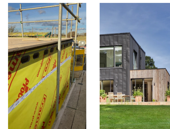
6. Applicazione del rivestimento impermeabilizzante e successiva finitura dell'involucro esterno
