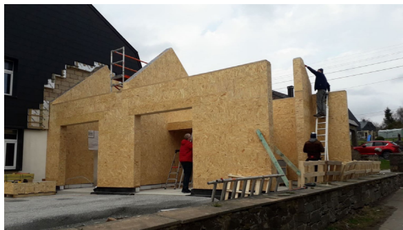
Fig.55. Autocostruzione della struttura portante Gablok del progetto di estensione di un'abitazione a Libin in Belgio. Fonte: https://gablok.be/en/projets/building-extension-libin
