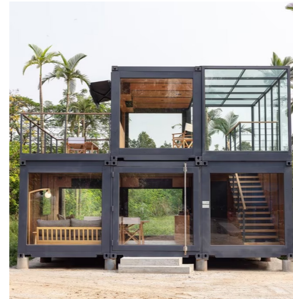
Fig.99. Abitazione prefabbricata a container. Progetto "Goodman Westlink showroom", dello studio Substance". Fonte: https://www.domusweb.it/architettura/2021/08/23/best-of-container-houses-.html
