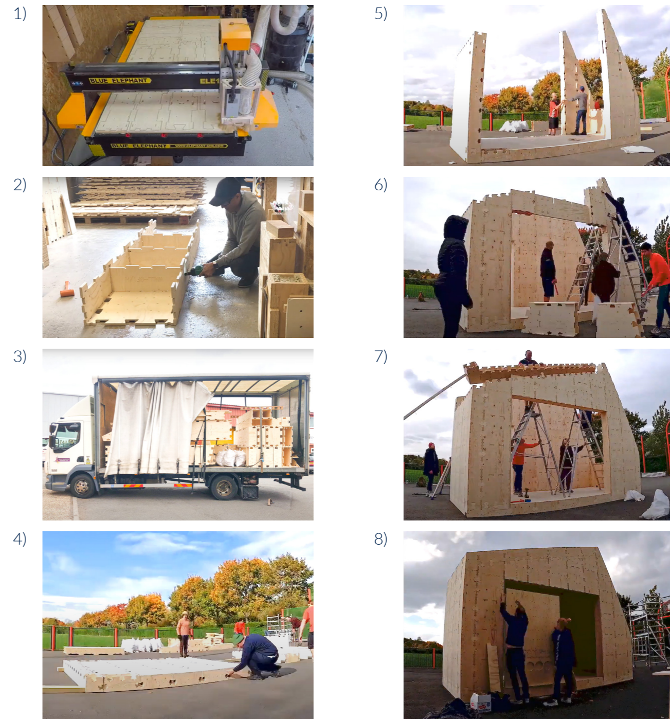
Fig.176. Processo produttivo ed autocostruttivo del padiglione Wikipavillon: 1) Taglio dei blocchi Skylark tramite macchina CNC. 2) Pre-assemblaggio dei blocchi in fabbrica. 3) Trasporto dei blocchi pre-assemblati. 4) Assemblaggio blocchi solaio di base. 5) Fissaggio blocchi parete su solaio di base. 6) Fissaggio architrave su blocchi parete. 7) Assemblaggio blocchi copertura su blocchi parete ed architrave. 8) Completamento del padiglione con l'aggiunta di una porta a battente senza telaio. Fonte: fotogrammi da videoclip: https://www.youtube.com/watch?v=tdYBML6VCMA&ab_channel=PulpBuild
