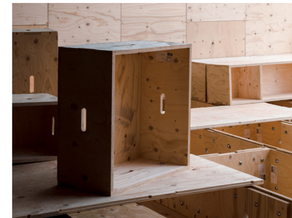
2. Blocchi tridimensionali per pareti, solaio di base e solaio di copertura
