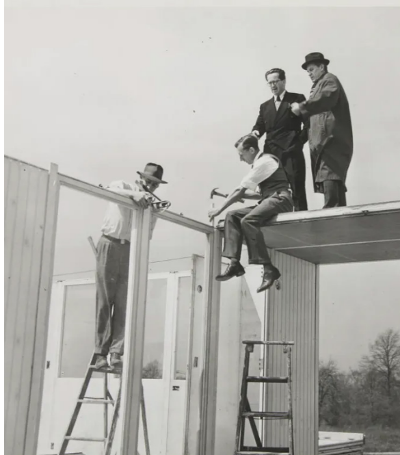
Fig.23. Konrad Wachsmann e Walter Gropius durante il montaggio di una Packaged House costruita con il General Panel System. Fonte: https://medium.com/@jimenezmorenopablo/the-conflict-of-prefabrication-e891d00a0921
