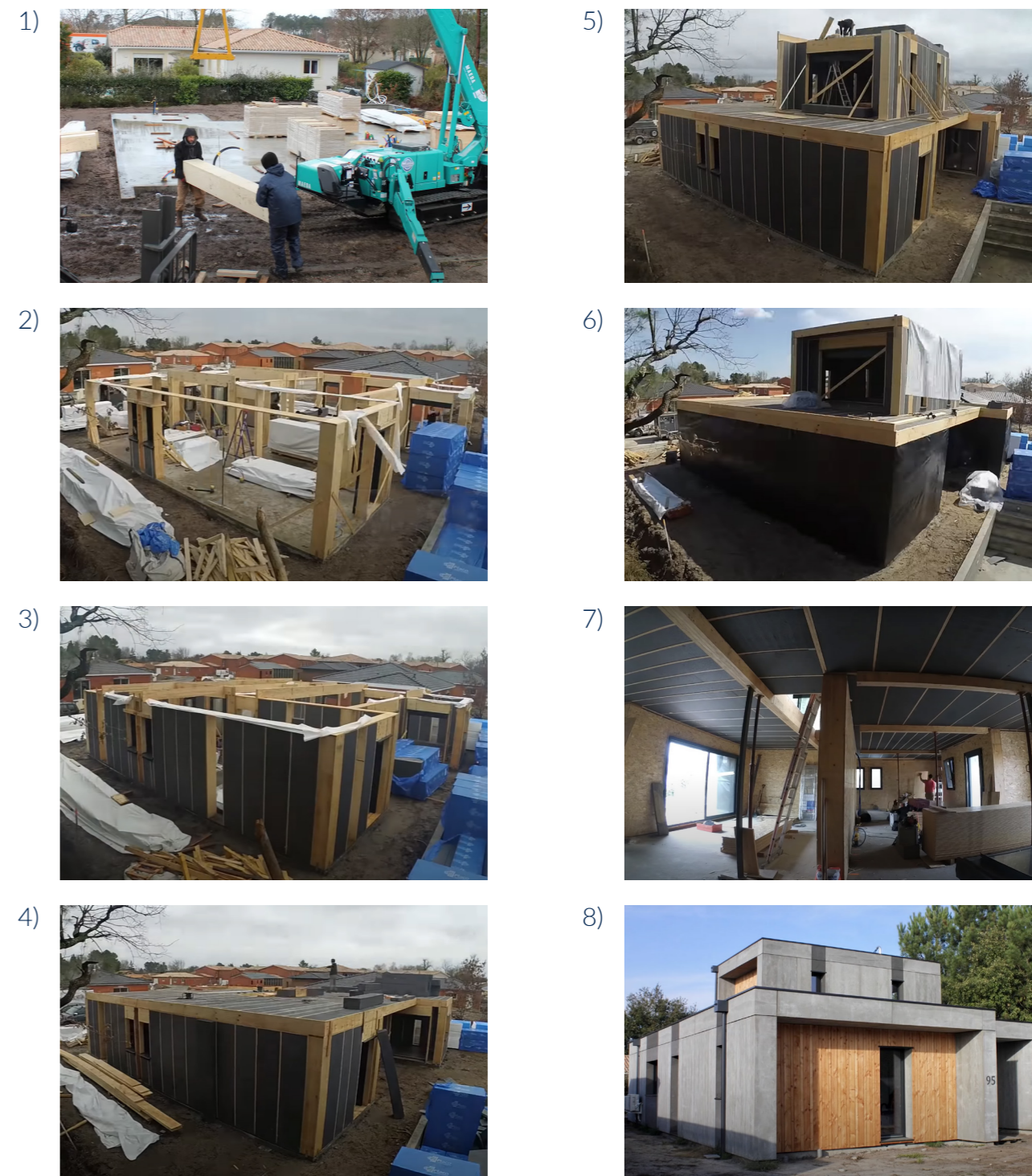
Fig.239. Processo di autoconstruzione della struttura e delle finiture del progetto PopUp House "Maison 150mq en Gironde": 1) Costruzione della platea di fondazione. 2) Assemblaggio struttura travi, pilastri e pannelli per le forature. 3) Assemblaggio dei blocchi parete. 4) Assemblaggio dei blocchi solaio d'interpiano. 5) Assemblaggio del secondo piano. 6) Impermeabilizzazione. 7) Applicazione delle finiture interne. 8) Applicazione del rivestimento esterno. Fonte video Youtube "Montage d'une PopUp House par Atelier Artwood #1": https://www.youtube.com/watch?v=236l8jfy5y8&ab_channel=AtelierArtWood
