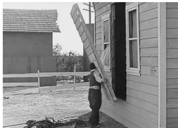
Fig.18. Assemblaggio pannelli dell'abitazione del cortometraggio "One week" di Buster Keaton. Fonte: https://www.youtube.com/watch?v=Xd6d-dOlKp8&ab_channel=ClassicsofWorldCinema
