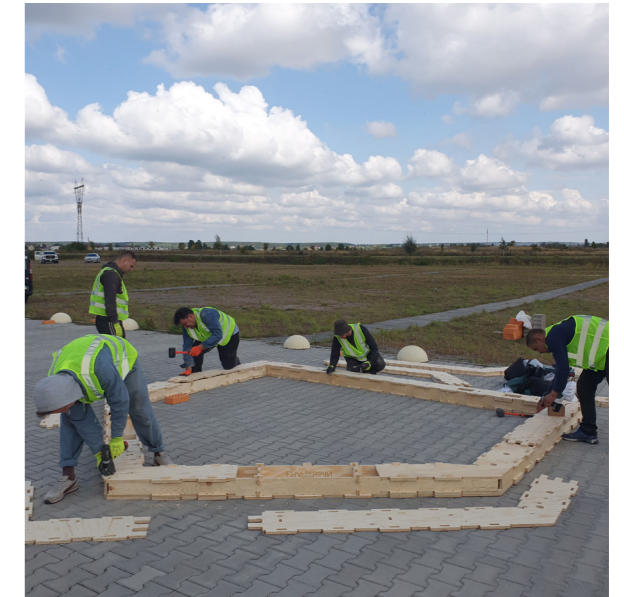
Fig.101. Costruzione portali strutturali per abitazione "The Shelter" con il sistema WikiHouse. Fonte: https://www.wikihouse.cc/featured-projects/the-shelter
