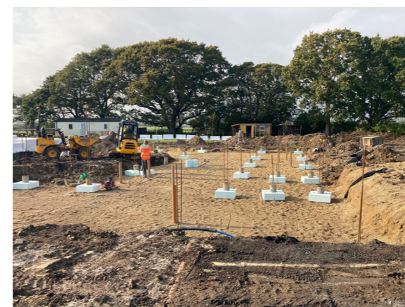
2. Inserimento dei pali in acciaio nel terreno per stabilizzare le fondazioni
