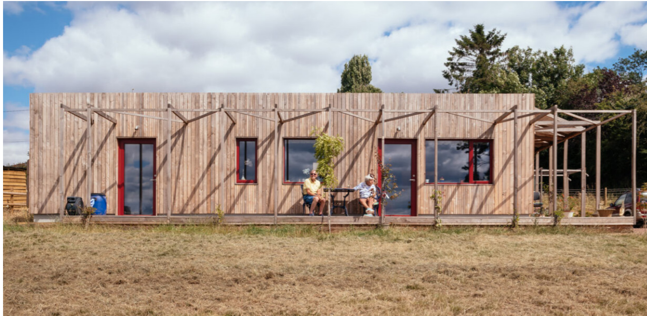
Fig.260. Progetto dello Studio Bark "Nest House" autocostruito con il sistema U-Build. Fonte: https://u-build.org/projects/nest-house/
