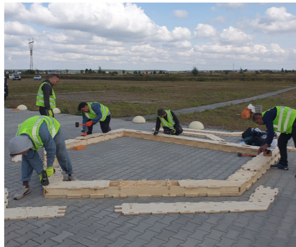
Fig.182. Costruzione portali strutturali per abitazione "The Shelter". Fonte: https://www.wikihouse.cc/featured-projects/the-shelter
