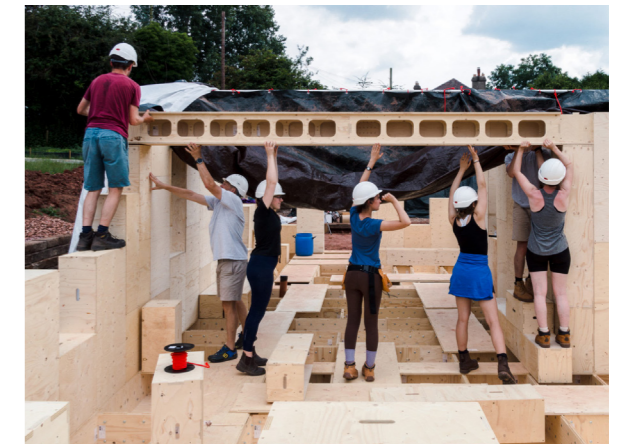
4. Assemblaggio dei blocchi solaio speciali che fungono da trave
