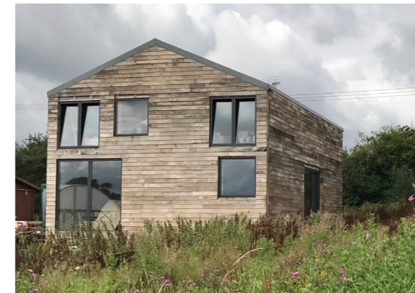
Fig.41. Abitazione "Farmhouse" costruita con il sistema WikiHouse. Fonte: https://www.wikihouse.cc/featured-projects/farmhouse
