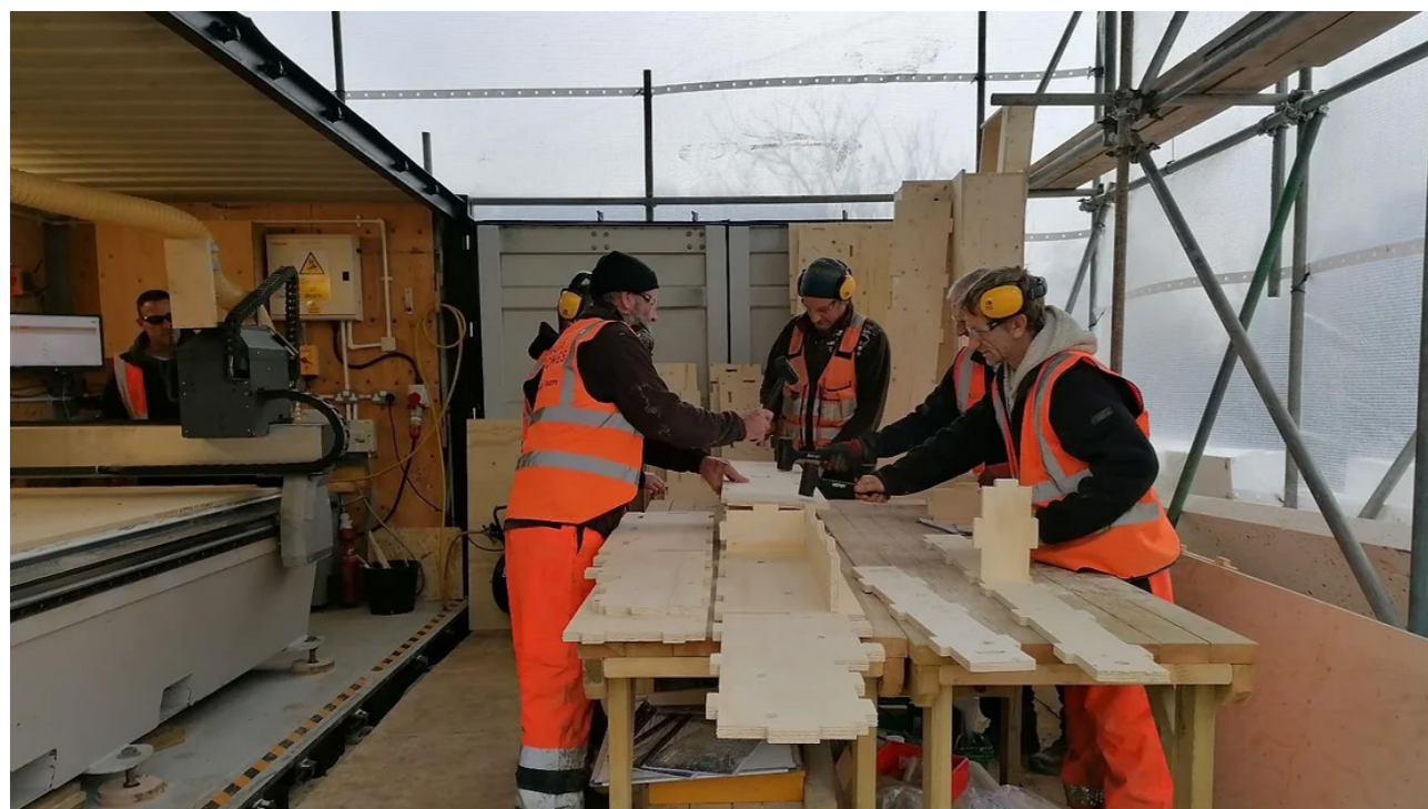
Fig.77. Assemblaggio dei componenti bidimensionali tagliati a macchina CNC per comporre i blocchi strutturali. Fonte: https://www.facit-homes.com/post/starting-on-site
