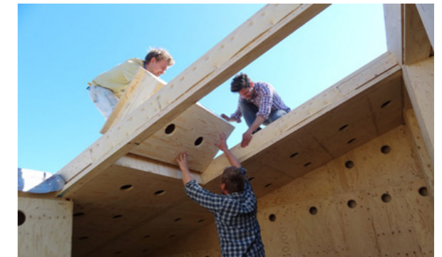
Fig.136. Assemblaggio del solaio di copertura del progetto Kolonihavehus Kastrup. Fonte: http://www.eentileen.dk/projekt/kolonihavehus-kastrup/16/bagom
