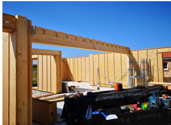
Fig.217. Sistema costruttivo Blokiwood del piano terra del progetto "Maison ossature bois dans le puy de dôme". Fonte: https://blokiwood.fr/departements/construction-maison-ossature-bois-puy-de-dome/maison-ossature-bois-a-maringues/
