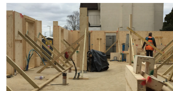
2. Assemblaggio dei blocchi parete perimetrali strutturali supportate durante la posa per compensare eventuali deviazioni
