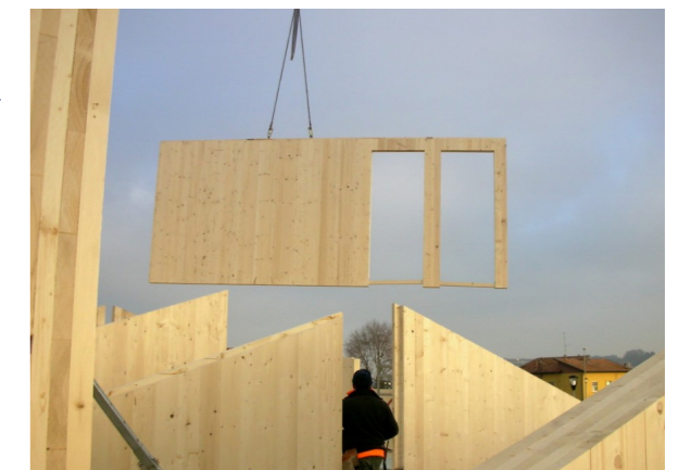
Fig.65. Pannello parete prefabbricato in CLT. Fonte: https://www.tecnocomfortcase.it/case-prefabbricate-risparmio-energetico-in-legno/sistema-nur-holz-pannelli-in-legno-totalmente-naturali/particolari-costruttivi-sistema-nur-holz/
