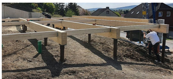
Fig.255. Fondazione a vite. Fonte immagine: https://www.guidaedilizia.it/product/cusi/pali-avvitati-in-acciaio-paalupiste-pro/
