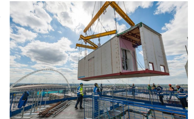
Fig.64. Blocco abitativo prefabbricato tridimensionale. Fonte: https://www.teknoring.com/news/materiali-e-soluzioni/prefabbricazione-modularita-futuro-edilizia/
