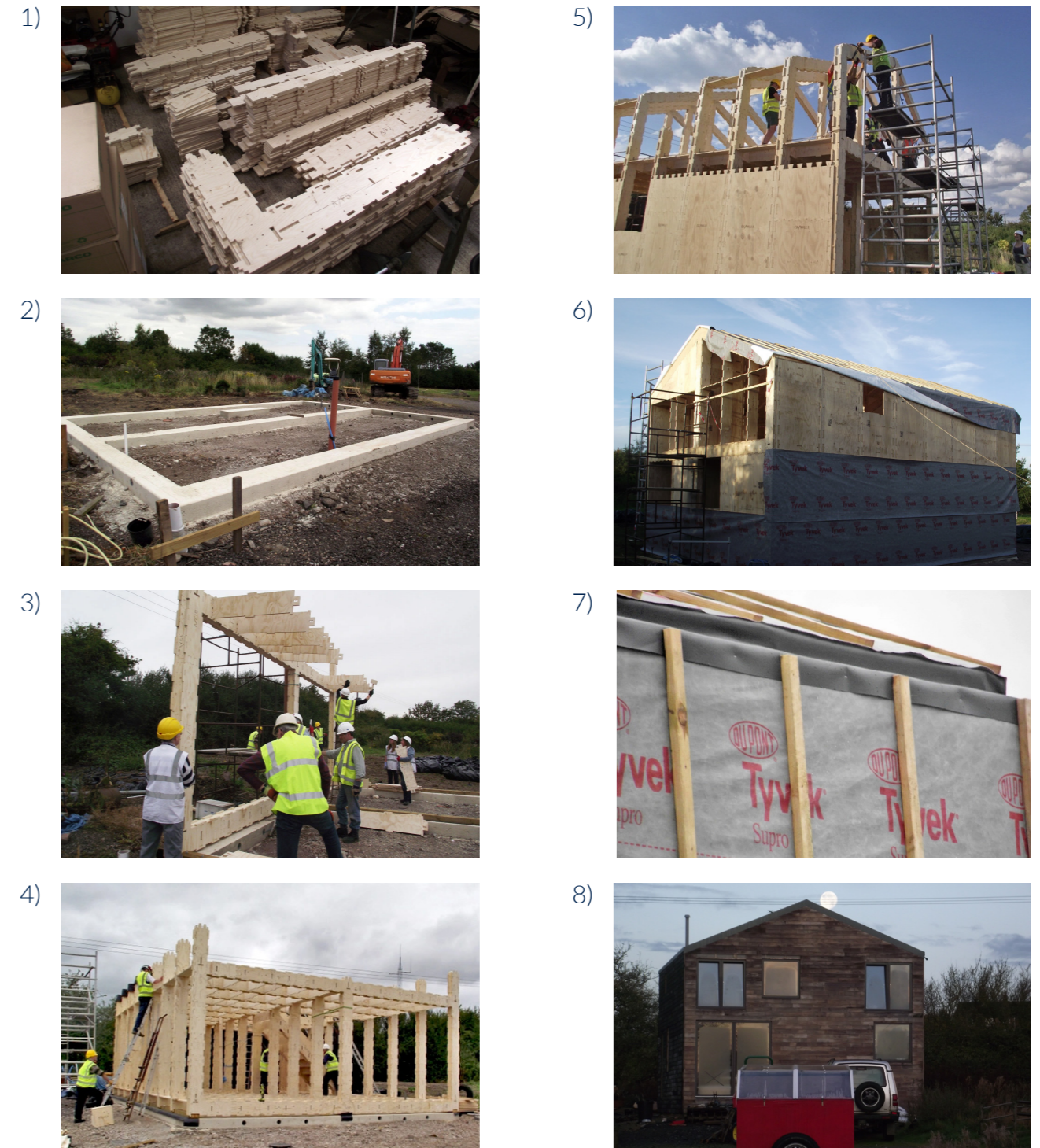
Fig.178. Processo di autoconstruzione della struttura e delle finiture del progetto WikiHouse "Farmhouse": 1) Stoccaggio dei blocchi strutturali. 2) Costruzione delle fondazioni a travi rovesce. 3) Fissaggio dei blocchi pilastri su fondazioni. 4) Costruzione del piano terra a travi e pilastri. 5) Costruzione piano primo con copertura a doppia falda. 6) Tamponamento della struttura con pannelli di compensato e successiva impermeabilizzazione. 7) Fissaggio dei montanti per il rivestimento esterno 8) Applicazione rivestimento esterno. Fonte: https://awikifarmhouse.wordpress.com/2015/08/05/building-a-plywood-farmhouse
