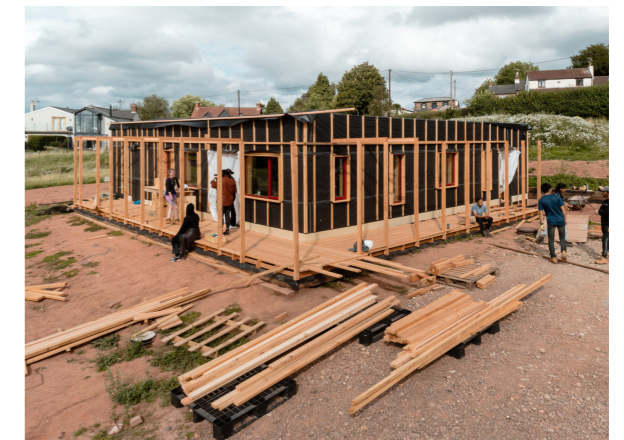
5. Assemblaggio dello strato impermeabilizzanti, della pavimentazione esterna e della veranda
