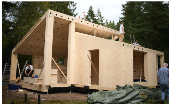
Fig.131. Assemblaggio della struttura portante di Villa Asserbo. Fonte: https://www.archdaily.com/264572/villa-asserbo-a-sustainable-printed-house-that-snaps-together
