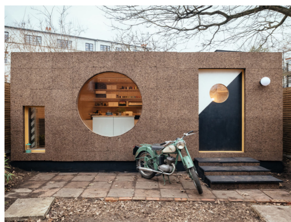
Fig.247. Progetto U-Build "Name Name Pod" realizzato con blocchi in sughero e pannelli in compensato. Fonte: https://u-build.org/projects/name-name-pod/
