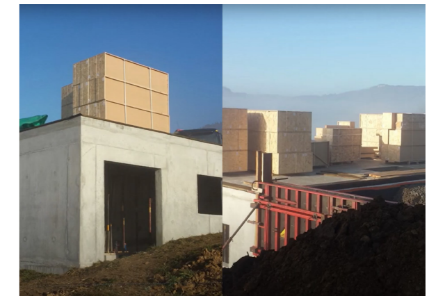
Fig.221. Blocchi parete e solaio da assemblare sul basamento in CA, Blokiwood. Fonte videoclip: https://www.youtube.com/watch?v=F-QHASzeSUNk&ab_channel=Blokiwood
