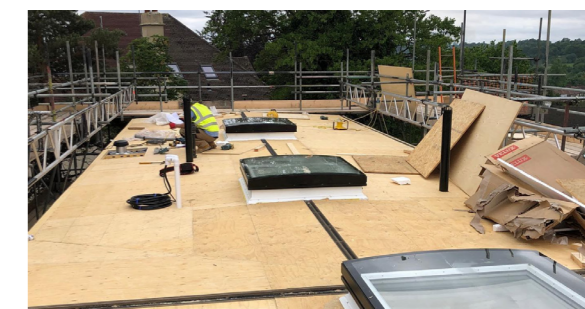
6. Inserimento degli infissi dei lucernari e successivo rivestimento del tetto con pannelli di compensato
