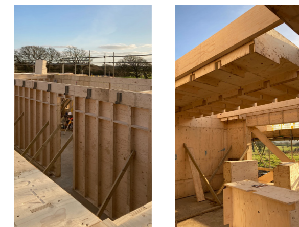
5. Assemblaggio delle componenti parete interne e del solaio di copertura
