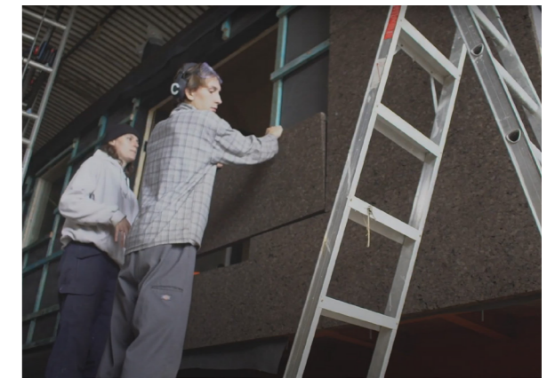
Fig.271. Assemblaggio del rivestimento in sughero dell'abitazione "Tiny House", U-Build. Fonte videoclip: https://www.youtube.com/watch?v=jybCXQxball&t=40s&ab_channel=U-Build
