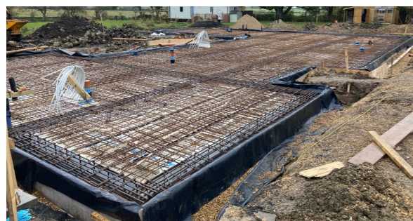
Fig.124. Solaio di fondazione AFT del progetto Facit Homes "Eco home in East Sussex". Costruzione della soletta armata da 100mm e delle travi rovesce. Fonte: https://www.facit-homes.com/post/starting-on-site
