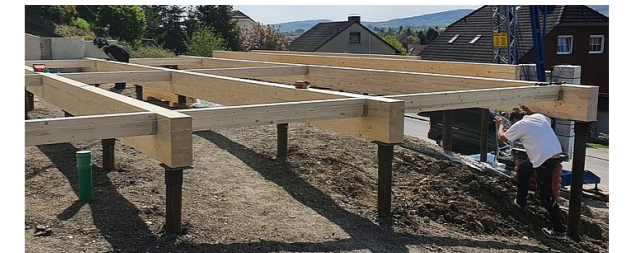
Fig.89. Fondazione a vite su terreno scosceso. Fonte immagine: https://www.guidaedilizia.it/product/cusi/pali-avvitati-in-ac-ciao-paalupiste-pro/
