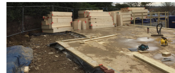
1. Costruzione del sistema di fondazioni a platea in cemento armato e fissaggio delle piastre intorno al perimetro della fondazione per l'assemblaggio dei blocchi parete
