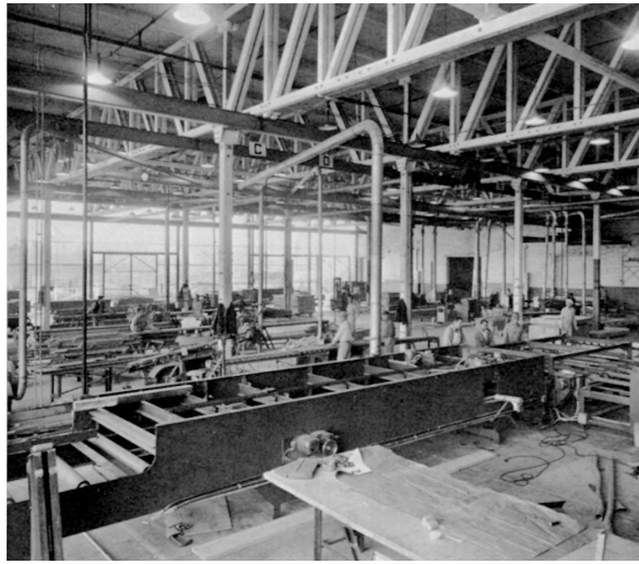
Fig.22. Impianto produttivo General Panel Corporation. Fonte: https://www.acsa-arch.org/proceedings/Fall%20Conference%20Proceedings/ACSA.FALL.12/ACSA.FALL.12.8.pdf
