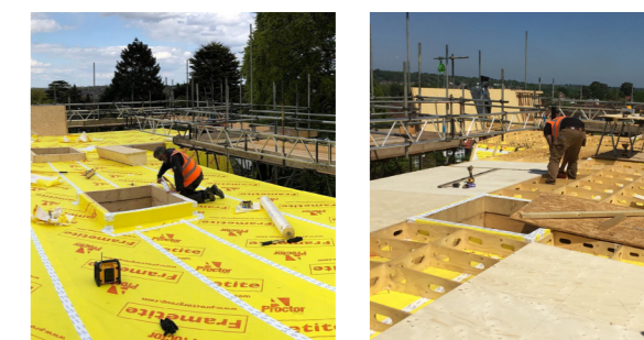
7. Impermeabilizzazione ed assemblaggio dei travetti del tetto ventilato
