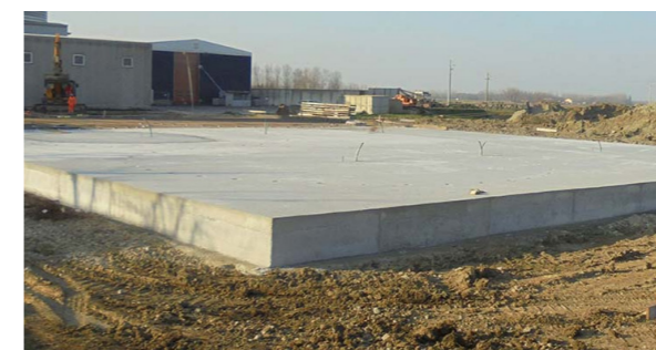
Fig.163. Fondazione a platea. Fonte immagine: https://lavoriindustriali.com/progetti/progeo.php
