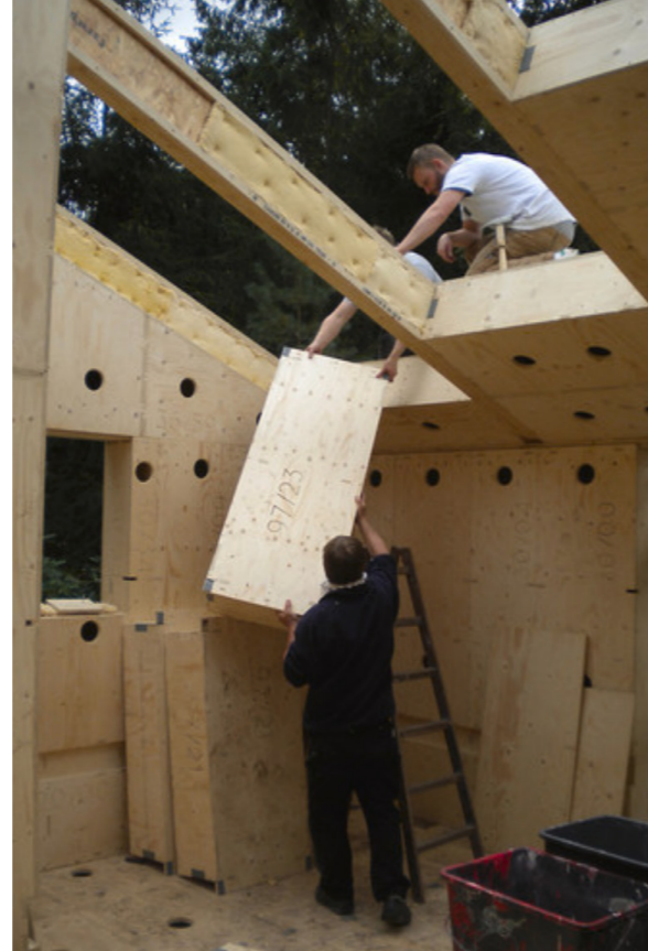
Fig.132. Assemblaggio del solaio di copertura di Villa Asserbo. Fonte: https://www.archdaily.com/264572/villa-asserbo-a-sustainable-printed-house-that-snaps-together
