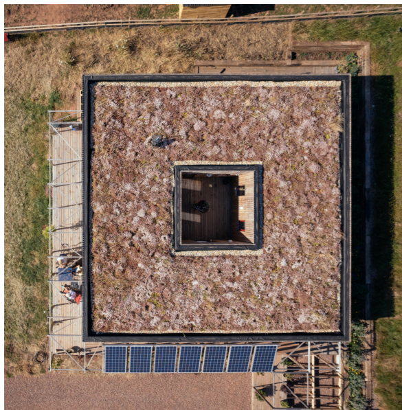
Fig.257. Tetto a spiovente del progetto U-Build "Nest House". Fonte: https://u-build.org/projects/nest-house/
