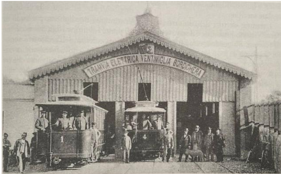
Figura 15 Deposito tram a Ventimiglia. P. ROSSI, La Tramvia Ventimiglia-Bordighera , in P. ROSSI (a cura di), Racconti di Bordighera 3... , cit., p. 267.
