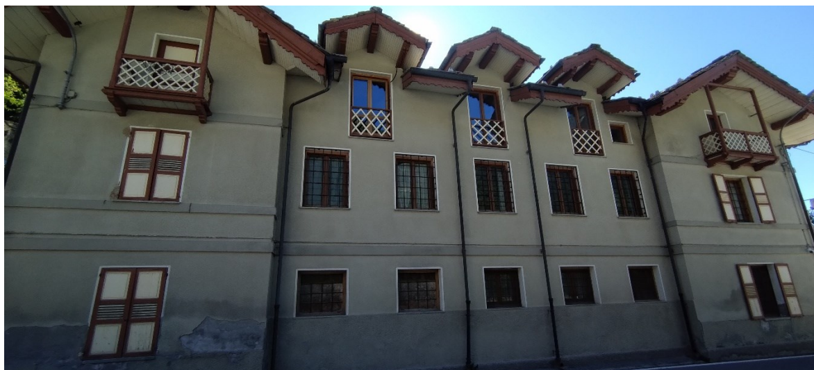
Fig. 8 La facciata ovest dell'edificio di ponente accanto alla strada carrozzabile
