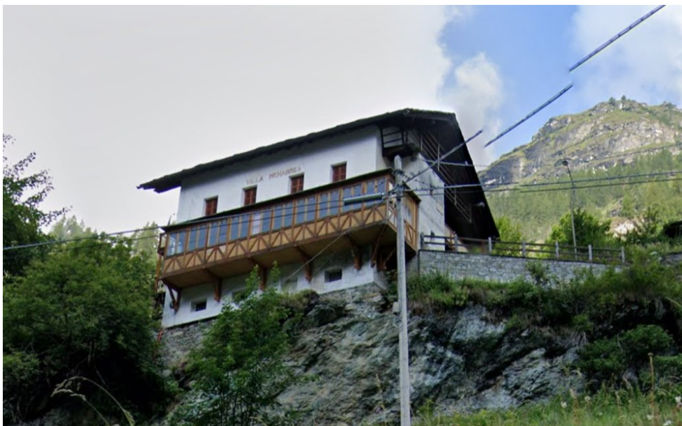
Fig. 21 Villa Menabrea come si presenta oggi
