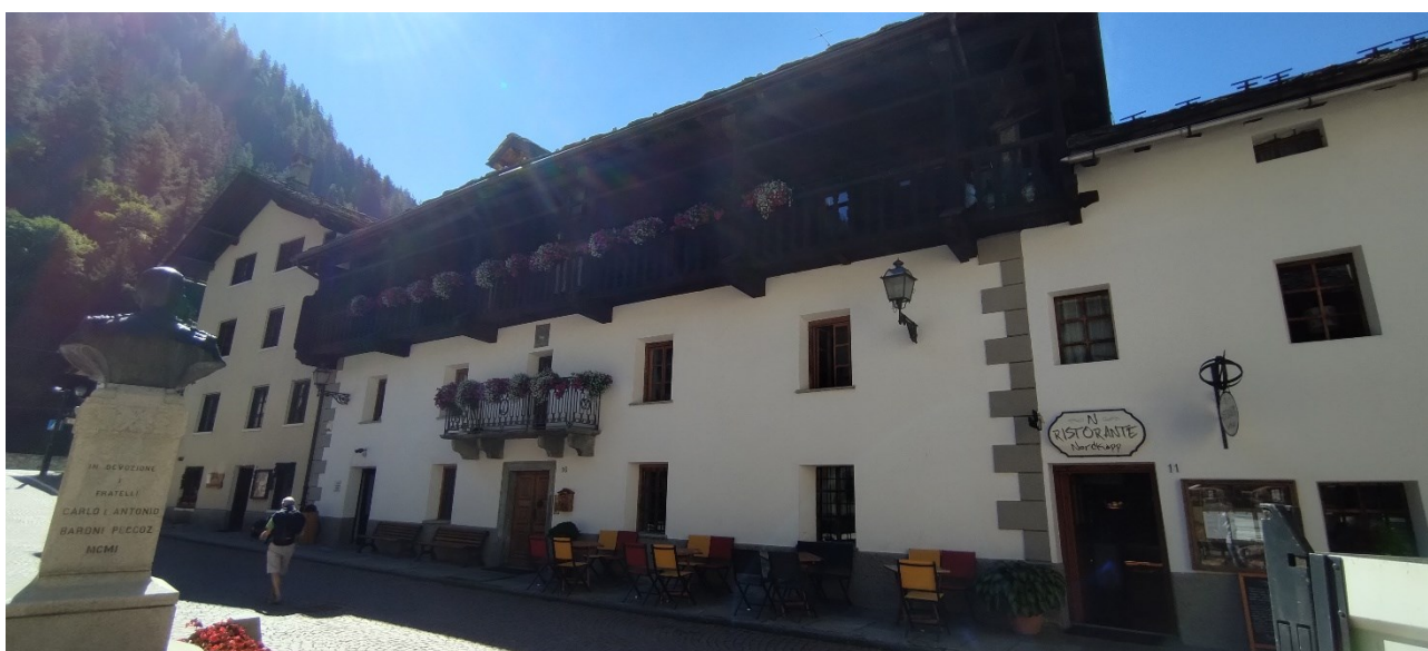
Fig. 5 L'edificio che ospitava l'ostello come si presenta oggi
