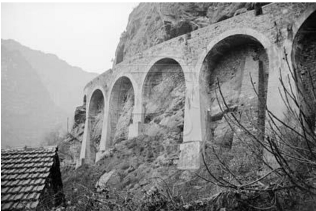
Fig. 6 I muri di sostegno della "Mongiovetta"
