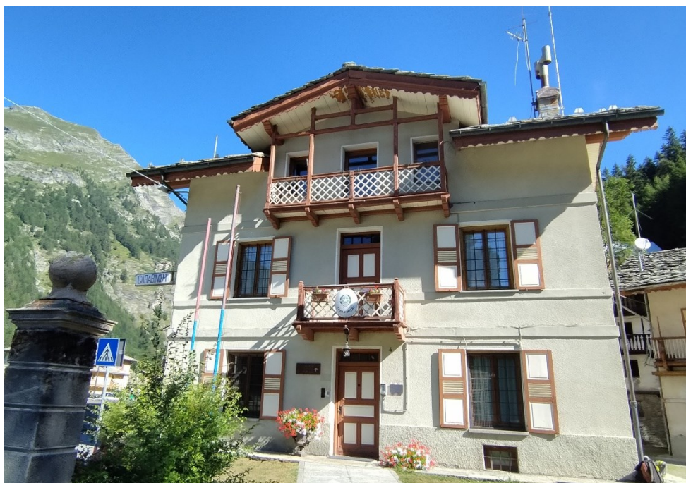
Fig. 9 La facciata sud dell'edificio di ponente con l'ingresso
