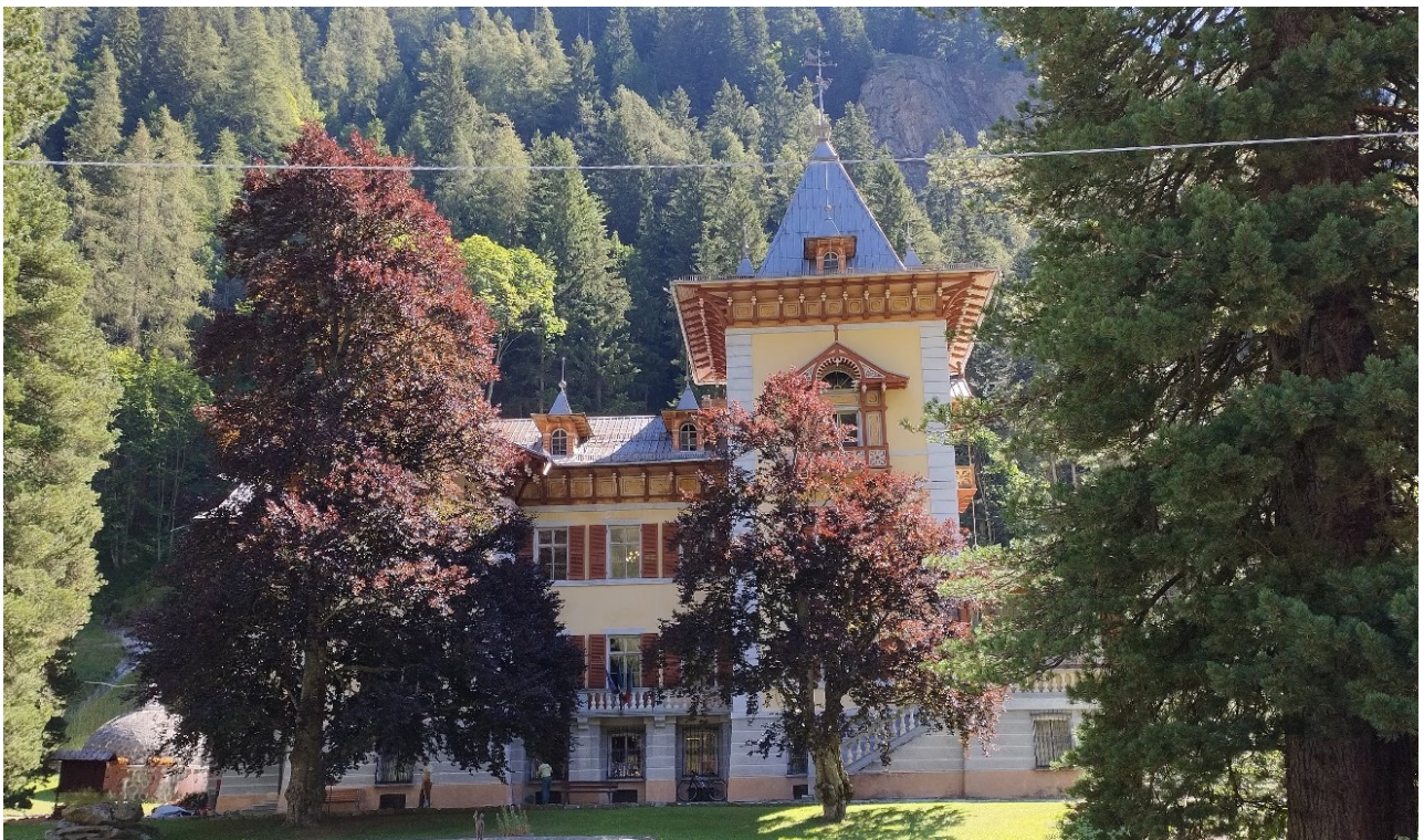
Fig. 21 La facciata a ovest della villa seminascosta dagli alberi ad alto fusto
