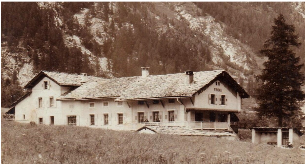
Fig. 64 La villa Fridau in una immagine dei primi del Novecento Da Villa Resort Fridau, Storia , disponibile al sito https://www.villafridau.com , u.c. 18/01/2024
