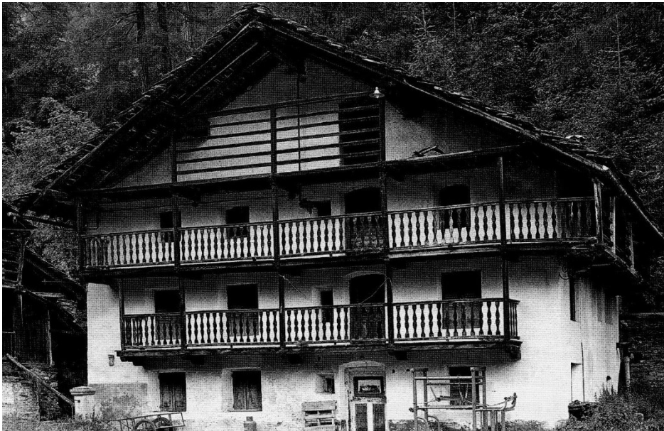
Fig. 15 Esempio di abitazione a funzione mista in muratura nella frazione di Ondre Eselbode Da Mauro ZUCCA PAUL, Danilo MARCO, Claudine REMACLE, Abitare walsler: l'architettura storica nell'alta valle del Lys , Le château, Aosta 2006, p. 100
