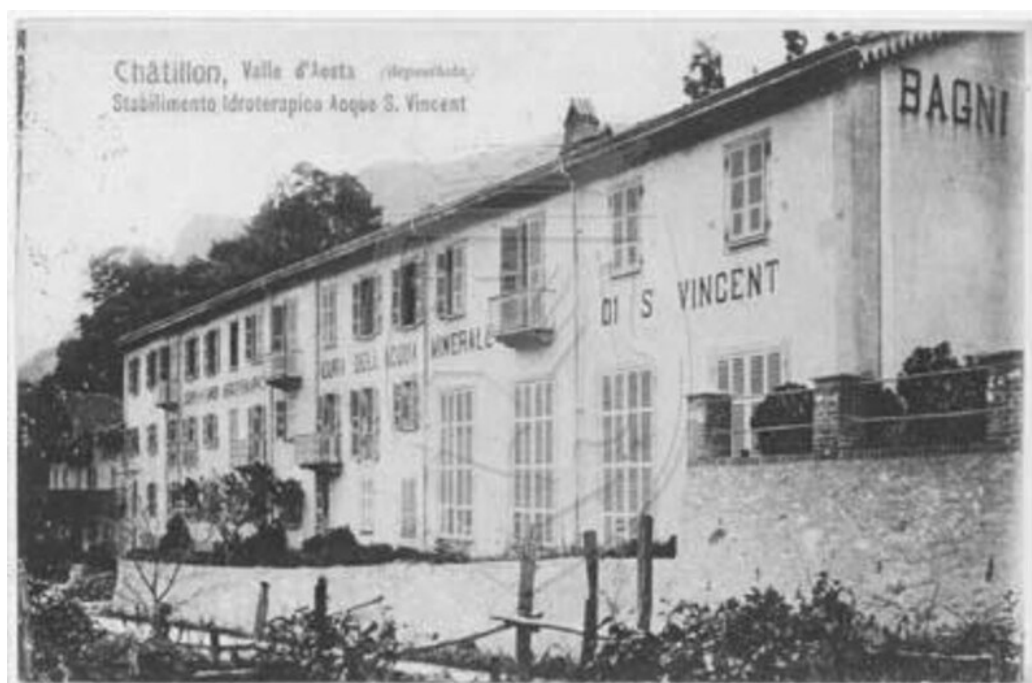
Fig. 22 Lo stabilimento idroterapico di Châtillon Di Autore non identificato, Stabilimento idroterapico , Regione Autonoma Valle d'Aosta, Archivio BREL, Fondo Domaine, 1900-1904, disponibile al sito https://new.regione.vda.it/servizi/mediateca/mediateca , u.c. 12/01/2024
