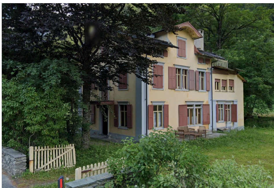
Fig. 39 La villa come si presenta oggi nascosta da alberi ad alto fusto Foto dell'autore 31/07/23
