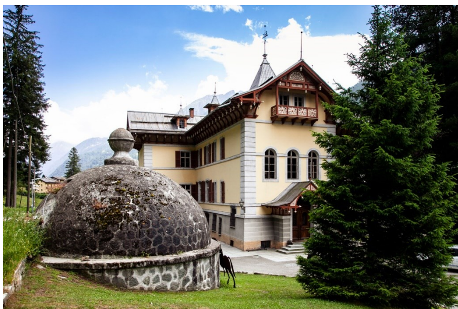
Fig. 4 La ghiacciaia nella parte retrostante dove è possibile osservare la botola e il parziale interrimento della struttura Foto dell'autore 31/07/23
