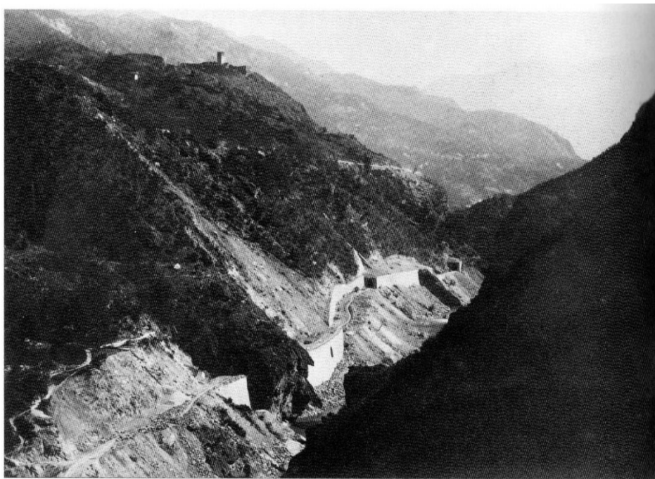
Fig. 18 La ferrovia in costruzione nel maggio 1884 nella gola di Montjovet Da Stuart J. WOOLF, La valle d'Aosta , Einaudi, Torino 1995
