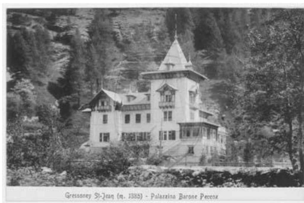
Fig. 11 La Palazzina Beck Peccoz dal lato ovest Di Autore non identificato, Villa Margherita dei baroni Beck Peccoz , Regione Autonoma Valle d'Aosta, Archivio BREL, Fondo Domaine, 1900 - 1909, disponibile al sito https://new.regione.vda.it/servizi/mediateca/mediateca , u.c. 15/01/2024
