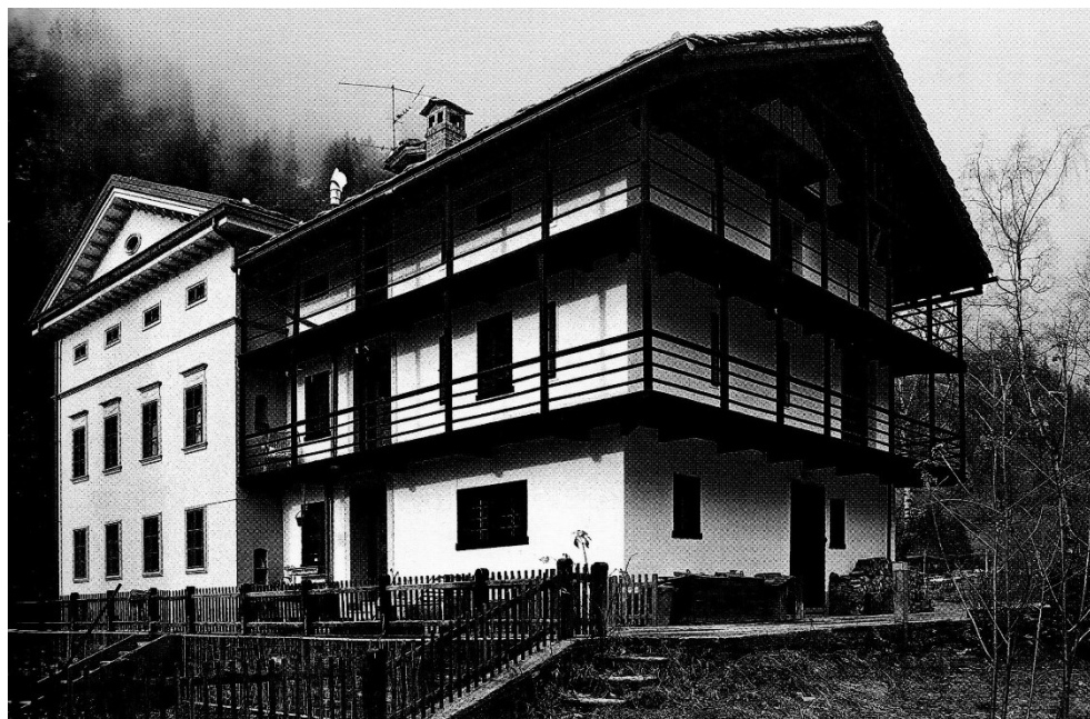
Fig. 32 Il fabbricato rurale addossato alla villa principale Da Mauro ZUCCA PAUL, Danilo MARCO, Claudine REMACLE, Abitare walser: l'architettura storica nell'alta valle del Lys , Le château, Aosta 2006, p. 103
