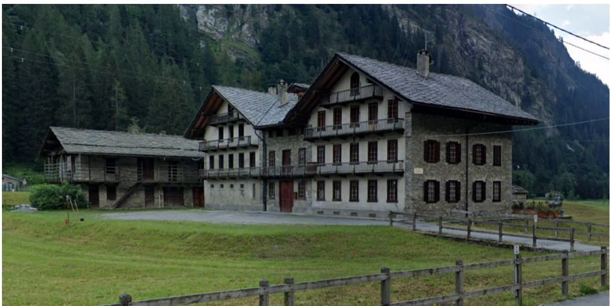
Fig. 30 Come si presenta la parte retrostante di Casa Sendre oggi con accanto l'edificio a funzioni rurali Foto dell'autore 31/07/23
