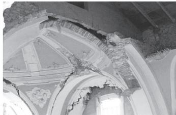
Volta a vela ribassata presbiteriale con il box in c.a. sovrastante e dettaglio del rinforzo in fibre di carbonio distaccate dall'intradosso degli archi di sostegno della volta dopo il sisma. **1**
