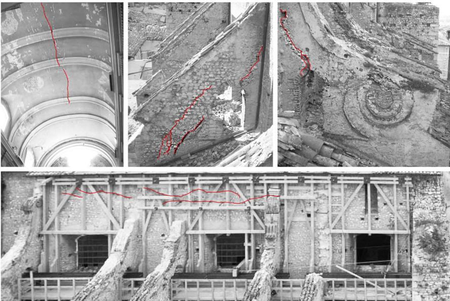
Figg. 3.21-3.24, Quadro fessurativo della volta della navata centrale e dei contrafforti esterni che testimoniano il movimento trasversale. G. Cacciaguerra, M. Piazza, M. P. Gatti, R. Tomasi, D. Zonta, *La chiesa di S. Margherita... op. cit.*
