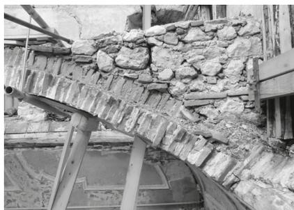
Fig. 2.21, Elementi lignei collocati alla quota delle reni della volta a padiglione in Palazzo Ardinghelli. C. Carocci, C. Tocci, *Le tecniche costruttive...* op. cit., p. 32.
