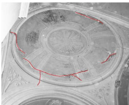
Fig. 3.38, Lesioni circolari nelle volte a vela ribassate delle navate laterali. CNR-ITC, *Casi studio... op. cit.*
