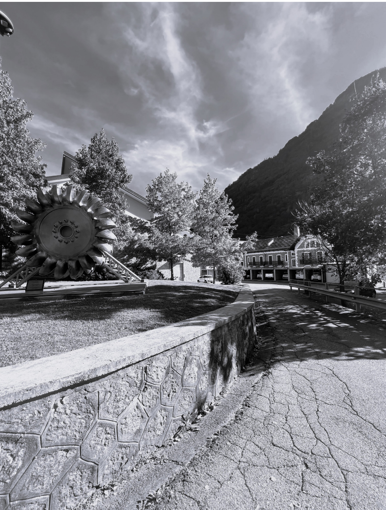
Ingresso alla Centrale di Rosone, Locana (TO). Autrici della fotografia: Celozzi, M. e Fiorino, L.
