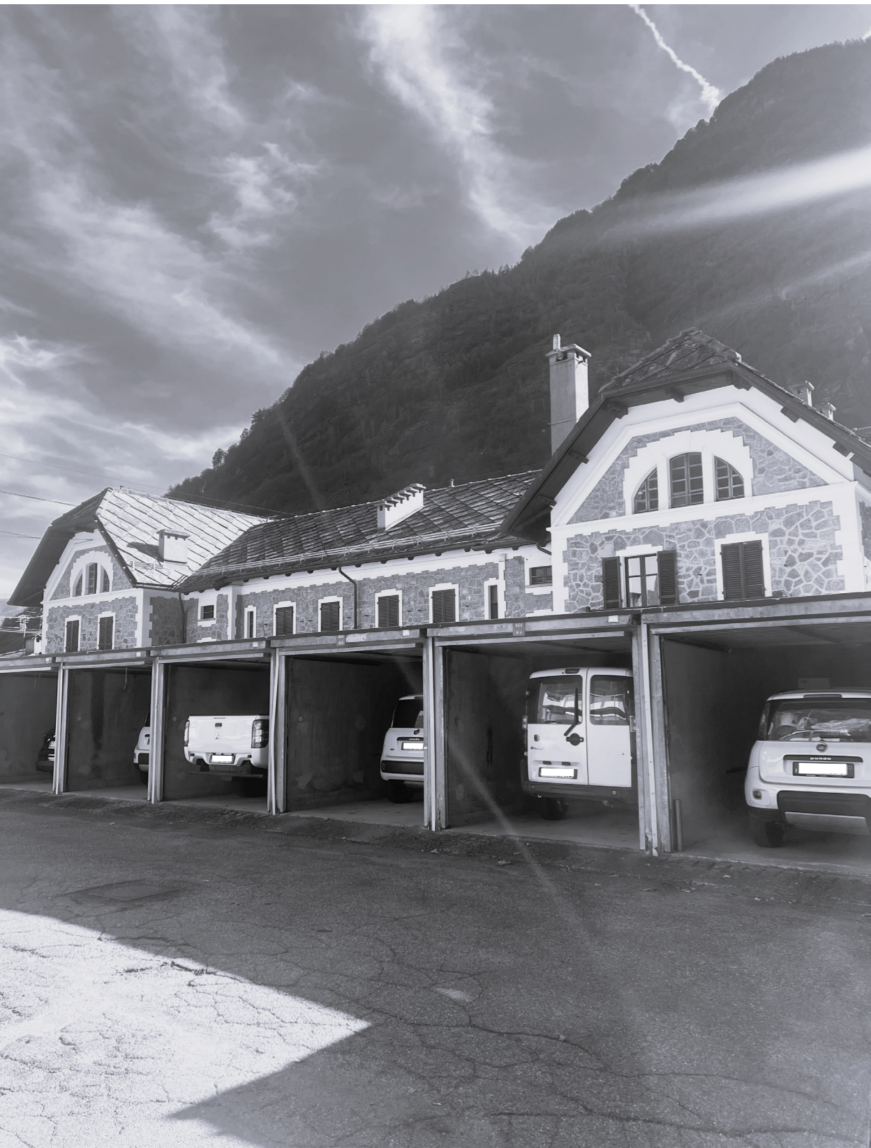
Parcheeggi della Centrale di Rosone, Locana (TO). Autrici della fotografia: Celozzi, M. e Fiorino, L.
