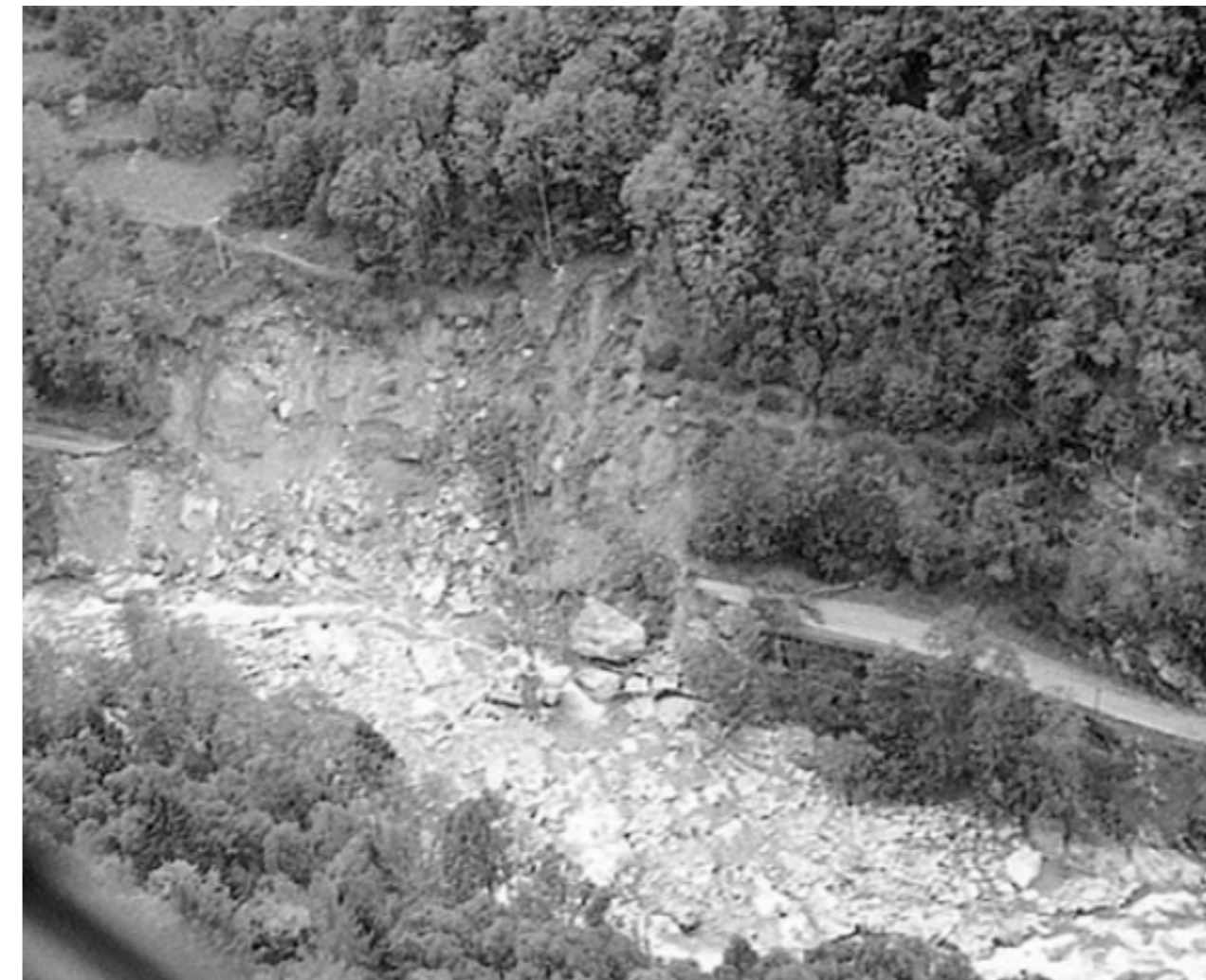
Foto 1. Strada provinciale Sparone-Ribordone, interrotta da una frana per scalzamento al piede.
