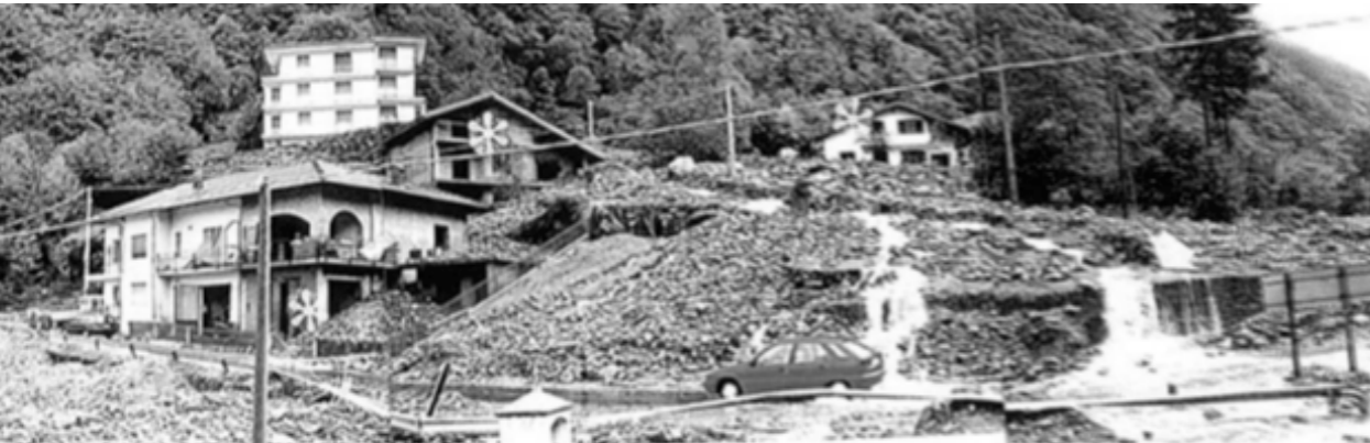
Foto 2. Attivazione del conoide di Bardonetto Superiore (Locana). Gli asterischi indicano le abitazioni danneggiate, la freccia indica il manufatto di attraversamento della Strada Statale, completamente ostruito.
