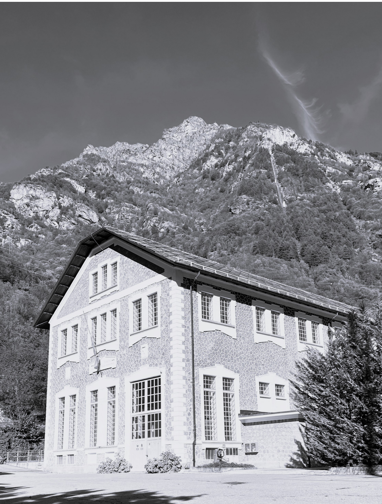
Centrale idroelettrica di Rosone, Locana (TO). Autrici della fotografia: Celozzi, M. e Fiorino, L.
