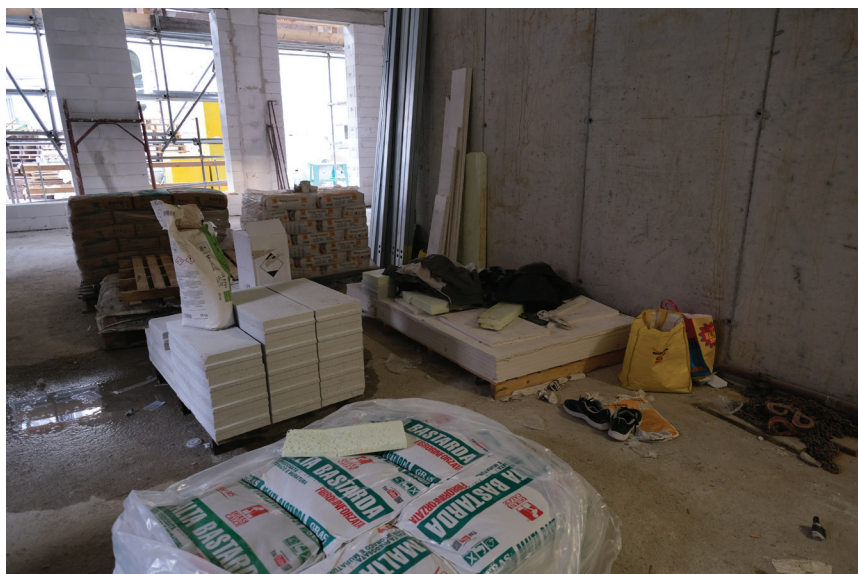
↓ Materiale edile stoccato al piano terra, nei pressi dell'entrata del cantiere
