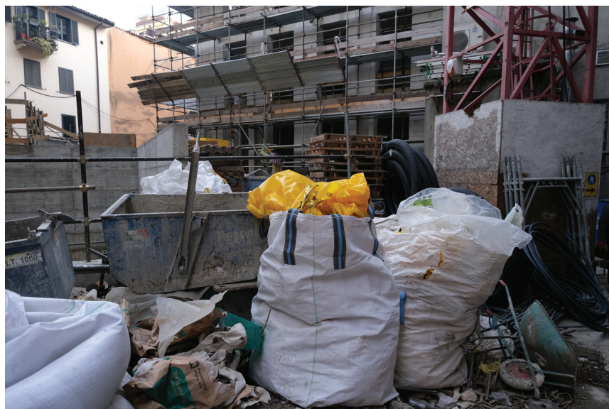
↑ Deposito temporaneo contenente Cassoni e Big Bag, presso il cantiere di Gate Central (Milano)
