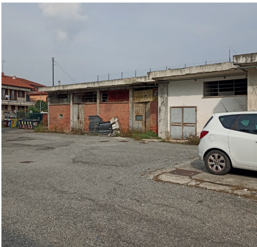
Figura 10 - Basso fabbricato visto dal cortile interno
