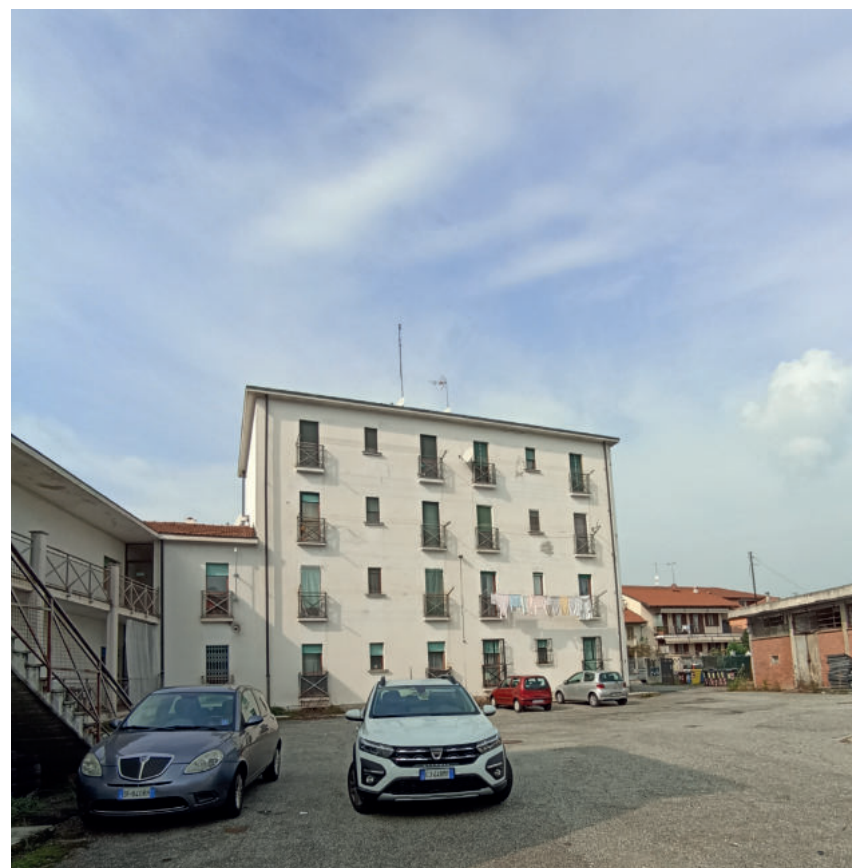
Figura 12 - Vista dell'edificio residenziale e della manica dell'ASL
