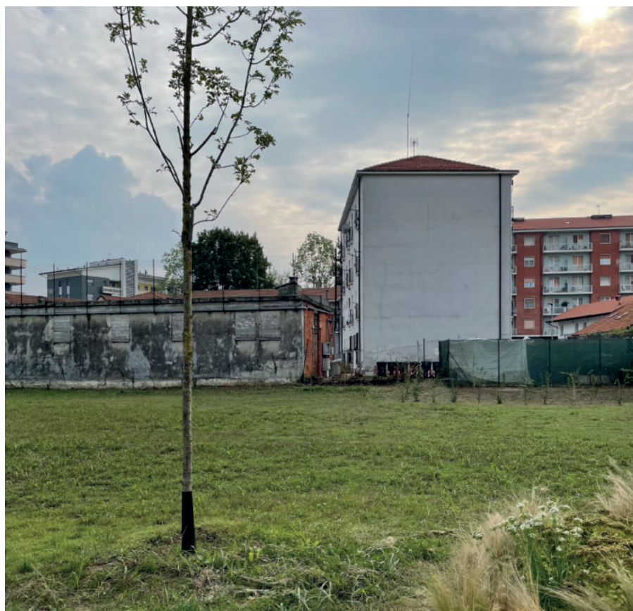
Figura 4 - Vista dal parco degli edifici
