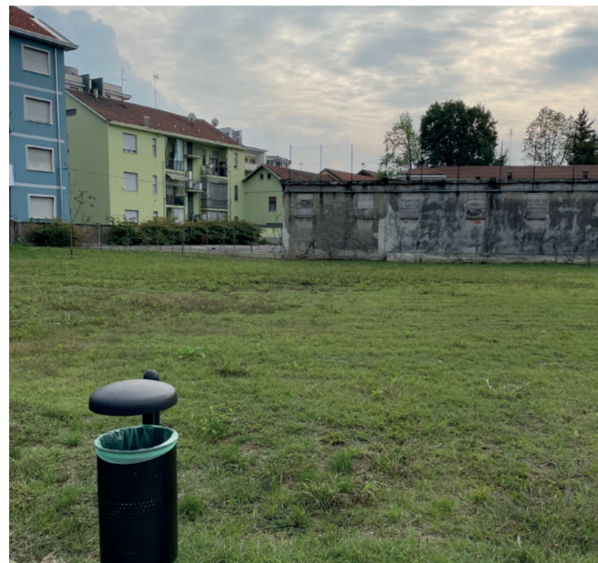
Figura 5 - Vista dal parco del basso fabbricato
