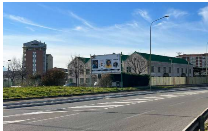
Figura 8: Facciata esterna da corso Tirreno
