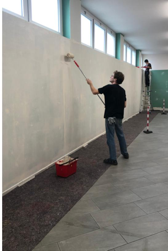
**Figg.90-91:** *Levigazione muri e verniciatura di base*
