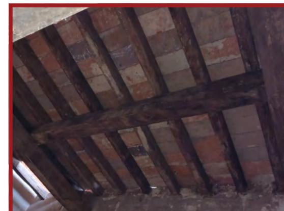
**Figura 3.3.1.20** - Particolare dell'orditura lignea della copertura degli ambienti del primo piano della manica sud-est. Fotografia dell'autrice del 07/09/2023.
