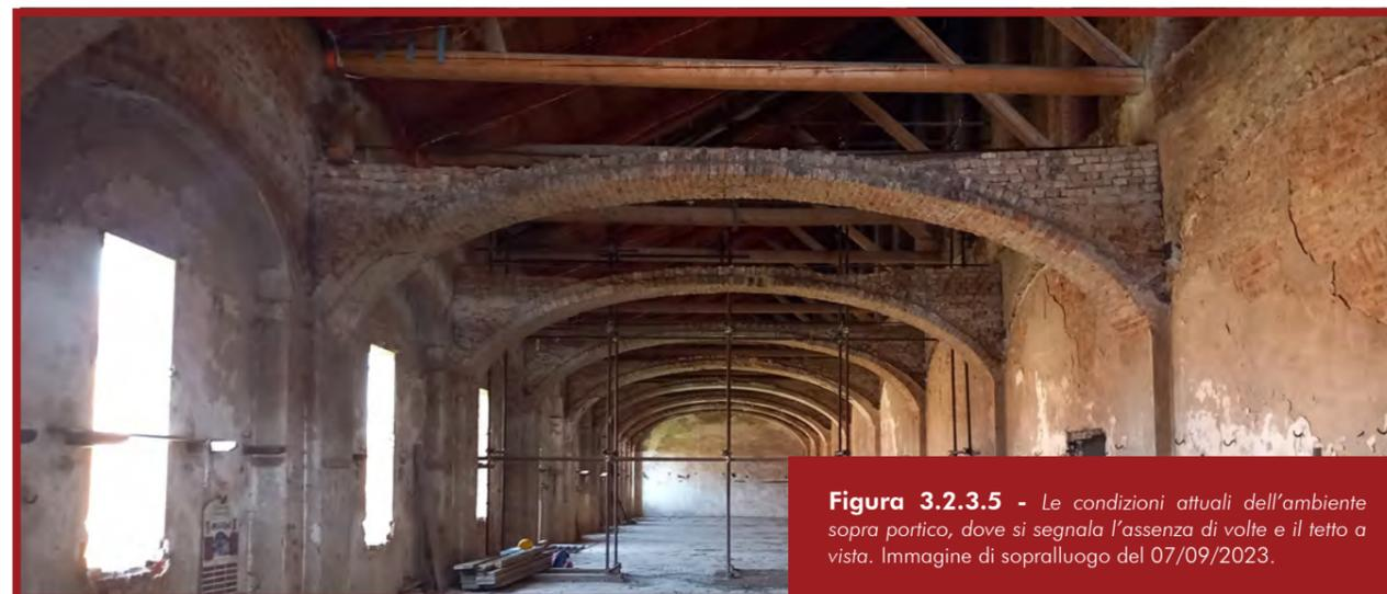
**Figura 3.2.3.5** - Le condizioni attuali dell'ambiente sopra portico, dove si segnala l'assenza di volte e il tetto a vista. Immagine di sopralluogo del 07/09/2023.
