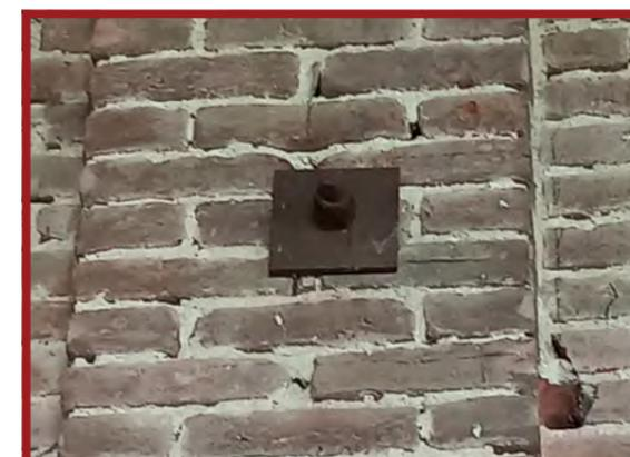
**Figura 3.3.1.25** - Dettaglio del capochiave contemporaneo, posizionato lungo la parete di spina del portico. Fotografia dell'autrice del 12/09/2023.
