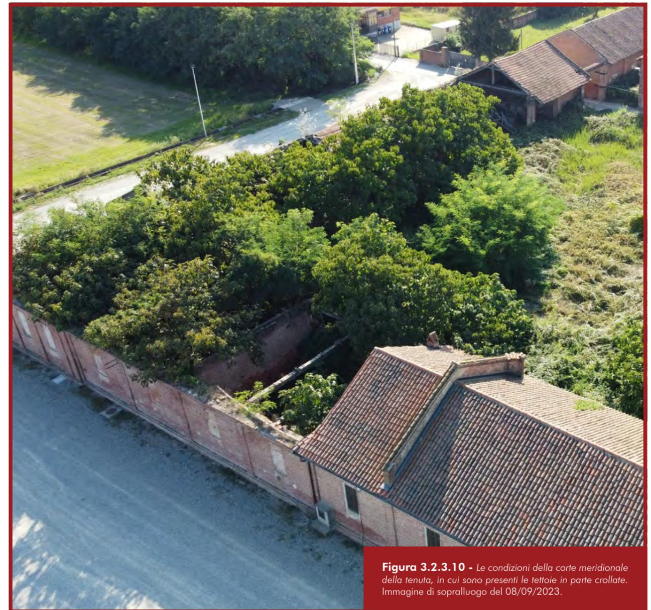
**Figura 3.2.3.10** - Le condizioni della corte meridionale della tenuta, in cui sono presenti le tettoie in parte crollate. Immagine di sopralluogo del 08/09/2023.
