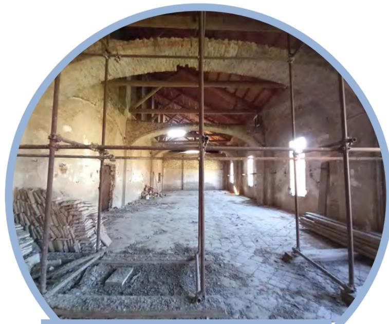
**Figura 5.2.1.7** - Lo spazio del sovra-portico, deputato a Salone Polifunzionale. Spazio peculiare in cui manca il sistema voltato di copertura. Fotografia dell'autrice del 07/09/2023.
