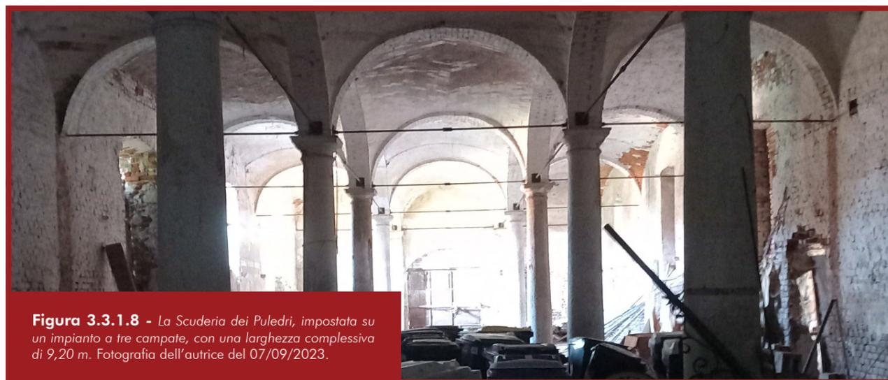
**Figura 3.3.1.8** - La Scuderia dei Puledri, impostata su un impianto a tre campate, con una larghezza complessiva di 9,20 m. Fotografia dell'autrice del 07/09/2023.
