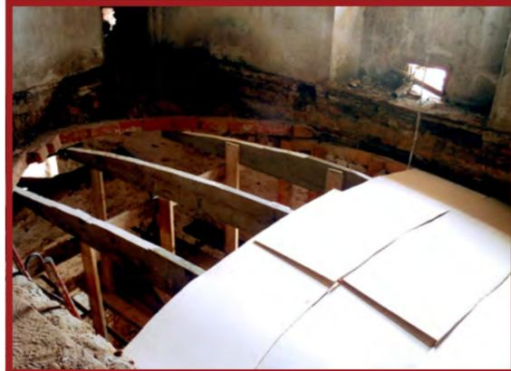
**Figura 3.2.2.13** - Centinatura e struttura provvisoria per il rifacimento della volta rimossa. Fonte dell'immagine: Ufficio al Patrimonio Comune di Chivasso (2007).
