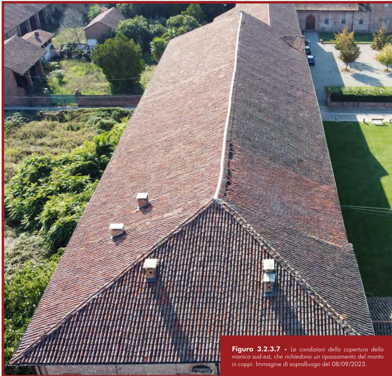
**Figura 3.2.3.7** - Le condizioni della copertura della manica sud-est, che richiedono un ripassamento del manto in coppi. Immagine di sopralluogo del 08/09/2023.
