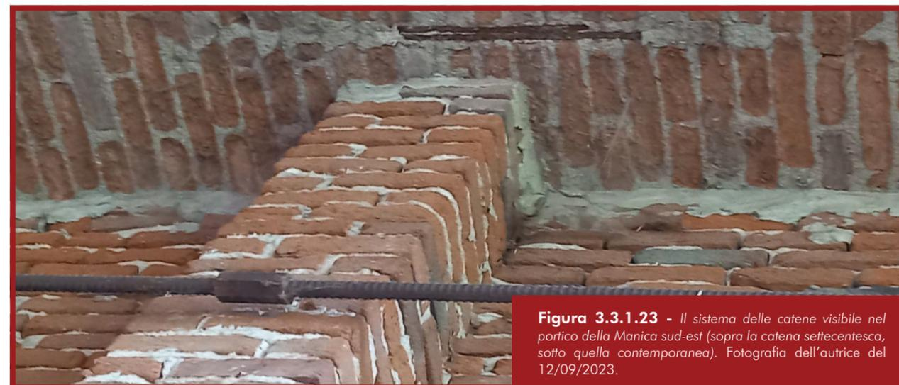
**Figura 3.3.1.23** - Il sistema delle catene visibile nel portico della Manica sud-est (sopra la catena settecentesca, sotto quella contemporanea). Fotografia dell'autrice del 12/09/2023.
