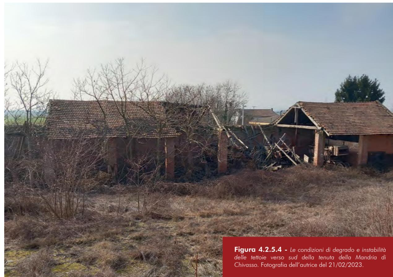
**Figura 4.2.5.4** - Le condizioni di degrado e instabilità delle tettoie verso sud della tenuta della Mandria di Chivasso. Fotografia dell’autrice del 21/02/2023.
