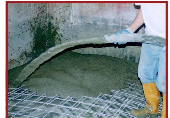
**Figura 3.2.2.21** - Riempimento dell'estradosso delle volte mediante massetto alleggerito. Fonte dell'immagine: Ufficio al Patrimonio Comune di Chivasso (2007).
