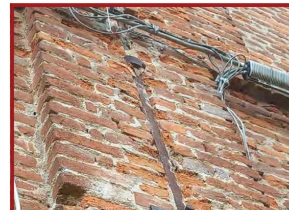
**Figura 3.3.1.24** - Dettaglio del capochiave settecentesco, posizionato sul prospetto verso la piazza della manica sud-est. Fotografia dell'autrice del 12/09/2023.
