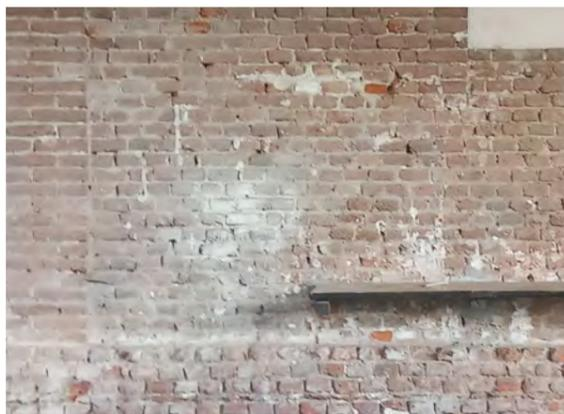
**Figura 2.3.2.47** - Il ripristino della muratura ammalorata tramite la sigillatura degli elementi in laterizio. Fotografia dell'autrice del 07/07/2023.
