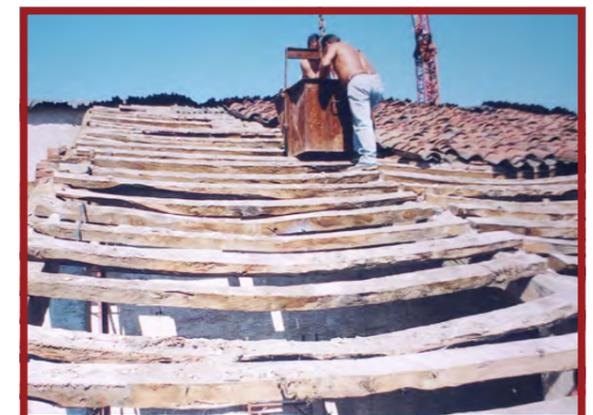
**Figura 3.2.2.3** - Rimozione e accatastamento del manto di copertura. Foto di cantiere. Fonte dell'immagine: Ufficio al Patrimonio Comune di Chivasso (2005).
