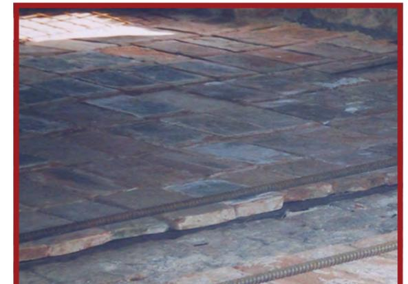
**Figura 3.2.2.23** - Posizionamento del sistema di catene all'estradosso del solaio del piano primo. Fonte: Ufficio al Patrimonio Comune di Chivasso (2007).
