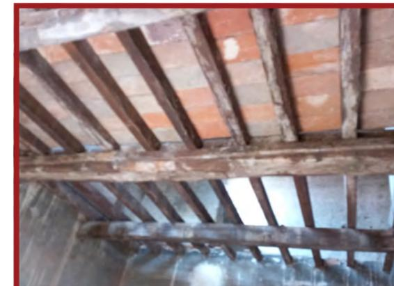
**Figura 3.3.1.19** - Particolare dell'orditura lignea della copertura degli ambienti del primo piano della manica sud-est. Fotografia dell'autrice del 07/09/2023.
