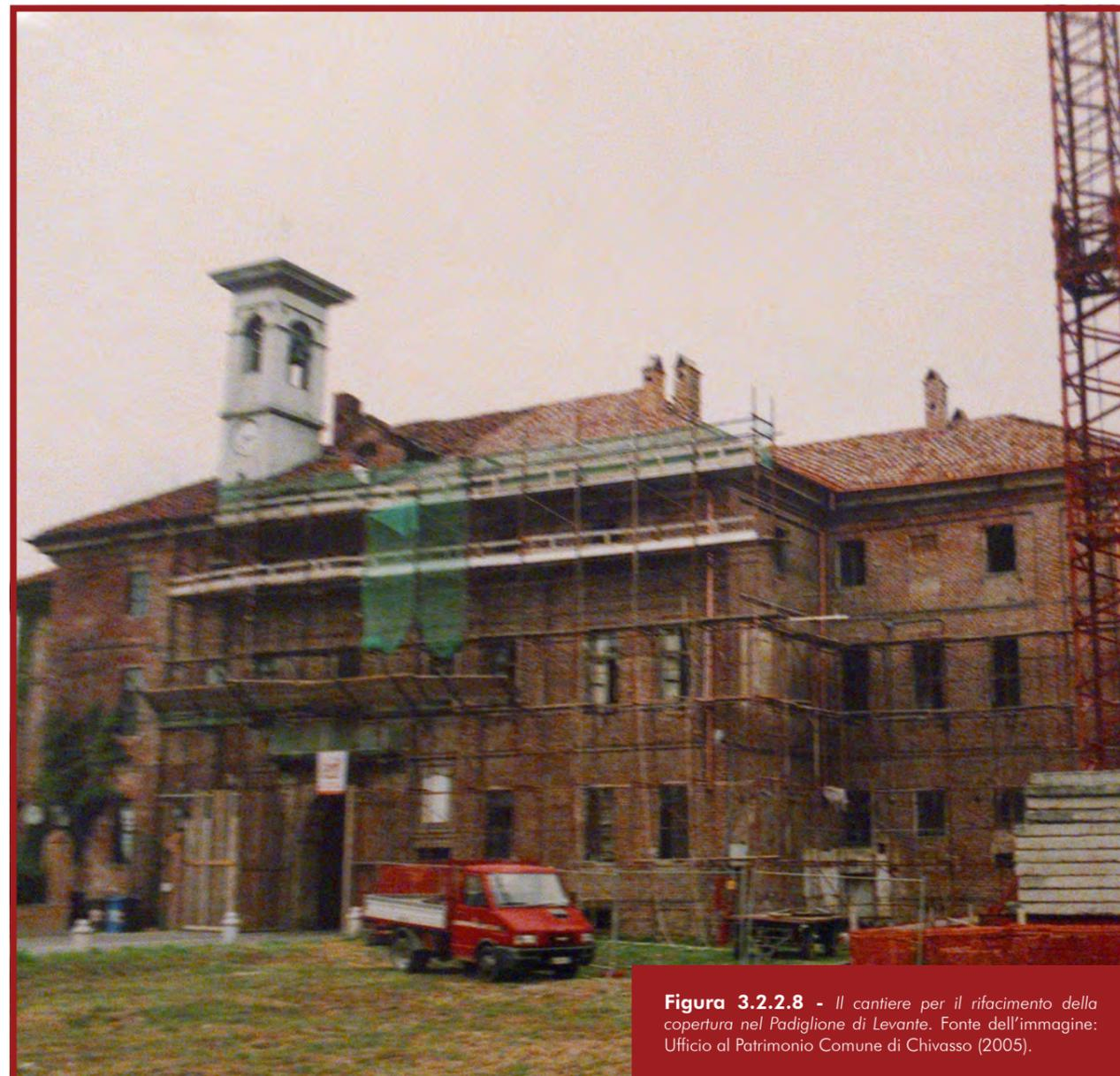
**Figura 3.2.2.8** - Il cantiere per il rifacimento della copertura nel Padiglione di Levante. Fonte dell'immagine: Ufficio al Patrimonio Comune di Chivasso (2005).
