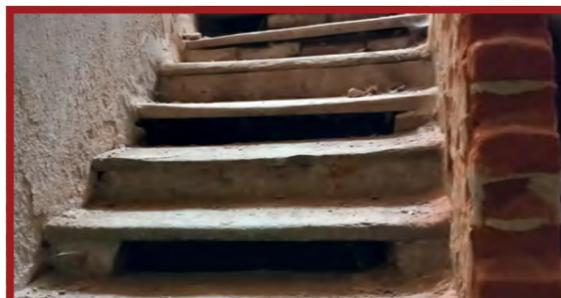
**Figura 3.2.3.1** - Le condizioni di degrado e precarietà del vano scala della manica sud-est. Immagine di sopralluogo del 21/02/2023.
