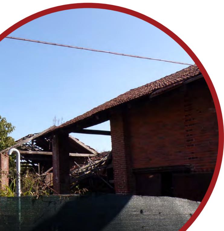
**Figura 5.2.1.3** - Le tettoie della manica meridionale, soggette a crolli dovuti all'incuria e al non utilizzo delle strutture. Fotografia dell'autrice del 17/10/2021 - Giornate d'Autunno del FAI.
