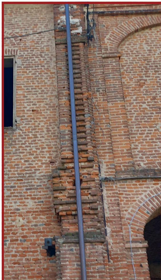
**Figura 3.3.1.21** - L'innesto dell'eventuale avancorpo posizionato lungo il prospetto verso la piazza della manica sud-est. Fotografia dell'autrice del 21/02/2023.
