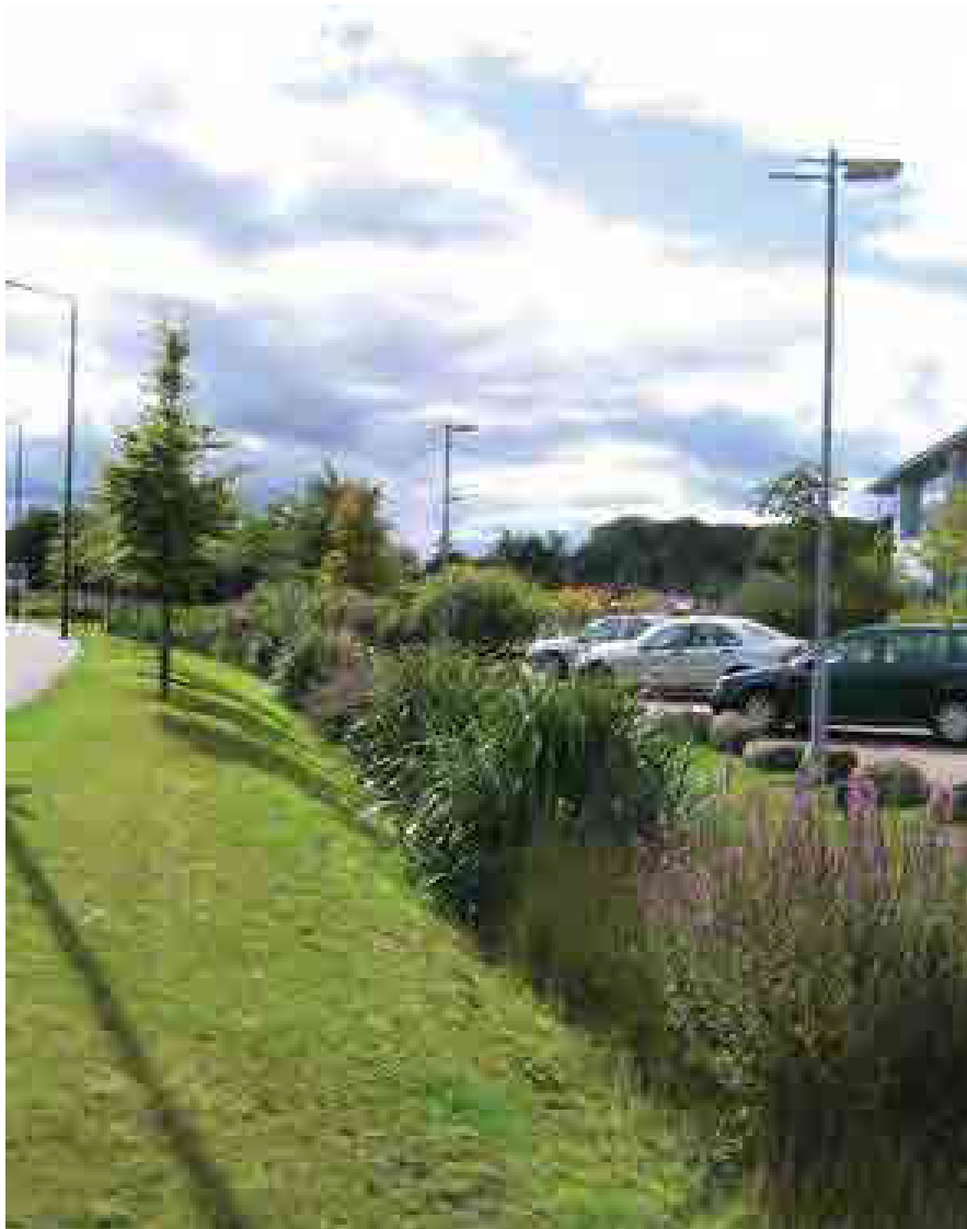
Fig 2.16 Esempio di canale vegetale (Woods Ballard, 2015)
