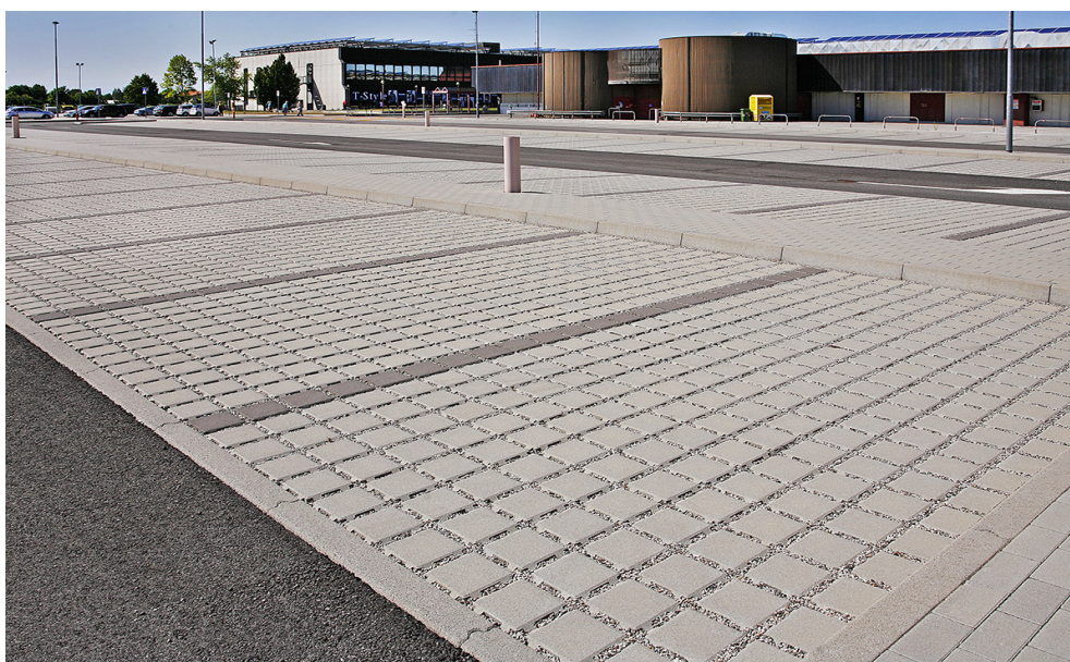
Fig 2.8 Esempio di pavimentazione permeabile modulare ( www.senini.it )
