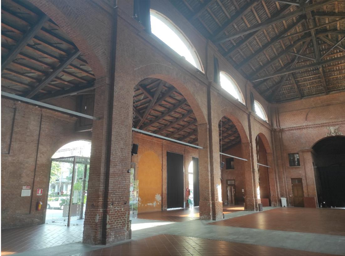
Tetto della navata centrale realizzato in coppi, invece nelle navate laterali vengono utilizzate delle pietre particolari chiamate "lose" (foto personale del 21/07/2023)
