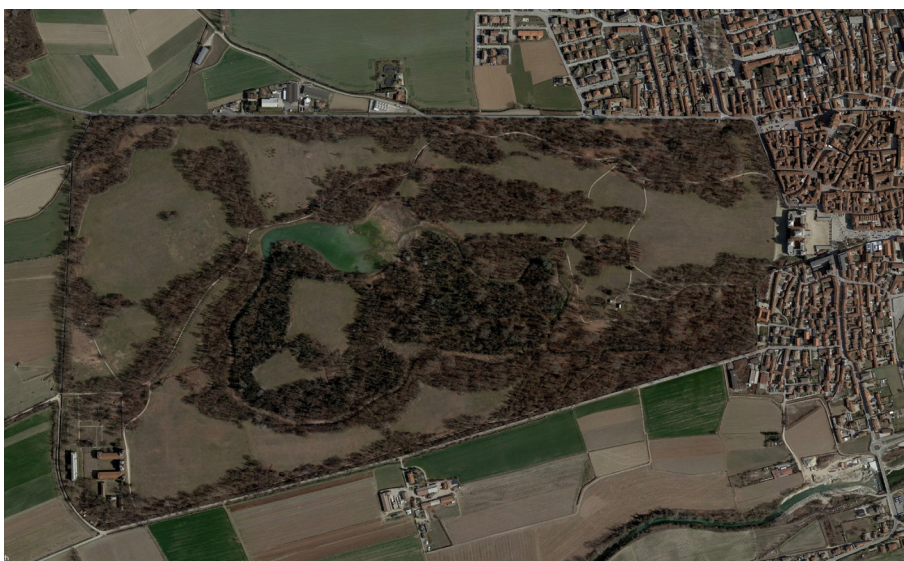
Fig. A Vista aerea attuale, si noti la cancellazione delle tracce del teatro di verzura.
