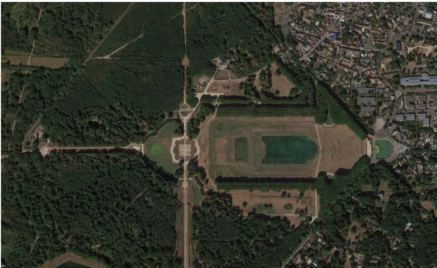
Fig. A Vista aerea attuale, si noti la cancellazione delle tracce del teatro di verzura.
