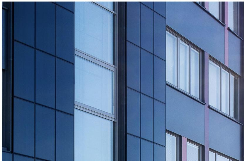
Figura 5.35 - Focus modulo fotovoltaico a totale integrazione in facciata
