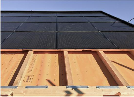
I moduli fotovoltaici sono posati sopra i listelli del tetto in legno
