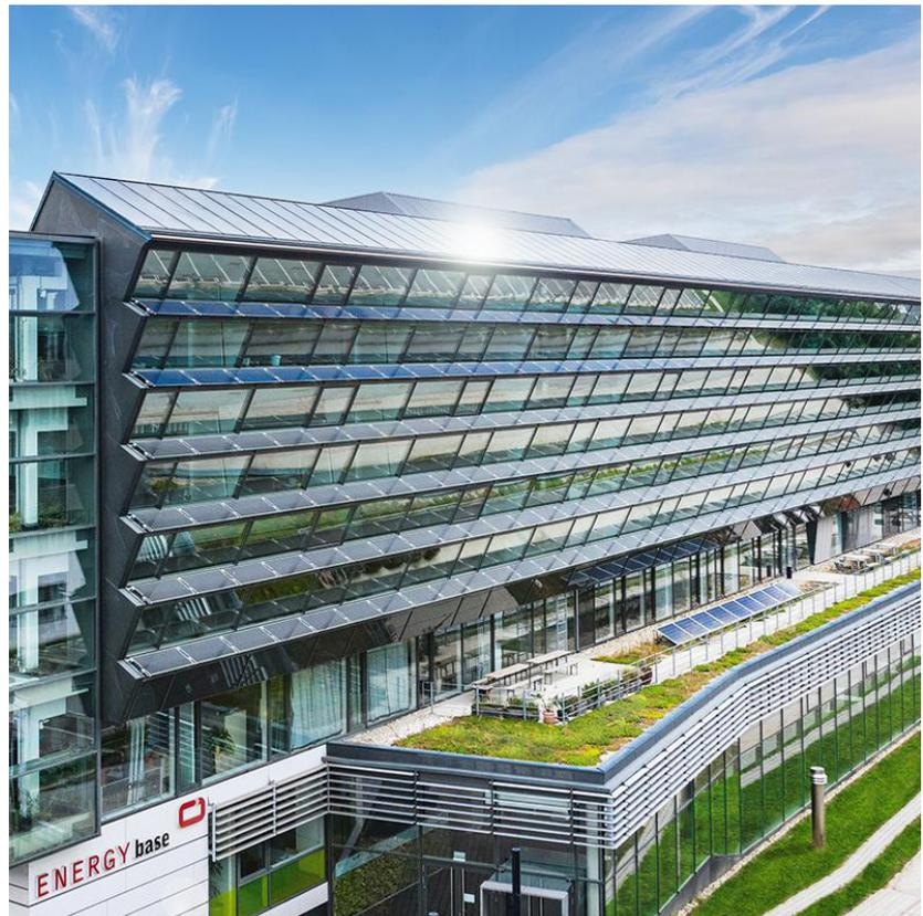
Figura 5.38 - Focus modulo fotovoltaico a totale integrazione in facciata
