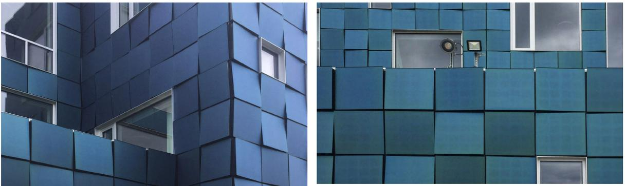
Figura 5.34 - Dettaglio della facciata BIPV
