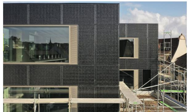
Figura 5.27 - Modulo solare in prospettiva
