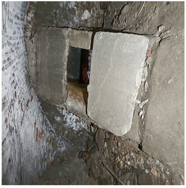
d2 Demolizione di una struttura per la raccolta dell'acqua piovana e di una canalizzazione di scarico
