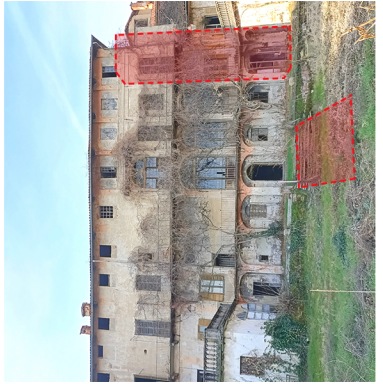
c2 Realizzazione di un ascensore e di una rampa sul prospetto nord
