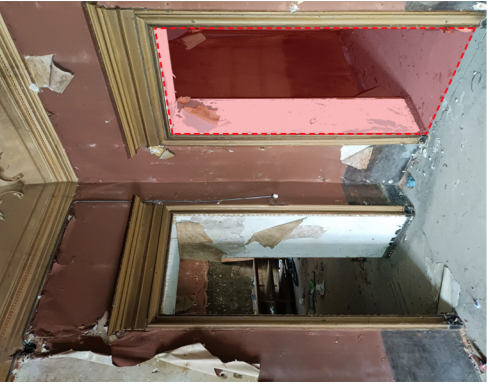
c4 Tamponatura di una porta per realizzare una camera da letto
