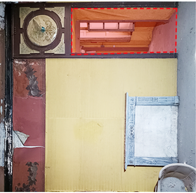
c6 Tamponatura di una porta per realizzare una camera da letto
