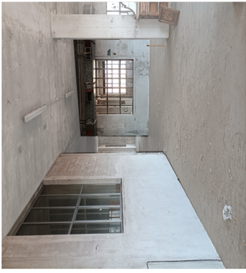
d7 Demolizione di una parete e di una campata per realizzare uno spazio espositivo e un ascensore
