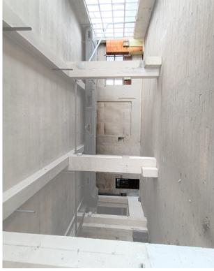
d4 Demolizione di una parete e di una campata per realizzare uno spazio espositivo e un ascensore
