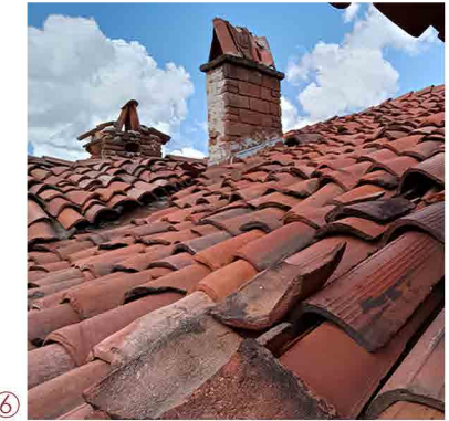
particolare del manto di copertura in coppi
