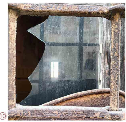
particolare dell'infisso costituito da un vetro singolo
