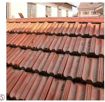
particolare del manto di copertura in tegole marsigliesi
