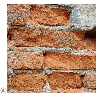
particolare della malta di allettamento
