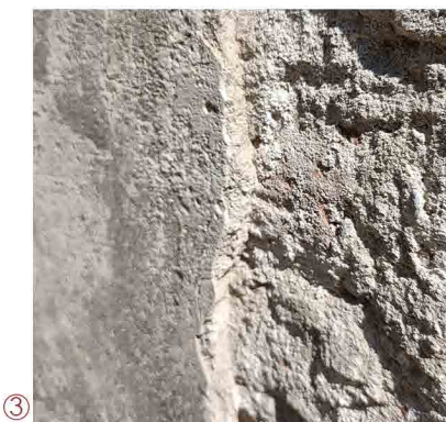
particolare dello spessore dell'intonaco (2 cm)
