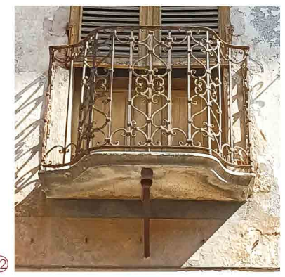
particolare dei parapetti dei balconi e mensola
