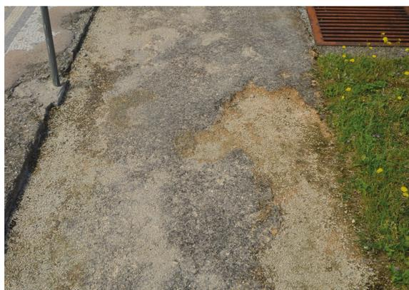
Fig. 3: Sconnessioni del percorso in battuto di cemento.
