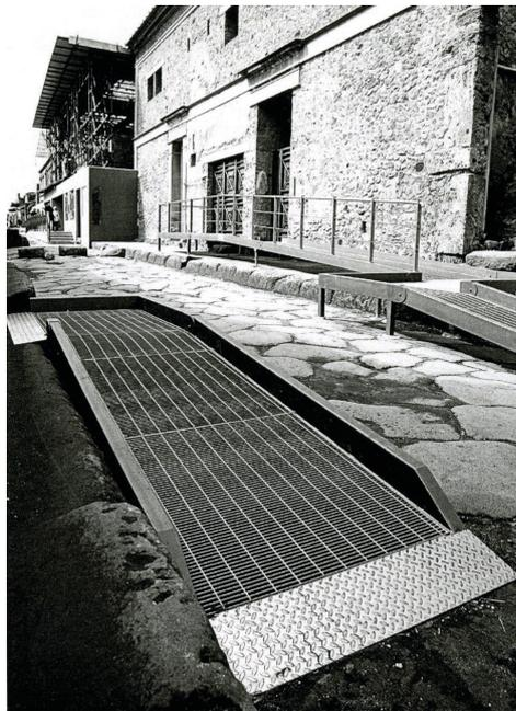
Fig. 17: Alcune passerelle realizzate nell'ambito del Progetto *Friendly Pompeii*.
