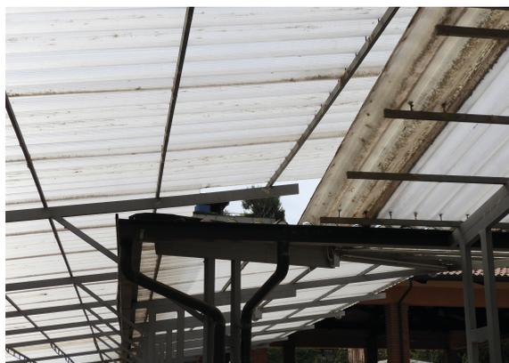
Fig. 38: Presenza di degrado nella copertura.
