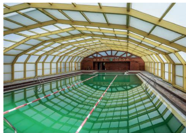
Fig.2 Vista interna della vasca prima dei lavori.
