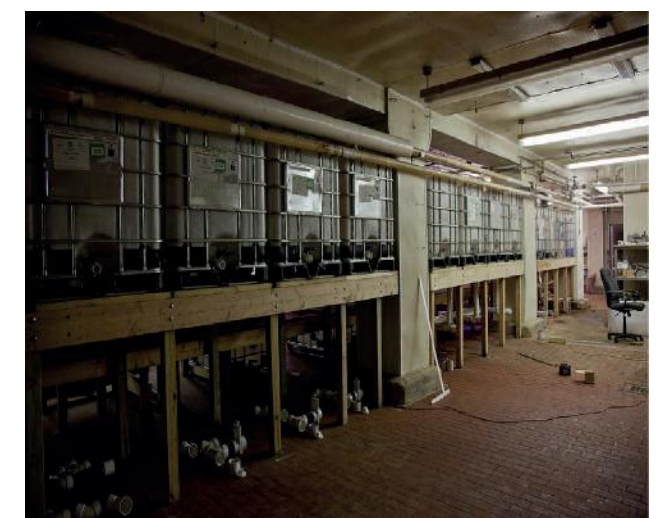
Fig.2 Vista interna dell'edificio prima dei lavori.
