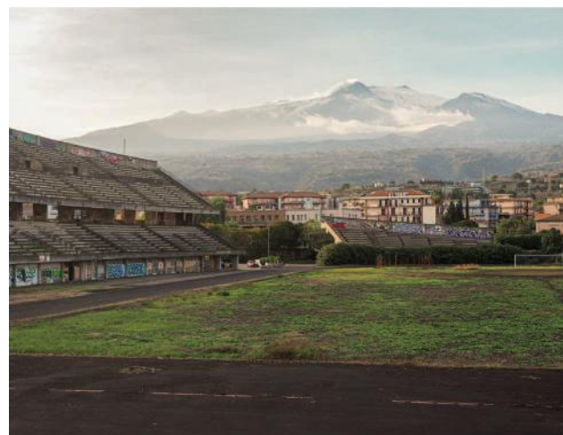
Fig.1 Visione d'insieme dell'impianto sportivo.
