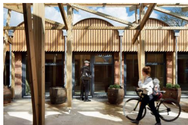
Fig.2 Vista esterna: circolazione orizzontale sotto la tettoia lignea.
