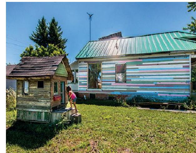
Fig.1 Vista esterna della Power House .
