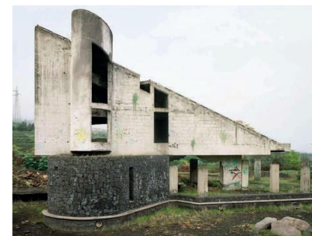
Fig.2 Prospetto principale della Bambinopoli.
