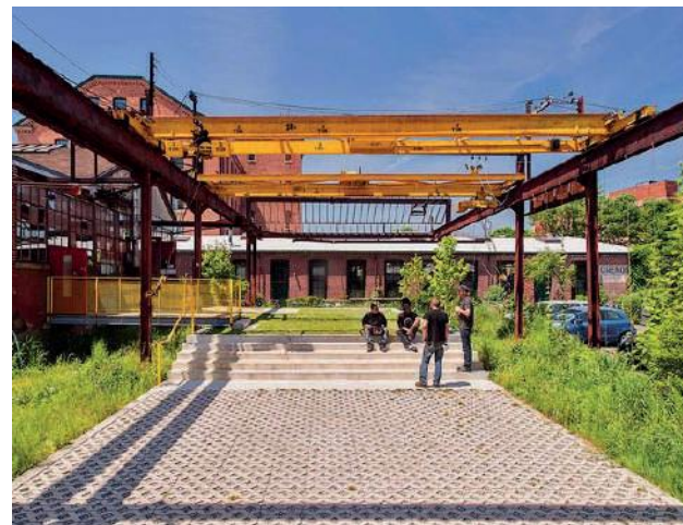
Fig.2 Vista degli spazi di circolazione con pavimentazione permeabile.
