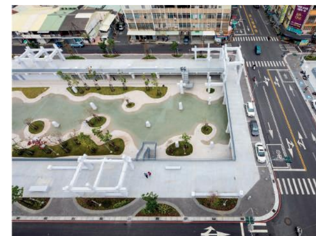
Fig.1 Vista a volo d'uccello del progetto realizzato.
