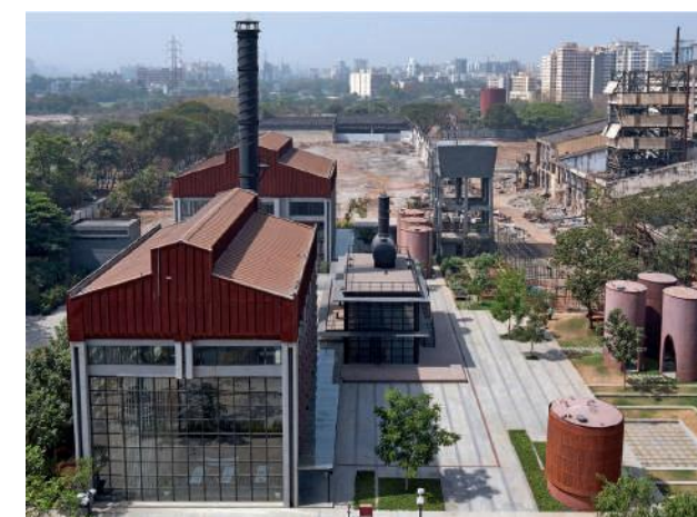
Fig.1 Vista a volo d'uccello del complesso di edifici.
