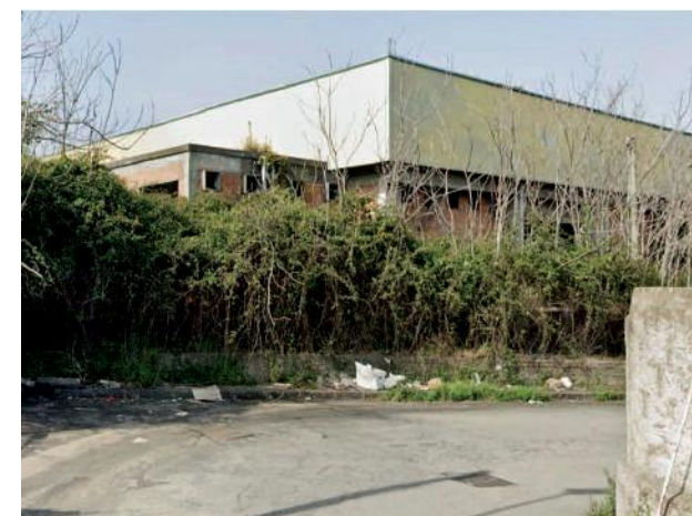
Fig.1 Vista esterna della piscina.
