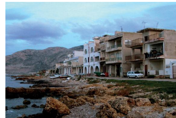
Fig.3 Edifici abusivi sul lungomare di Carini (PA).
