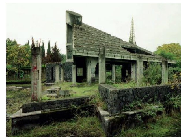
Fig.1 Vista d'insieme della struttura della Bambinopoli.
