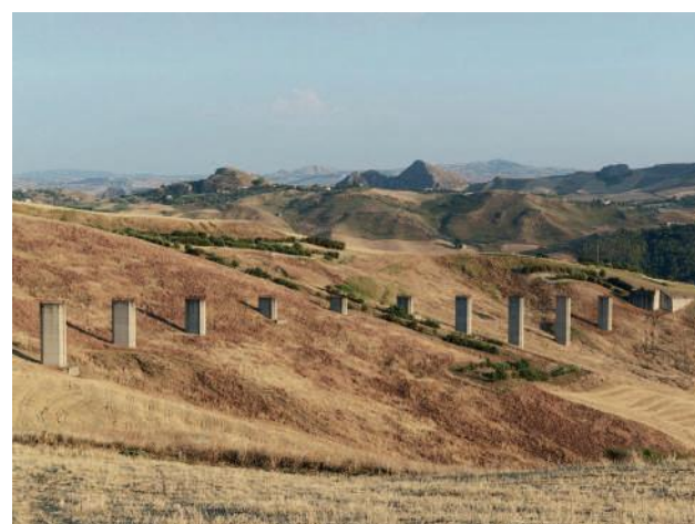
Fig.5 Viadotto, Mussomeli (CL).
