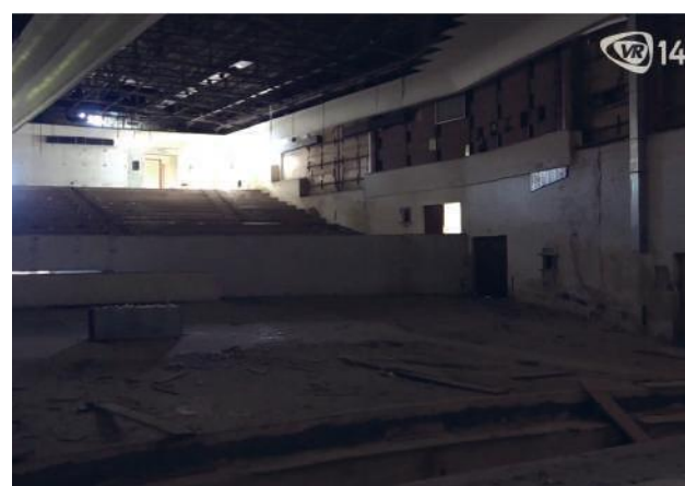
Fig.2 Vista interna del Teatro Nuovo.
