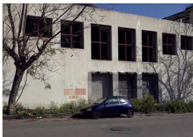
Fig.1 Prospetto principale del Teatro Nuovo.
