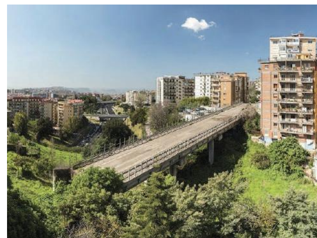
Fig.5 Viadotto San Giacomo dei Capri, Napoli.
