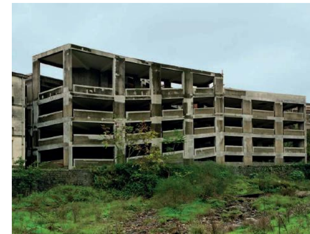
Fig.5 Incompiuta del Parcheggio multipiano di Piazza Iolanda.
