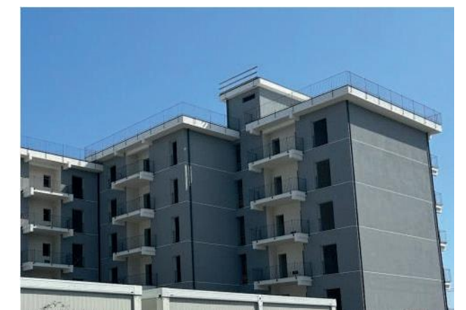
Fig.8 Palazzine di via Trieste in cantiere.
