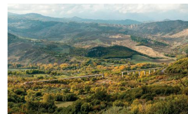
Fig.3 Viadotto Barche, Bomba (CH).
