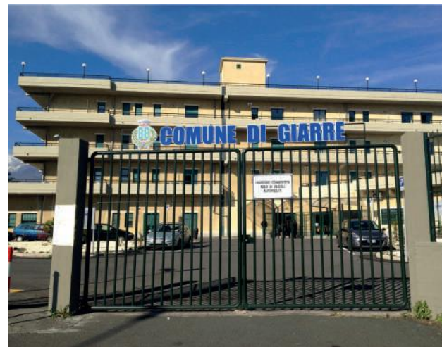
Fig.2 Uffici comunali del Comune di Giarre.
