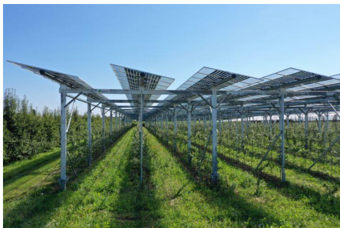
Figura 12: Sistema agrivoltaico sopraelevato [19]
