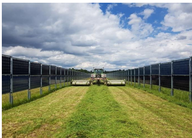
Figura 14: Sistema agrivoltaico verticale bifacciale (Next2Sun) [21]
