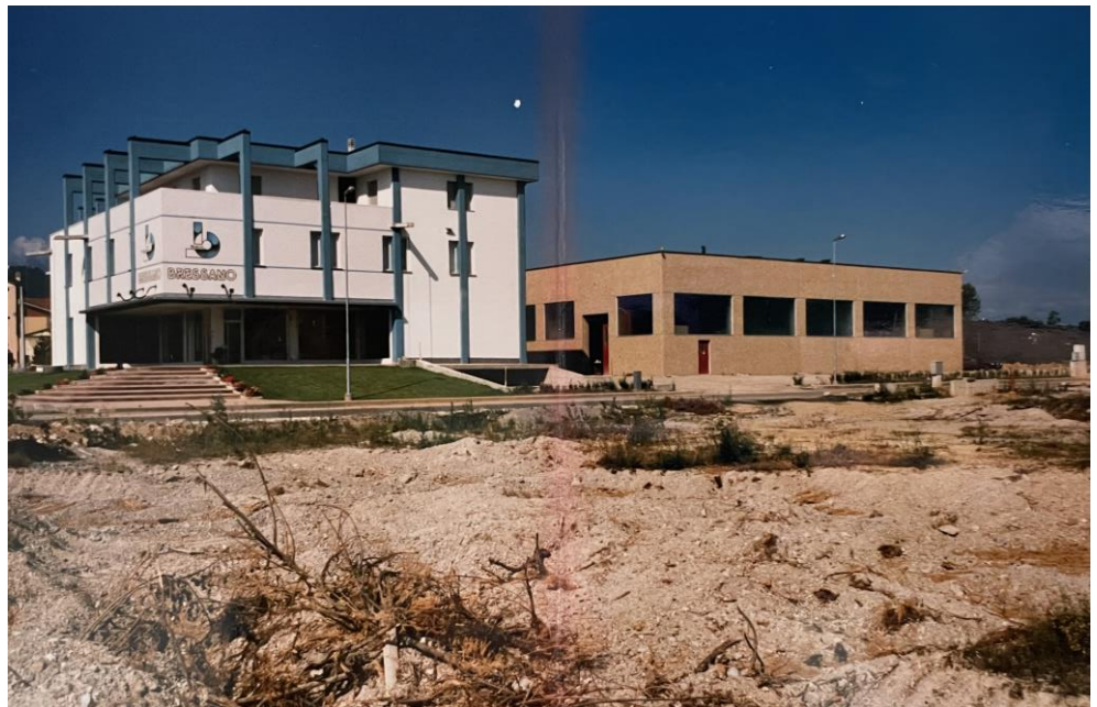
Figura 7: Negozio con esposizione e capannone durante la fase di completamento.
