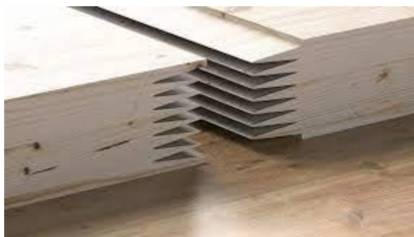
Figura 12: Dettaglio giuntura "finger joint"
