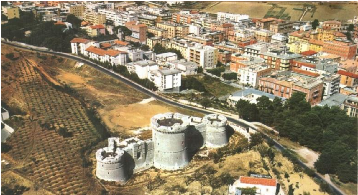
FIGURA 35: Veduta del Castello tramontano
