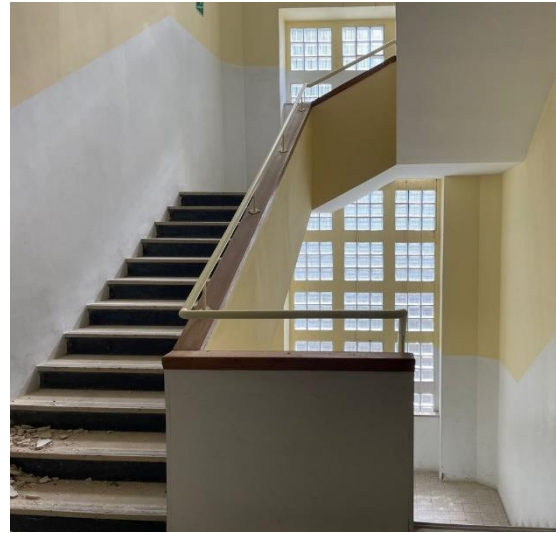
FIGURA 61: Vetromattone all'interno del vano scala
