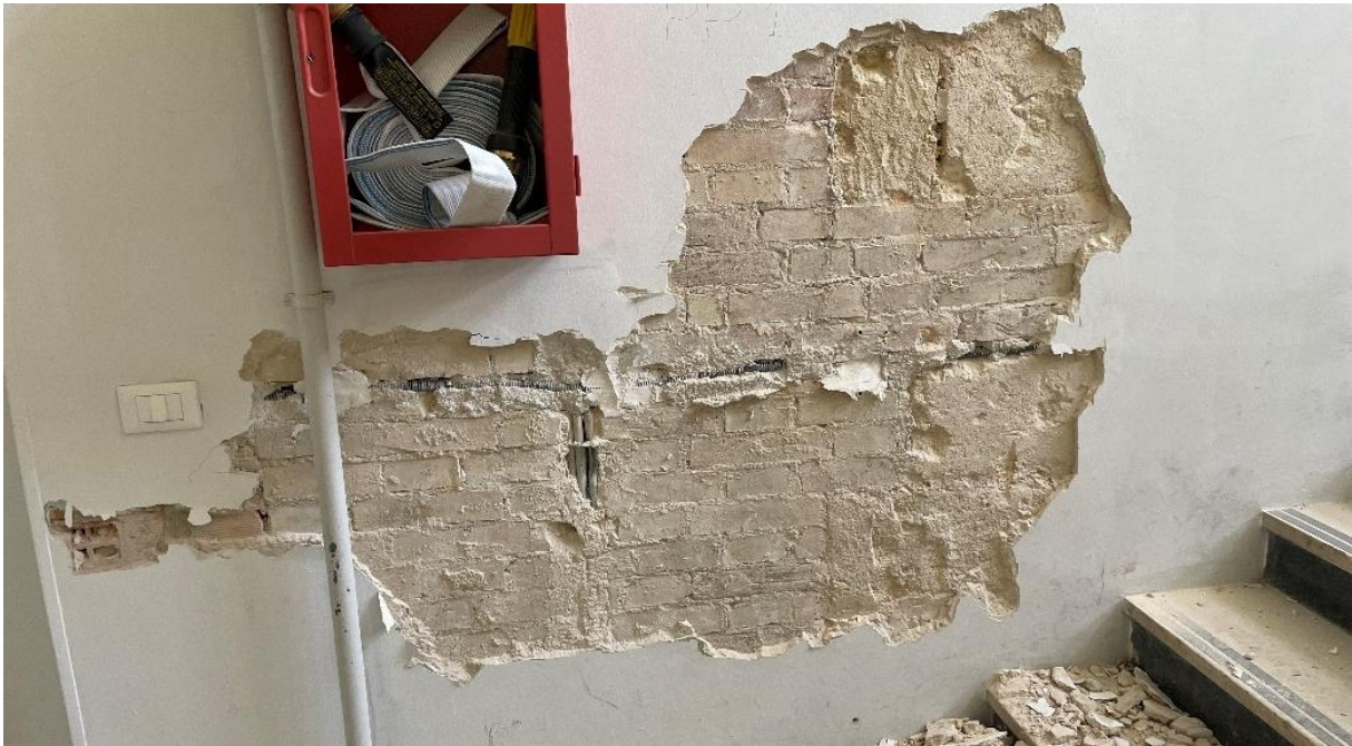
FIGURA 54: Saggio parete vano scala
