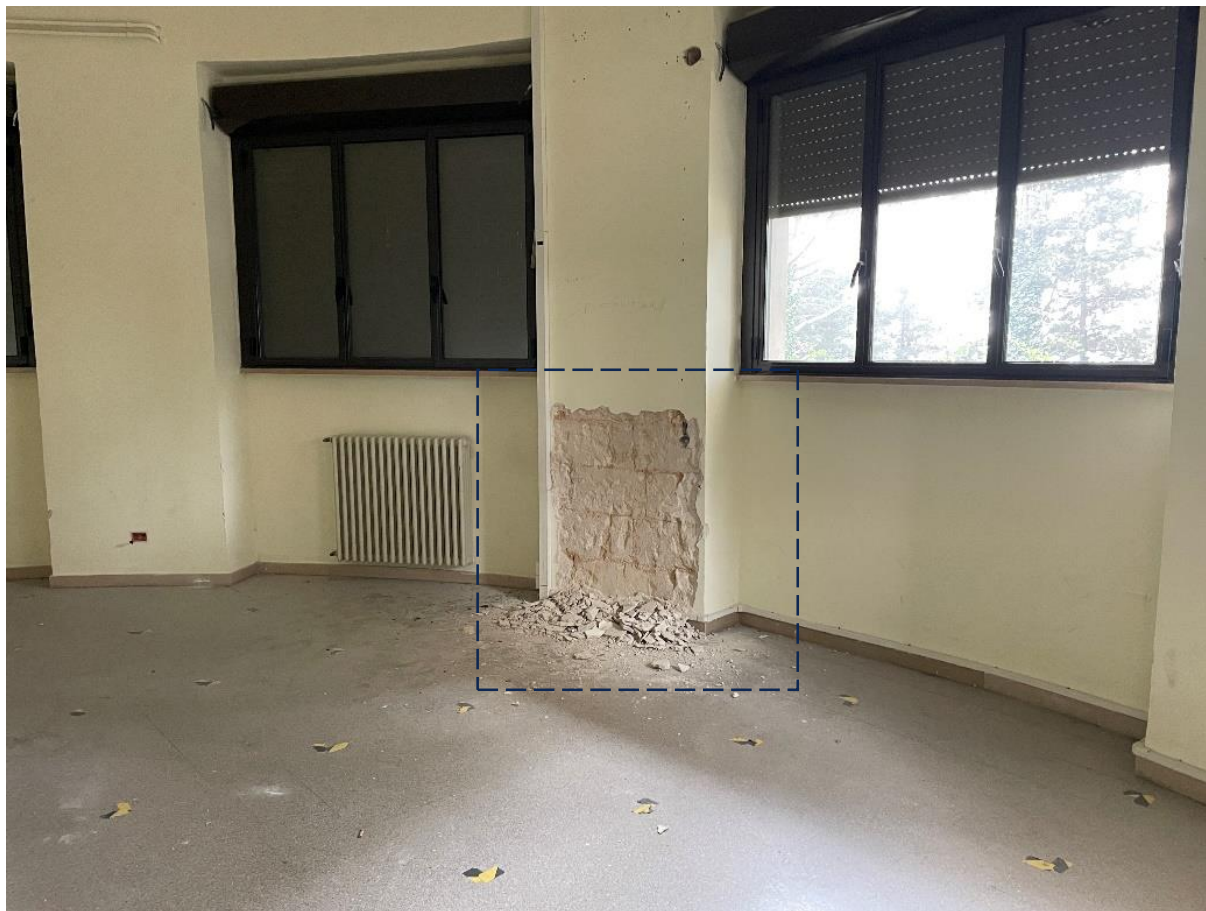
FIGURA 52: Saggio muratura portante in tufo
