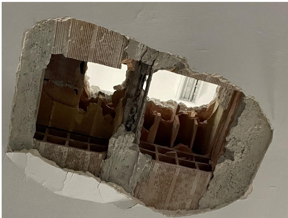
FIGURA 51: Saggio solaio piano terra
