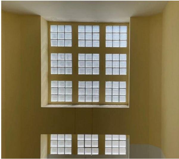
FIGURA 60: Vetromattone all'interno del vano scala
