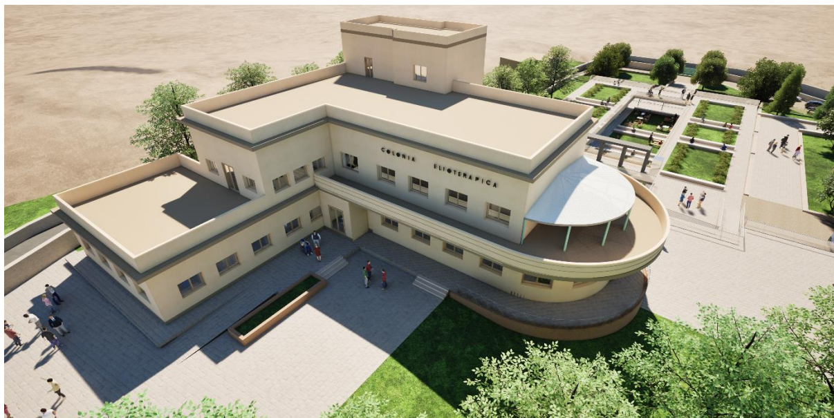
FIGURA 62: Ripristino della tettoia sul solarium
