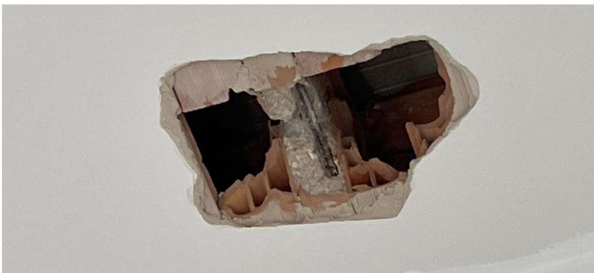
FIGURA 50: Saggio del solaio del primo piano
