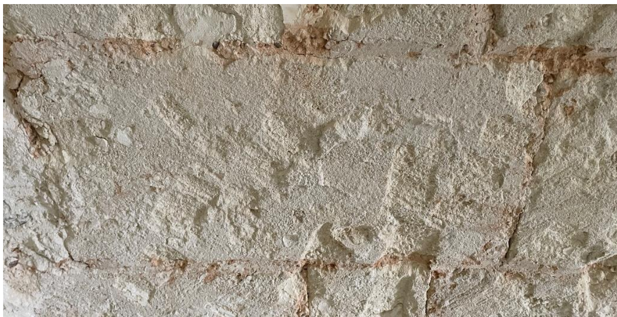
FIGURA 53: Particolare muratura portante
