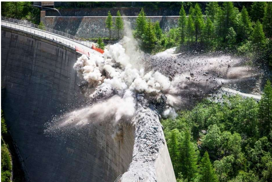
Figura 17: Esplosione di un conco di diga a Beauregard, documenti CVA
