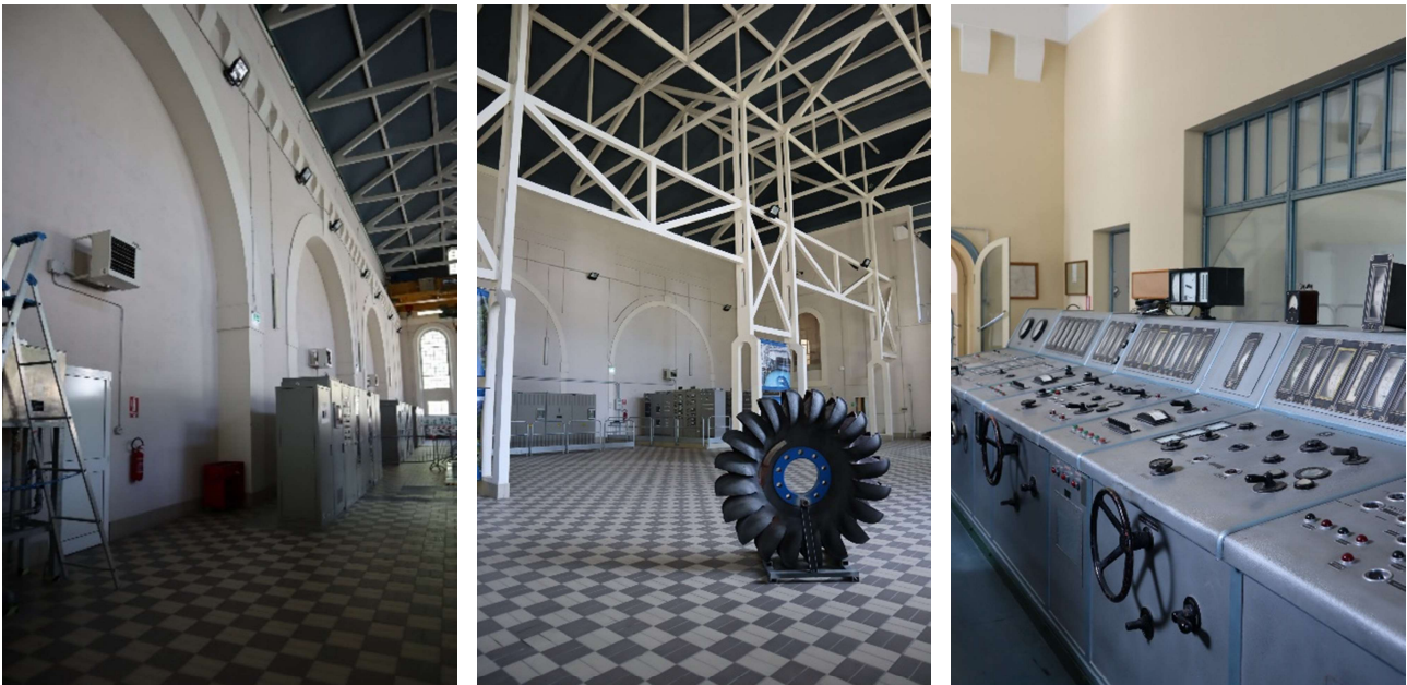
Figura 32: Vecchie aperture ad arco, sala mostre e vecchia sala di controllo della centrale di Maën, documenti dell'autore
