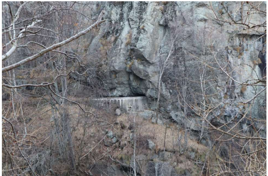
Figura 46: Porzione di canale passante all'interno della roccia, documento dell'autore
