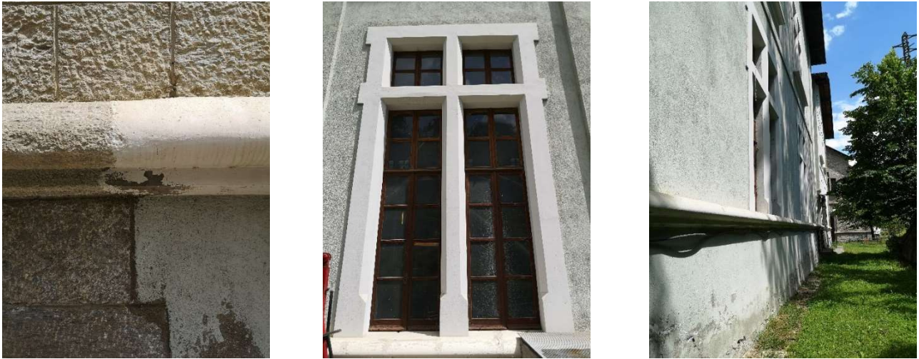
Figura 28: Passaggio da rivestimento in pietra a intonaco, vista di una finestra e vista del prospetto posteriore della Centrale di Champagne II, documenti dell'autore
