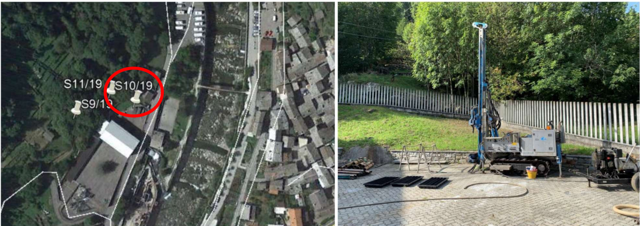
Figura 139: Carotaggi effettuati nel cortile della centrale esistente, documenti CVA
