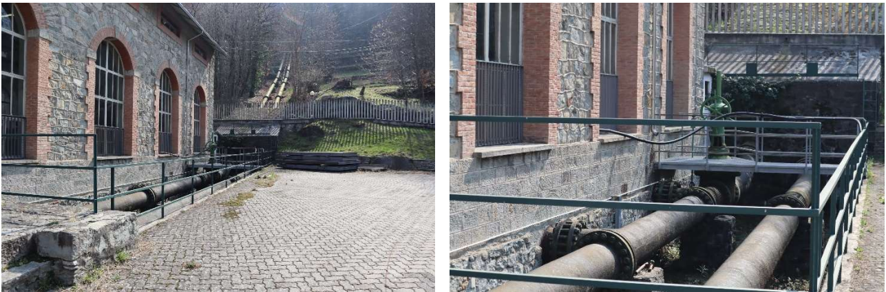
Figura 50: Tratto terminale delle condotte forzate, documenti dell'autore
