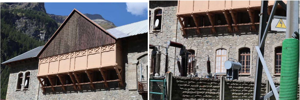
Figura 23: Parte a sbalzo e finta finestra della centrale di Gressoney, documento dell'autore
