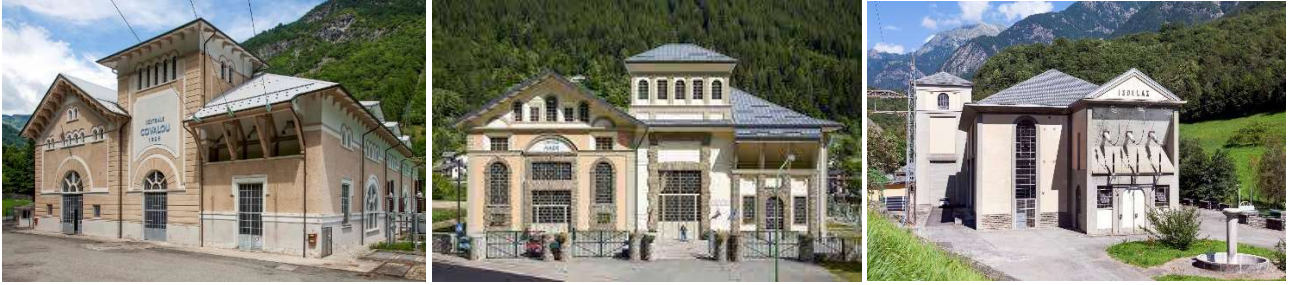
Figura 30: Centrali di Covalou (1926), Maën (1928) e Isollaz (1928), documenti CVA
