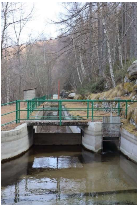
Figura 49: Dissabbiatore a sinistra e aerofori a destra, documenti dell'autore
