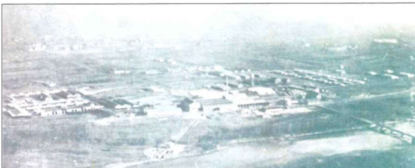
Figura 37: Stabilimento elettrochimico, Borgofranco, Centrale del Raffor - Comune di Hône
