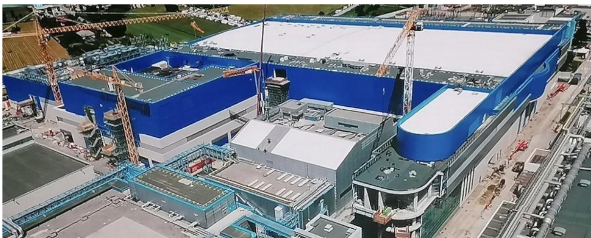
Figura 3: fotografia del cantiere di costruzione del nuovo stabilimento "R3" di STMicroelectronics S.p.A., sito ad Agrate Brianza (MB).
