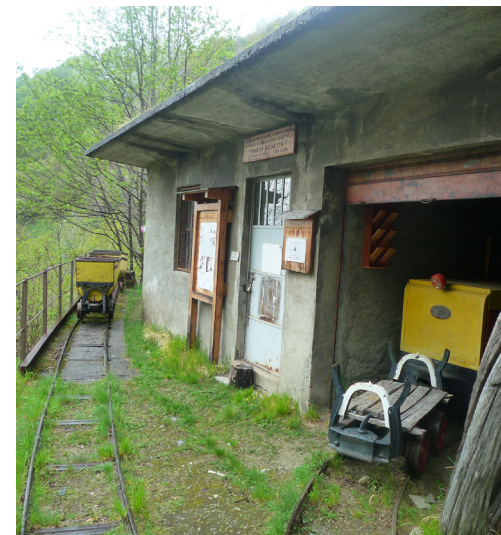
Esterno della miniera Brunetta, zona Cantoira Val Grande
