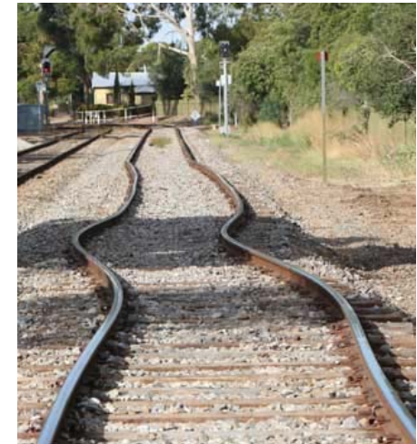
Instabilità di un binario innescata da alte Temp
