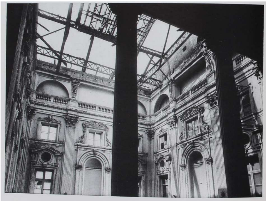
FIGURA 36. I DANNI PRODOTTI DAI BOMBARDAMENTI DEL 13 ALLA COPERTURA (SBAAP, ARCH. FOT.)
