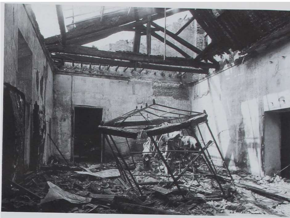
FIGURA 37. LA DISTRUZIONE DELLA COPERTURA NELLA ZONA MERIDIONALE DELL'ALA OTTOCENTESCA. (SBAAP, ARCH. FOT.)
