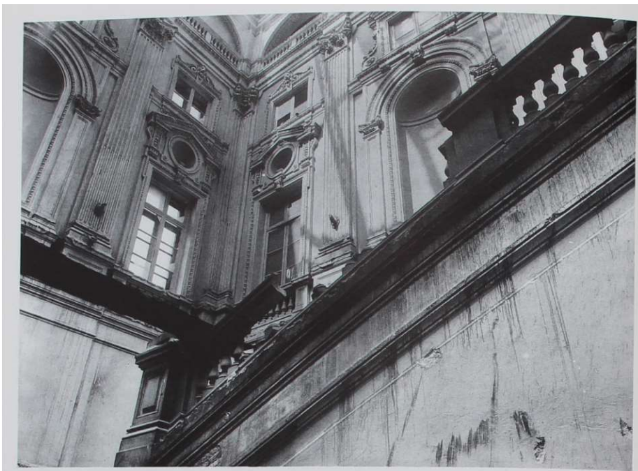
FIGURA 35. I DANNI PRODOTTI DAI BOMBARDAMENTI DEL 13 AGOSTO 1943 ALLE STRUTTURE DELLO SCALONE OTTOCENTESCO. (SBAAP, ARCH. FOT.)
