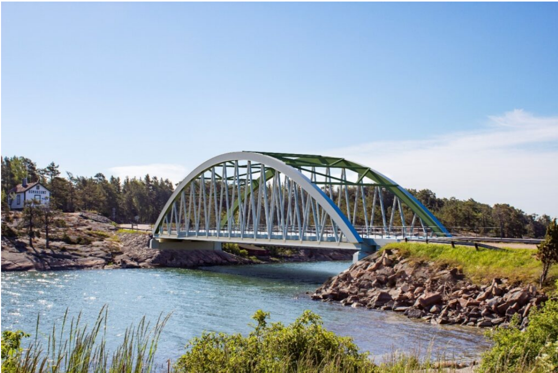
Figure 2.1: New constructed Bomarsund Bridge, adapted from "Lageralksro över Bomarsund på Åland", Stålbyggnad
