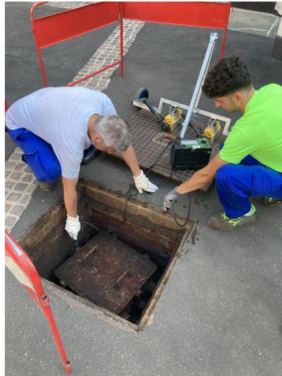
Figura 19: Verifica della Presenza di Tensione nella Botola
